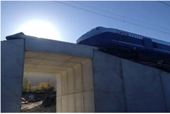
UALAND: Den nye kulvert er på plass, og dagen etter kunne toget igjen trygt passere.
