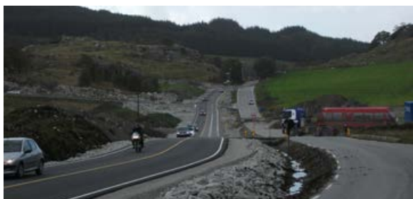
VS Stein VA og kulvert: Omkjøringsveg
