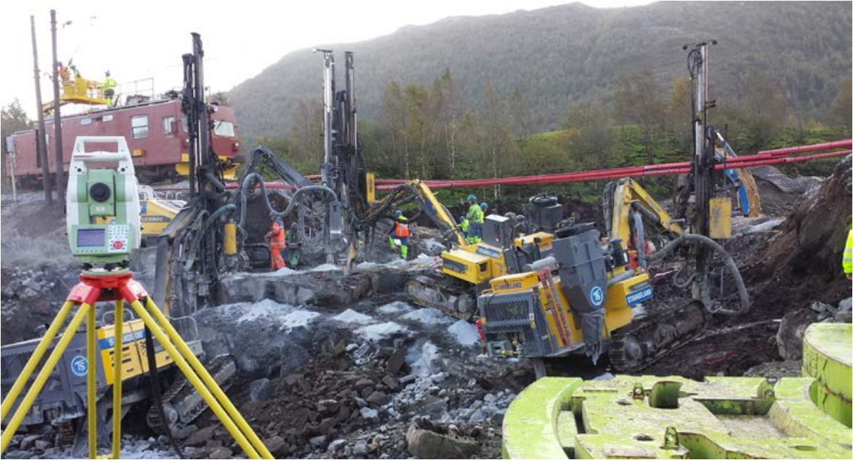
UALAND: Mange maskiner og mann i arbeid for å rekke alt på en helg.
