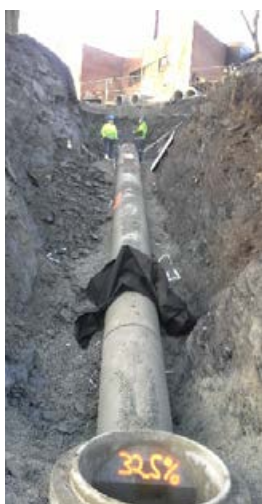
KUPPELHALLEN: Grøftene passerte en stupbratt fjellskråning.
