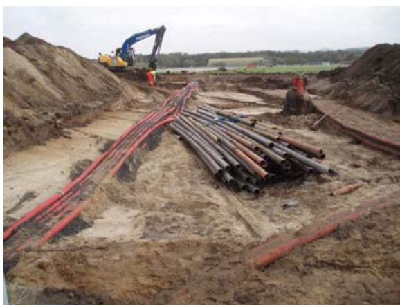
På flyplassen er det mange eksisterende kabler å ta hensyn til.
