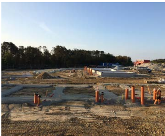
Asheimtunet – oppstart betongarbeid
