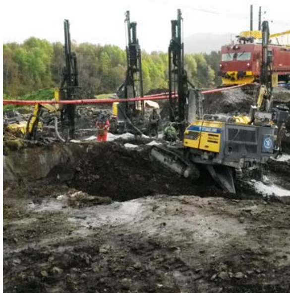
Det var fire borerigger i sving på Ualand.
