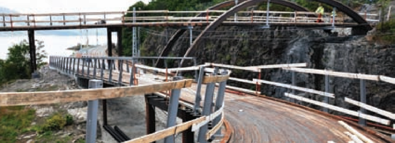
Fin detalj fra dobbeltsporet: Brobanen på den flotte spiralbroa i limtre på Solhøgda ble løftet på plass 17. april i år. Foto: Leif Emil Egeland
