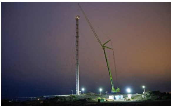
Her skifter vi ut flammearnet som er 124 m høyt og veier 7,2 tonn med vår 500 t kran.
