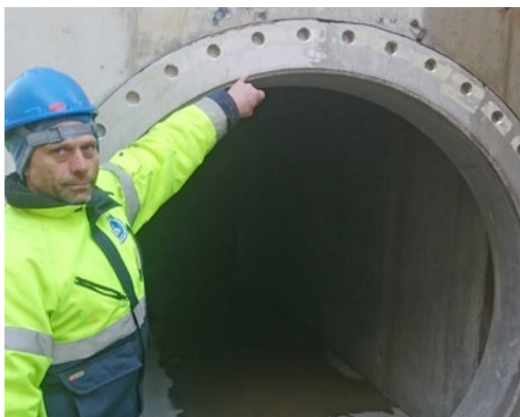
Store dimensjoner på Langevatn der Øyvind Knutsen viser hvor det skal måles på flensene av en 1400 mm rør.
