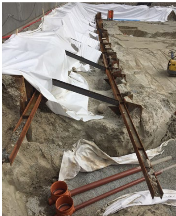
Rørsputt for bygg E
