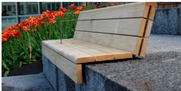
På torget i Stavanger har vi utført arbeid med belysning og møblering, arbeidet fortsetter til høsten med ferdigstilling av lys i renner og møblering
