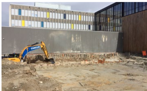
Utgraving og rørsputt bygg E
