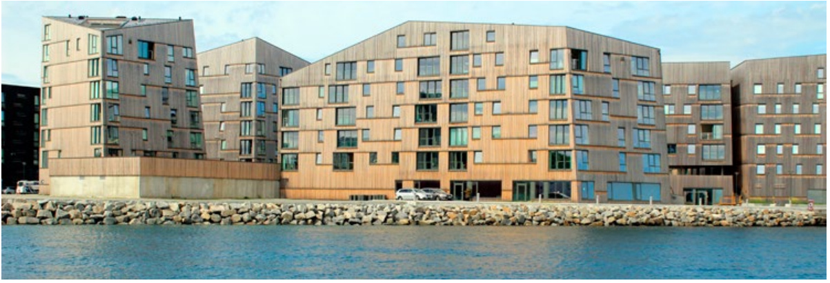
Ferdig utfyllt og plastret sjøfront i Lervig.
