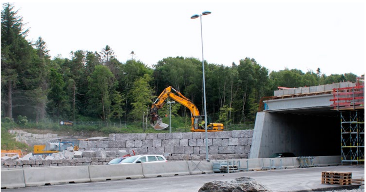
Borsheim er godt i gang med portalmuren til Miljøkulverten.
