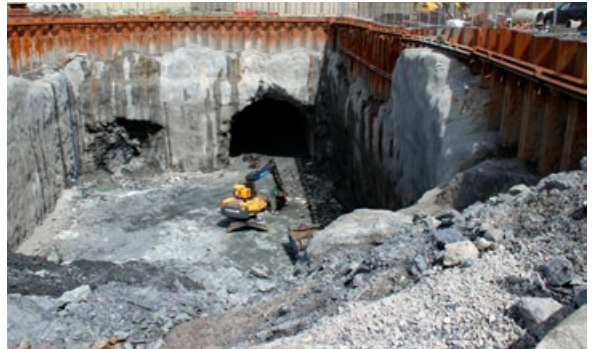
Tunnel for påkjøringsrampe i St. Svithun parken
