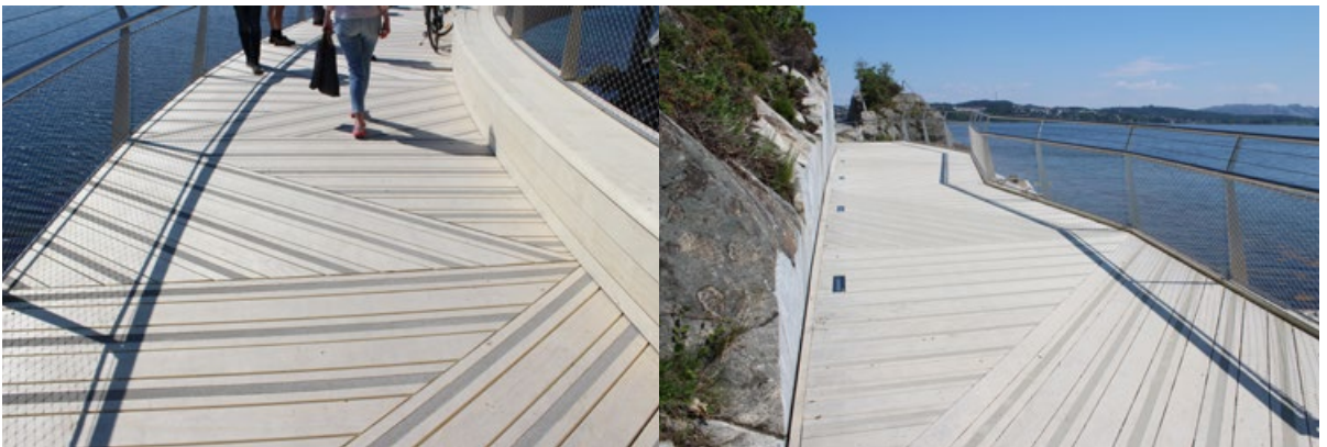
Broen med Acoya-tredekke og innfelt belysning
