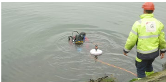
Arvid Walskaar gjør klar for dykking langs vannledning på Østhusvik, med prisme flytende i sjøen for innmåling.
