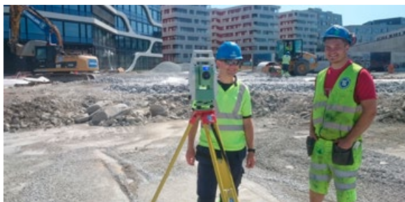
Reidar Bystøl og Steffen Holm gjør klart til innmåling og geometri-kontroll på Hinna Park.
