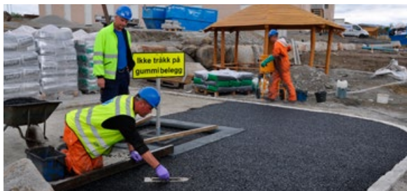
Helstøpt gummibelegg blir mer og mer brukt. Andreas og Detlef får arbeidet gjort, her i arbeid på Sørbø.
