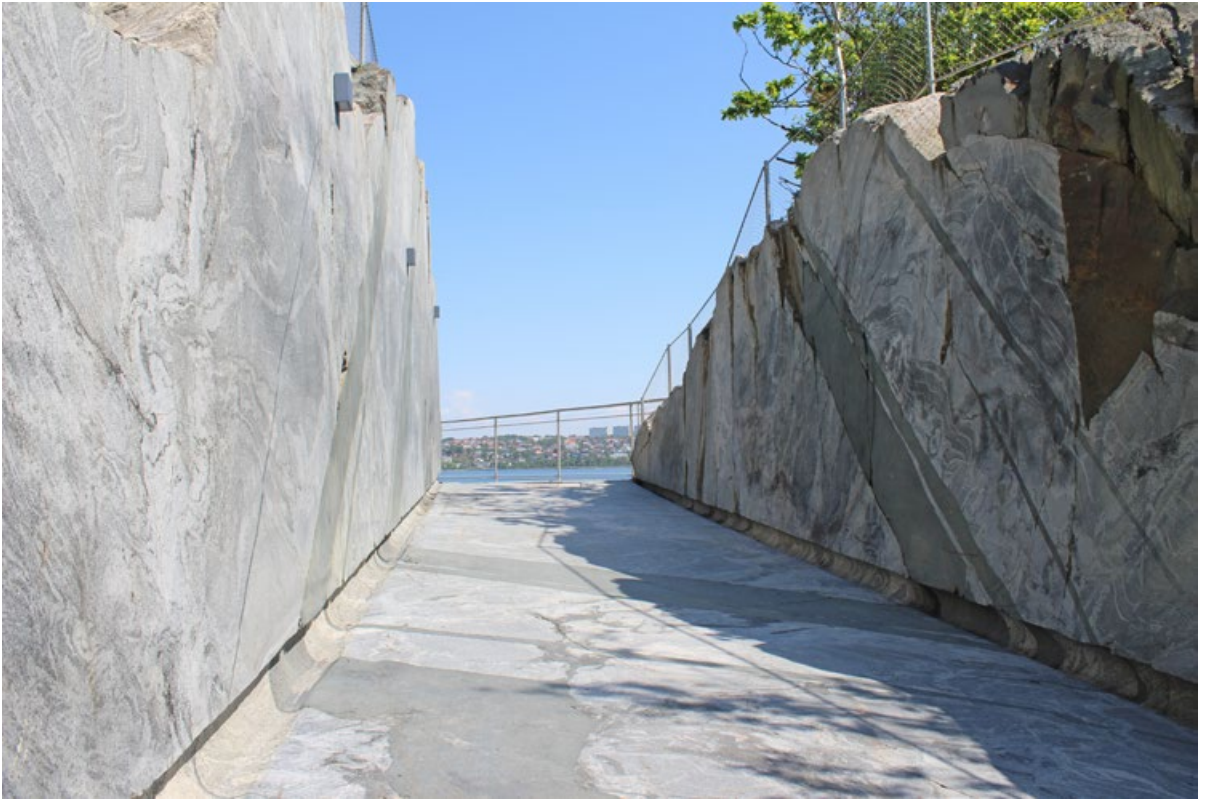
For å skåne terrenget rundt stien og lage en spesiell turopplevelse ble fjellskjæringen saget ut med wiresaging.
