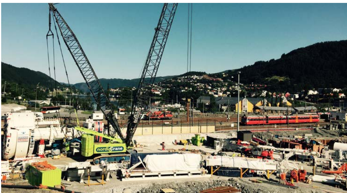
Vår 300t Liebherr kran som monterer fullprofilmaskin i Bergen.
