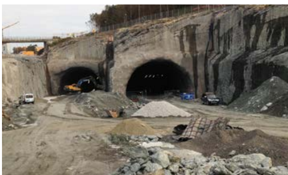
Hovedinngangen til Eiganestunnelen fra sør.
