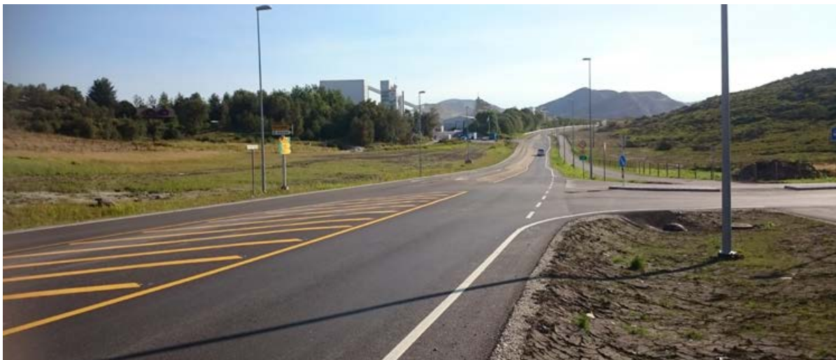
Flott ny Noredalsvei med gang- og sykkelveg og undergang for anleggstrafikk.
