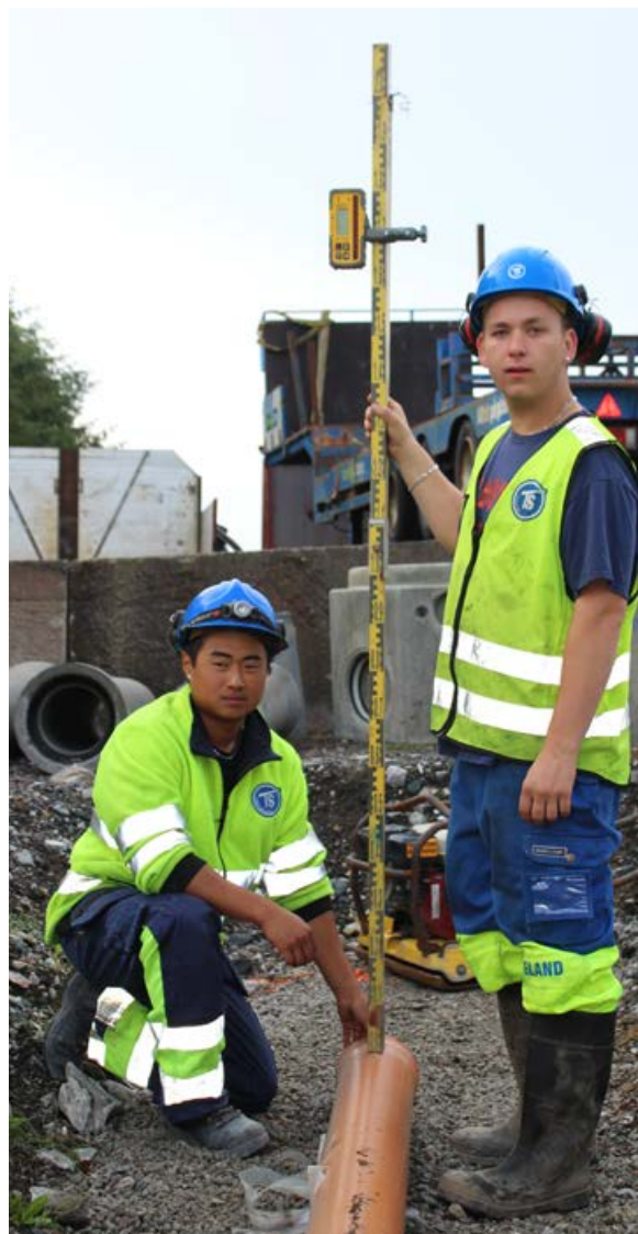
Lærlingene Simen Helleland og Tommy Waage Tengesdal øver seg på legging av rør. Begge to har tidligere vært utplassert hos oss, da er det ekstra stas at de søker seg tilbake som lærlinger.
