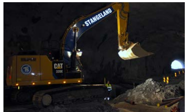
I tunnelen. Torstein Gjerdevik i gravemaskinen og håndmann Ronny Schulz i grøfta.
