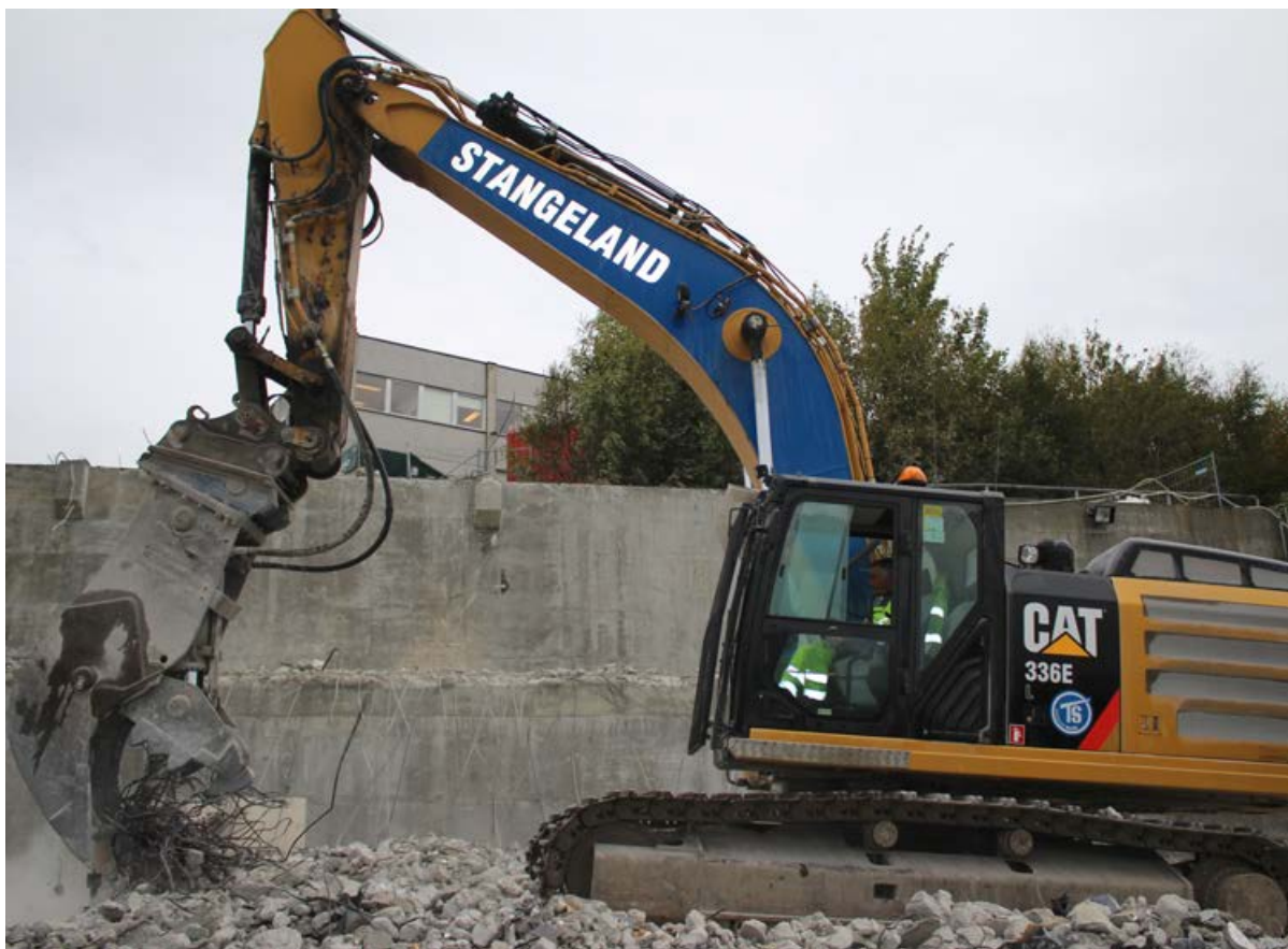
Ingvar Risa i gang med rivingen i Dusavigveien.
