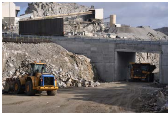
Kulvert under Noredalsveien til knuseverket.
