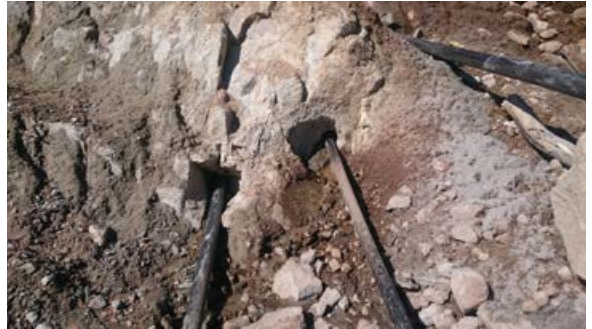
Boregrop på Suleskar. Her startet vi boringen og boret nedover.
