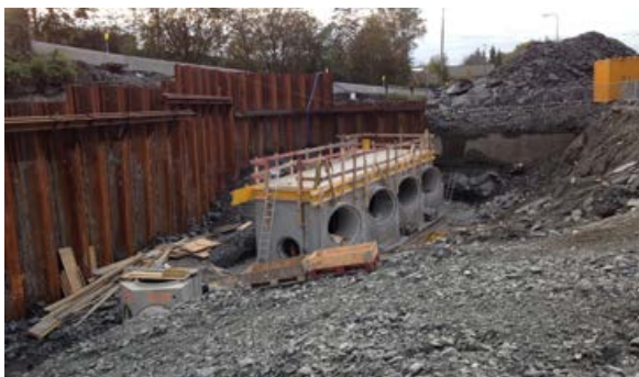
Samlekulvert på Schancheholen for dreng og overvann fra Eiganestunnelen.
