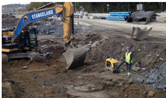
Thomas Schmidt i gang med VA-grøft Gamlingen. I gravemaskinen Ole Andre Risa.
