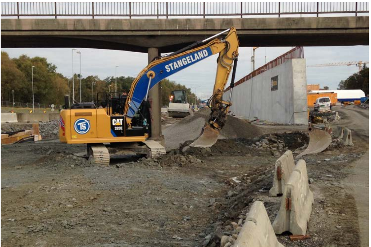
Johannes Vaage i maskinen. VA-grøft Schancheholen.
