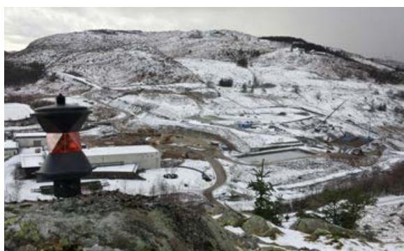
Etablering av fastmerker med oversikt over deler av anlegget på Langevatn.
