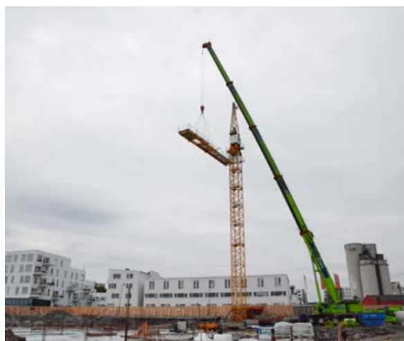
Denne 250-tonneren er i gang med å montere en byggekran.
