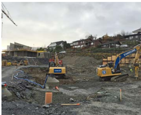
Grunnarbeid blokk BB4.
