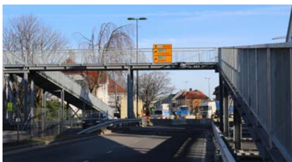
Den midlertidige gang- og sykkelbroen over Madlaveien ble åpnet før jul. (Alle foto: Kari Synnøve Vigre)
