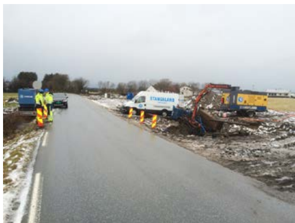
Boring under veg. Tore Obrestad og Tor Jone Aase.
