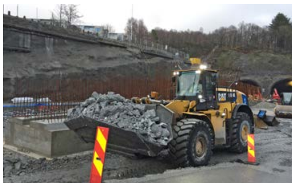
Ole M. Barka og Odd G. Dalane. CAT 980K rigget for tunnel.
