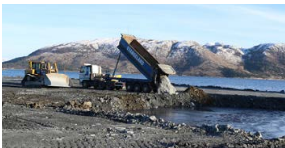
Jåttåvågen sjøfylling: Nærmere 25 000 billass med sprengstein er i skrivende stund brukt til utfyllingen av den gamle tørrdokka.
