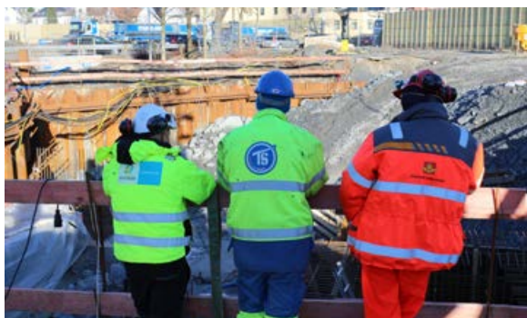
Schiøtzgården: Representanter fra Bilfinger Construction, Stangeland Maskin og Statens vegvesen diskuterer fremdriften i arbeidet. Vi ser St. Svithunparken i bakgrunnen.
