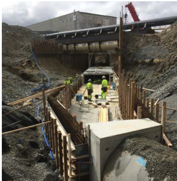
Kulvert på Langevatn.
