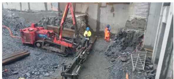
Stikker kontrollerer retning og fall før riggfører Rune Skretting og hjelpeemann Krzysztof Falkiewicz setter i gang.
