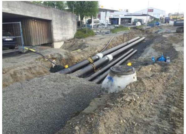
Fjernvarme og fjernkjølerør fra Lyse.
