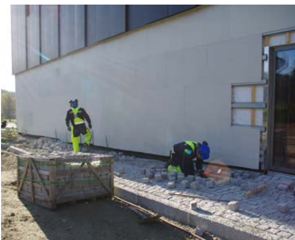
Setting av smågatestein, SV-bygget UiS.
