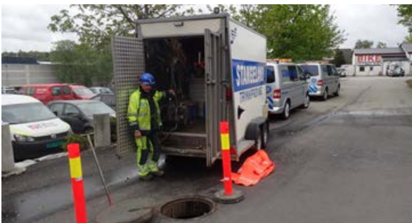
Trykkprøving og svamping, Ole Morten Helleland kontrollerer at rørene er rene og tette på Kvadrat.
