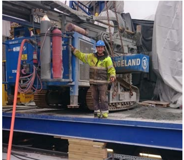
Her hadde vi inne mobilkran for å løfte riggen 20 cm slik at kunden kunne slide boredekk til ny posisjon for å bore hull nummer 2, Petter Refsland er godt fornøyd.
