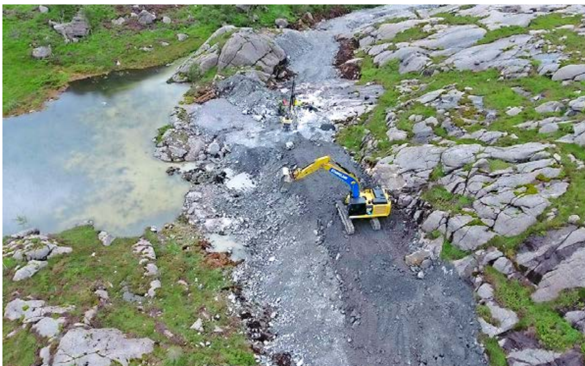
Bygging av vei 1-1 i park 1.
