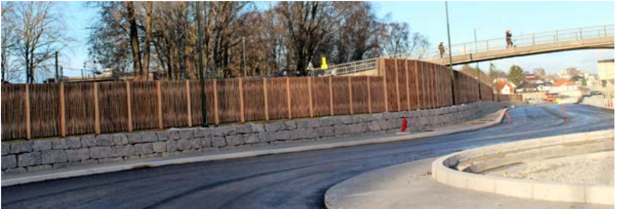
Piletreskjerm er montert langs Bokkaskogen.
