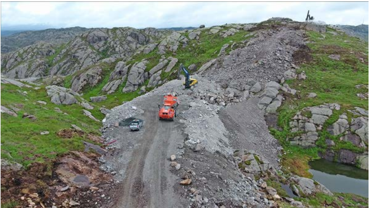
Fylling vei 2-1, boring på fundament 2-4 i park 2.
