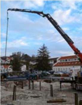
Heising og montering av stålkjerner.
