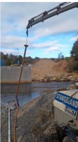
Setting av peler i vann med hjelp av dykkere.
