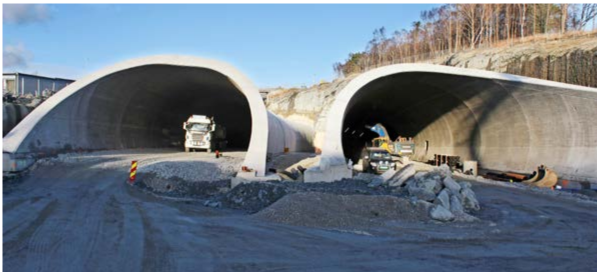
Portalene for Eiganestunnelen på Schancheholen.
