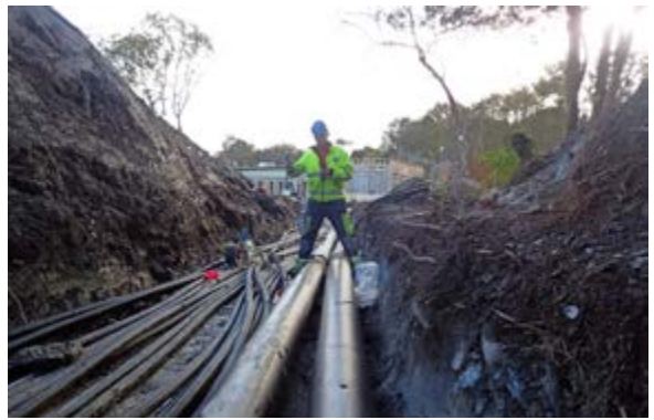
Andre Tesch driver elektrosvising av rør fra energibrønner på nye Gamlingen.
