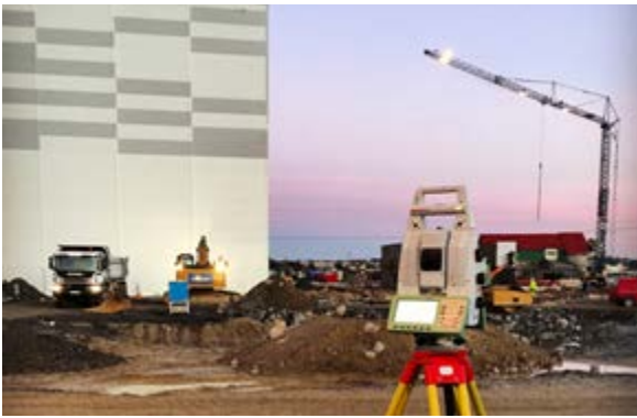
Et flott bilde tatt av Ann-Christin Egeland under stikningsarbeid på Vagle. Her har Rema- bygget blitt et landemerke.
