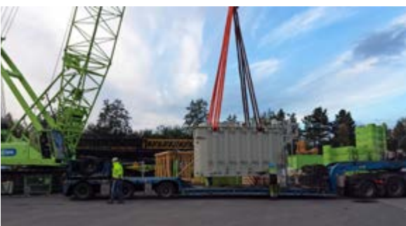
Omlasting av 50-tonns trafo. Kranfører Bjørn Våurm.
