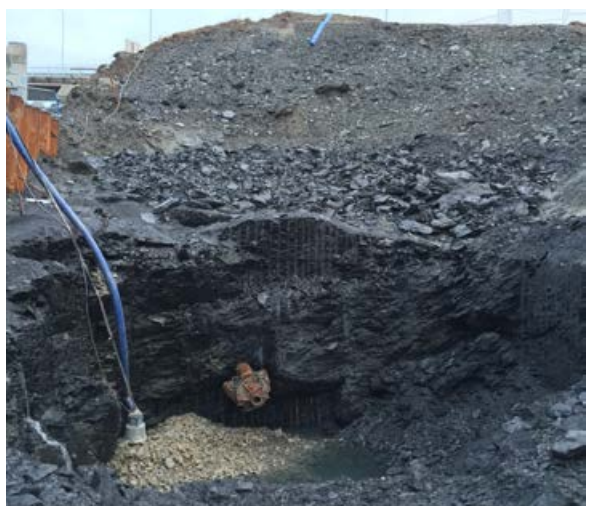
Start på grovhullsboring Ø1060 mm.
