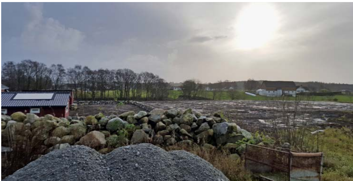
Ferdig fylling Skjæveland.
