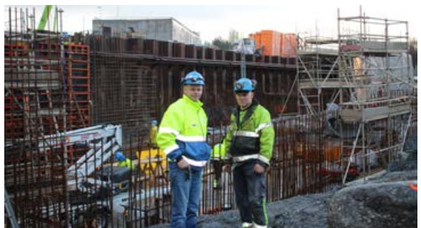
Anleggsleder Sigbjørn Tveiten og formann Peder Espedal foran K41 – betongkulvert Madlaveien.
