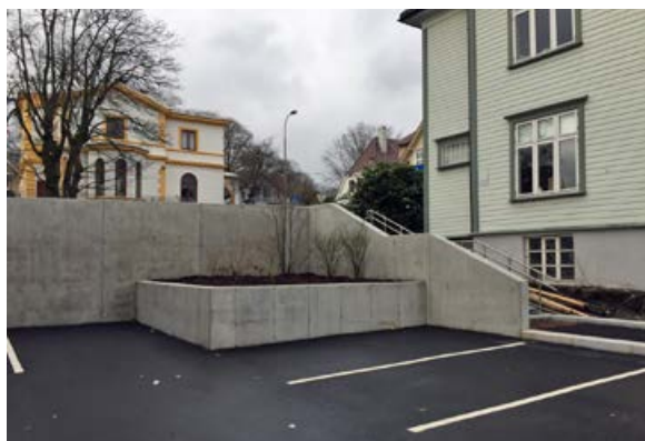
Ny trapp og bed på parkeringsplass St. Olav videregående skole.
