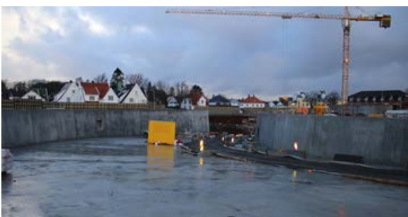
Nedkjøringsrampen til betongkulvert Madlaveien.
