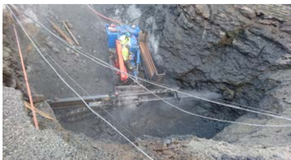
Fra den styrte boringen på prosjektet til Palmer Rørheim i Viste Hageby.
