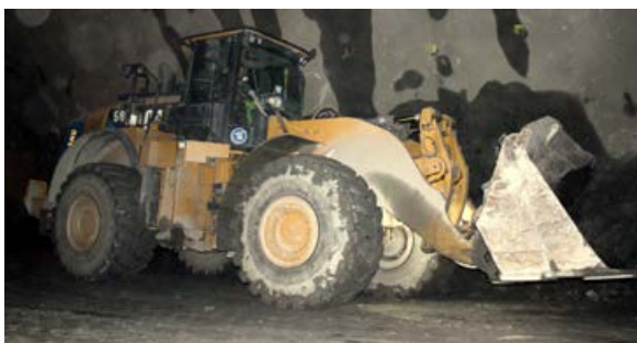
Eivind Skogerbø i lastemaskinen inne i tunnelen.
