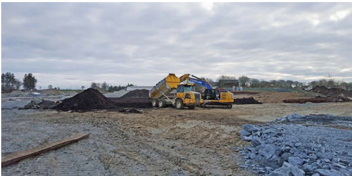
Gjennlegging fylling ved Grasrota.
