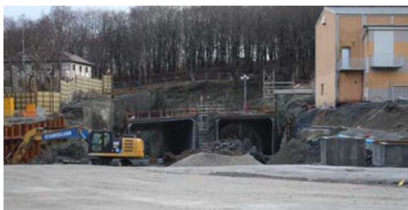
Starten på Hundvåg-tunnelen. Trafo-stasjonen i Stavanger til høyre. Ole Andre Risa i gravemaskinen
