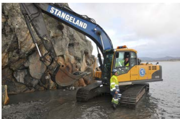
Pål Bore i gravemaskinen og Kent Jone Kydland i vannet.
