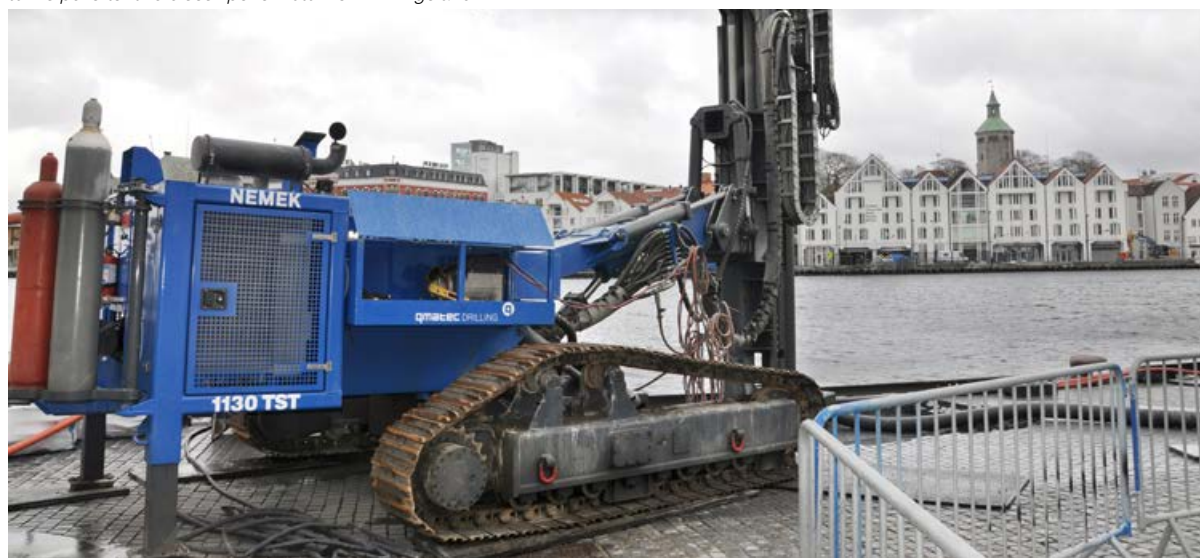
Boring for stålkjernepeler på Skagen i Stavanger. Oppdrag for Birken & Co. Byggherre Stavanger Havnevesen. Hensikten er å lage nye 200 tonns pullerter til cruiseskipene. Foto: Leif Emil Egeland.
