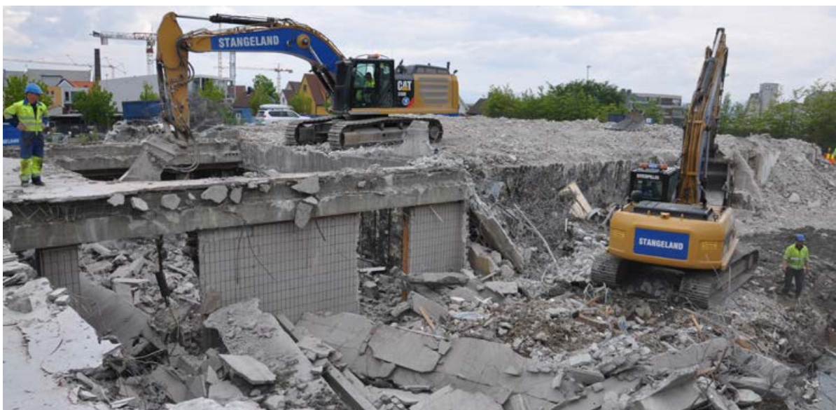
Rivning og saneringsarbeider har blitt en viktig og stor nisje i vår produksjon med spesialutstyr av alle slag. Her er vi i gang med et stort riveprosjekt for Haugesundsgaten Eiendom – K2 v / Pål Njærheim. Det er Jan Erik Ånestad som er anleggsleder på jobben med Traand Meland som driftsleder. Vi har her også fått oppdraget med å utføre grunnarbeidene for K2. Foto og bildetekst: Leif Emil Egeland.
