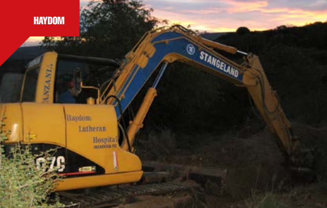
Haydom-gravemaskinen i arbeid med 1 mil med vannledningsgrøft.
