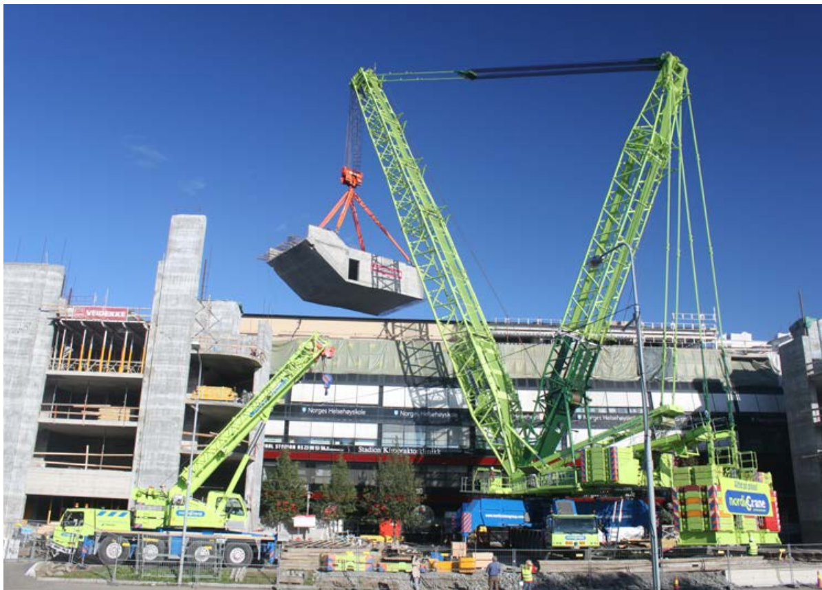
Liebherr LG 1750 Løfter en gangbro på 240 tonn på Ullevål Stadion . Oppdragsgiver Veidekke Entreprenør.
