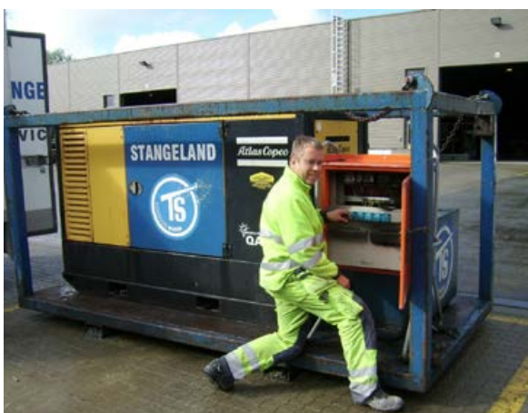
Elektriker Jarle Lillebø – Fiks av strømskap, døren har ikke blitt lukket slik regnvann er kommet inn i skapet med utfall i kortslutning og brente sikringer som konsekvens.
