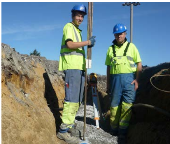
Fra venstre: Ådne Sele får kyndig veiledning i rørlegging av Jan Oaland. Her fra legging av duktile vannrør til nybygget for Nordic Crane på Soma.
