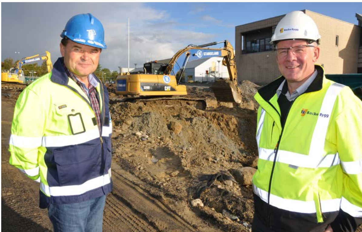
Sørbo skole – Stor utvidelse av skolen er nødvendig på grunn av den store boligutbyggingen i området.
