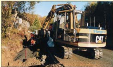
Arbeid i gang på Godeset med 145 kv kabel for Lysse Nett fra Forus til Mariemarka.
