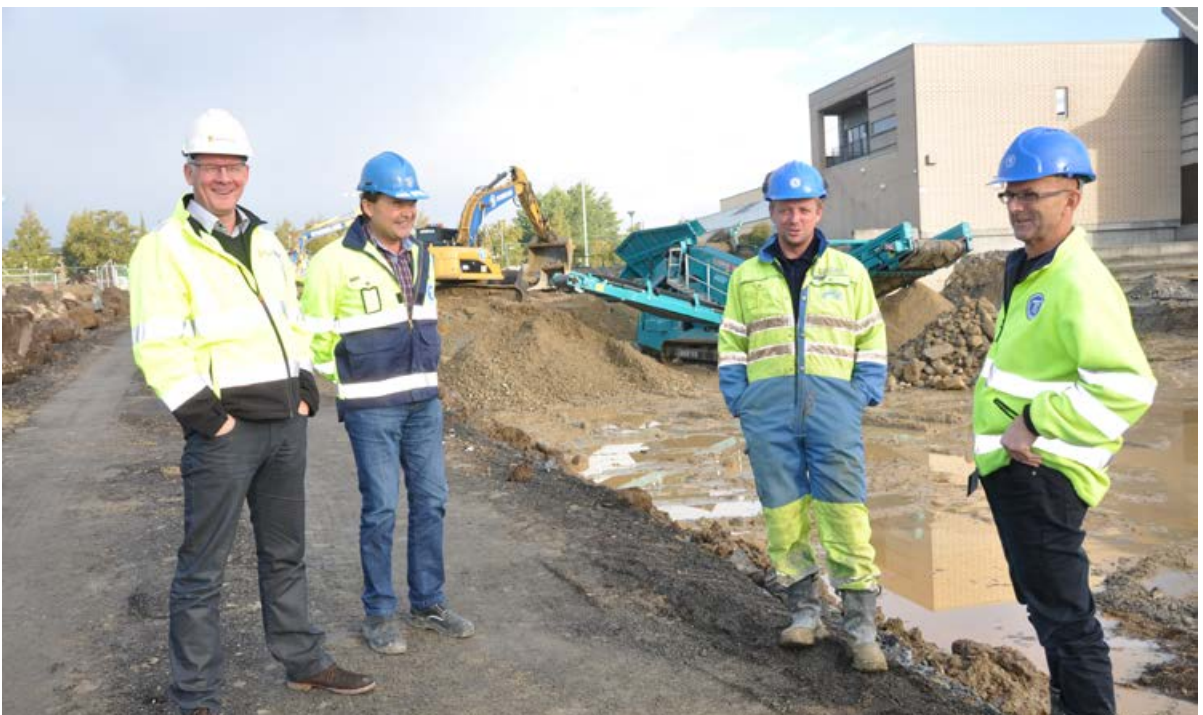
Samarbeid på alle plan er alfa omega for at prosessene skal gå bra! Det er kostbart å transportere masse til tipper. – Det er og dyrt å drive tipper. Her sorterer vi ut all stein i massene. Steinen brukes på anlegget til oppfylling, mens den dårlige finmassen transporteres til tipp. Sorteringen utføres med maskin og powerscreen. Driftsleder pukkverk, Arve Vold, og formann transport, Henrik Torland, er viktige lagspillere.
