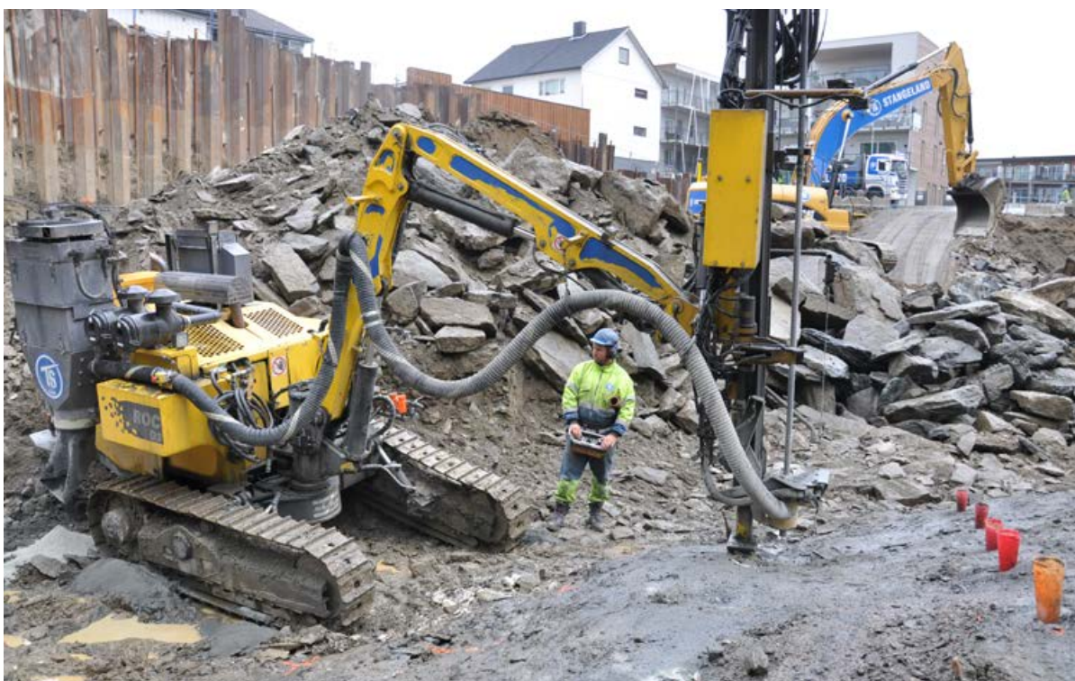
Boring, sprengning og grunnarbeider for Klepps nye høyhus. – Trio Heradshuset.
