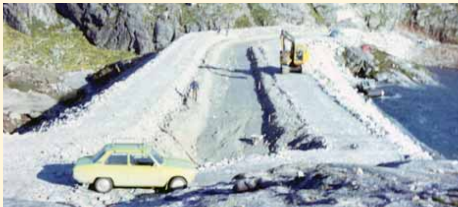
Oppbygging av dam Nord som var den minste dammen på anlegget.
