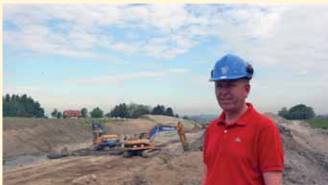
Inspeksjon av veibygging.
