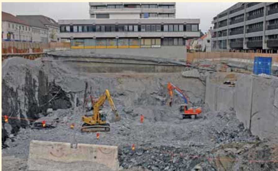
P. Kyrre-parkeringsanlegg for Stavanger Parkering – Stavanger kommune er Stavangers dypeste bygge-grop utført av dyktige folk fra bl.a TS-sprengningsavdeling – uten uhell.
