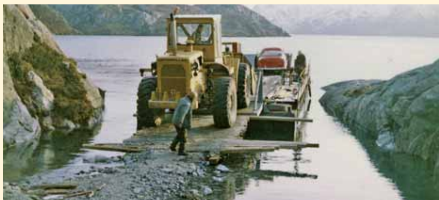
Alle maskiner måtte fraktes med plass bygd ferge med påhengs til dam Håheller. Her fraktet vi og all filter og morene masse på lastebiler over vannet. Da vannet var regulert måtte vi flytte kaien mange ganger iløpet av sesongen.
