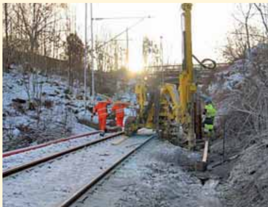
Boring av foringsrør til sikringsgjerde mot eksisterende spor. Togfri helg 27-28 januar
