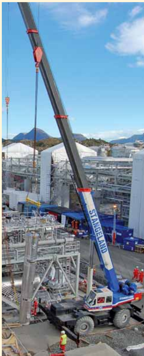
Arbeid på Ormen Lange
