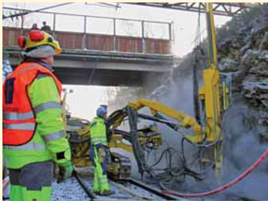
Boring av foringsrør til sikringsgjerde mot eksisterende spor. Togfri helg 27-28 januar
