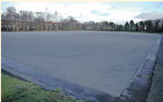
Vaulenbanen klar for kunstgress. Nok en bane har vi "bygget opp" og gjort klar for kunstgress. Foto: Leif Emil Egeland.
