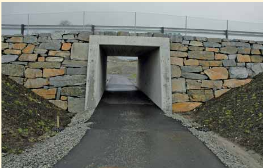
Flott mur på undergangen Rv. 44
