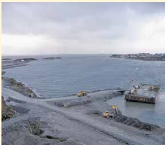
Tipping i sjø fra land og fra flåte.
