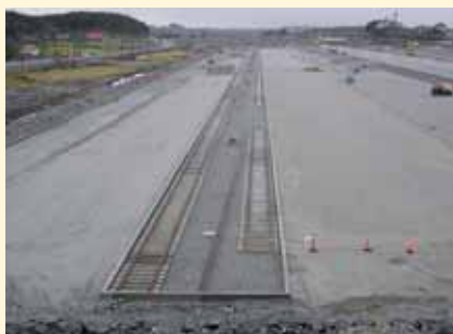
Fra lastegaten med påbegynt sporlegging.
