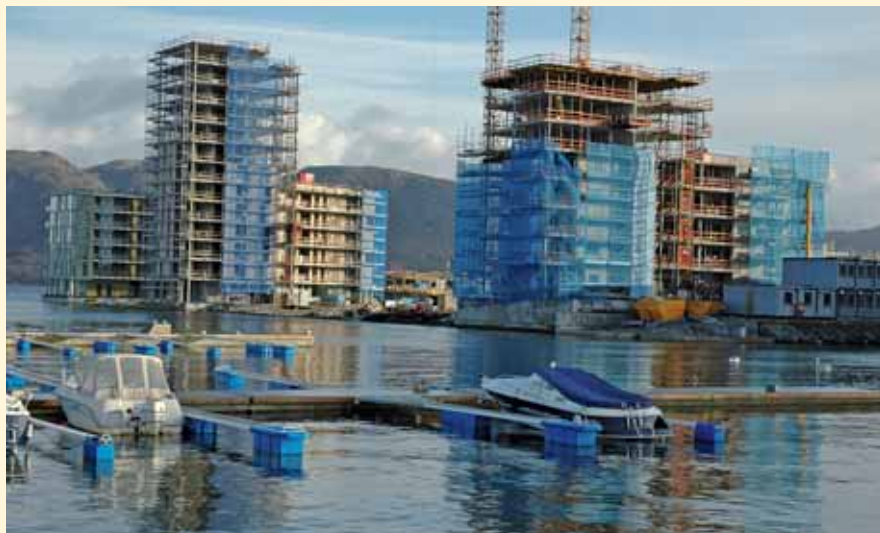
Hinna Brygge har fått en flott beliggenhet ved sjøkanten.
