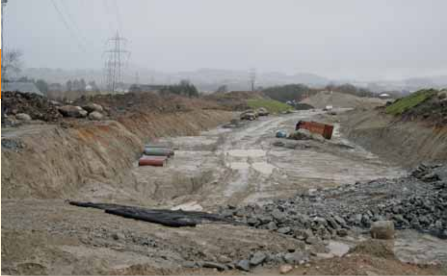
Ferdig utlasta veglinje mellom Årsvollvegen og Sandnesvegen.
