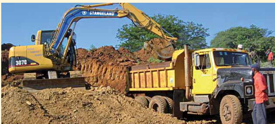
Entreprenør-avdeling med godt utstyr.
