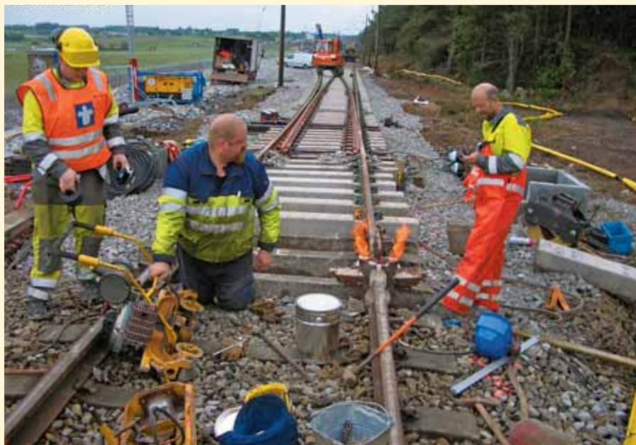
Sveising av skinner i forbindelse med montering av ny sporveksler.
