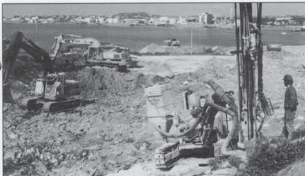
120.000 m 3 fjell har vi sprengt ut for å lage kai- og havneanlegget
