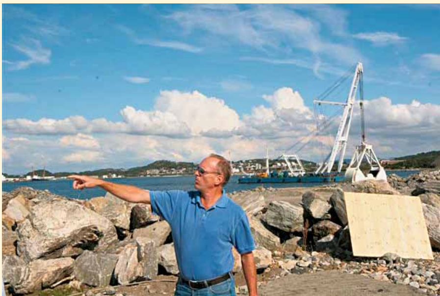
Anleggsleder Bjørn Solvig foretter med stor innlevelse. Mudringsfartøyet i bakgrunnen.
