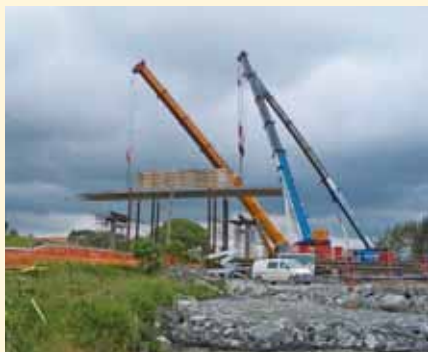
Heising av Gang og Sykkelbro over eksisterende jernbanespor
