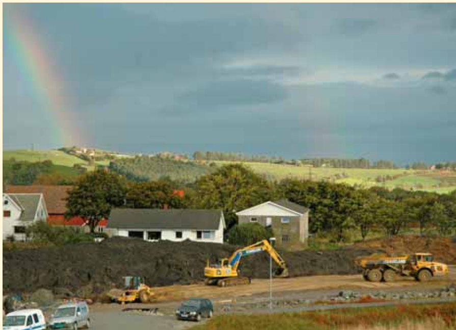
Masseutskifting på Rv. 44 etappe 3. Foto: Leif Egeland.
