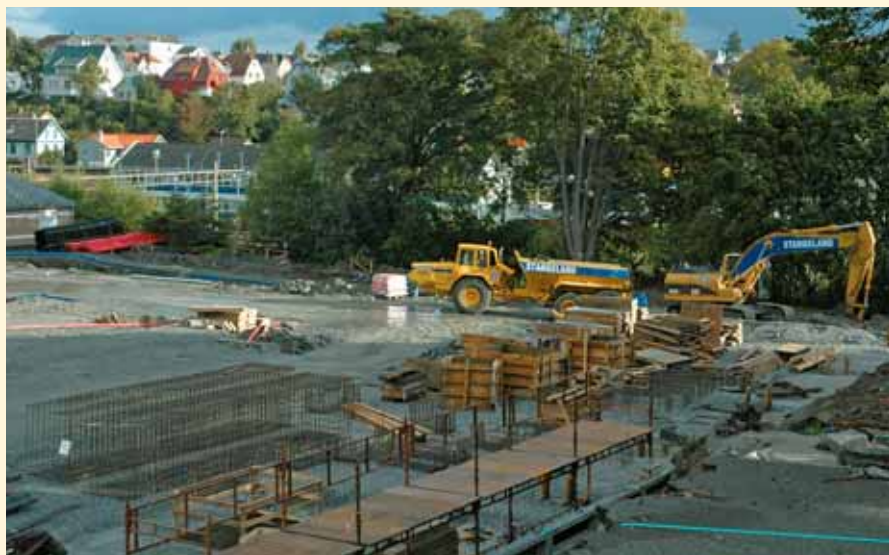
Grunnarbeidene er godt i gang for Skattens hus på Lagårdsveien. Foto: Leif Egeland
