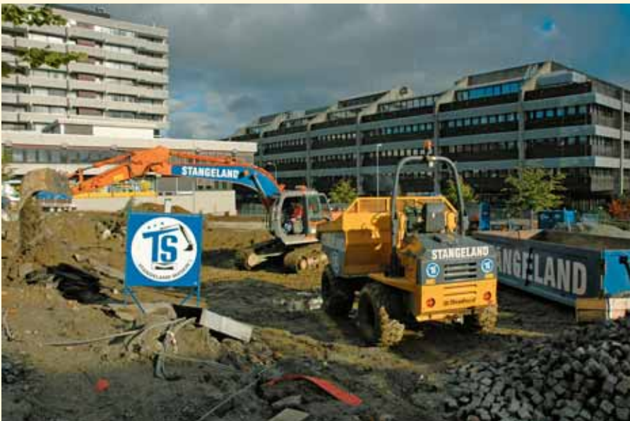
Grunnarbeider for «P-Kyrre». Parkeringsanlegget sprenges 20 meter ned. Rådhuset i bakgrunnen.
