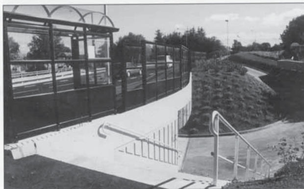
Undergang, støyvegger, busskur – alt i ekte TS-kvalitet..
