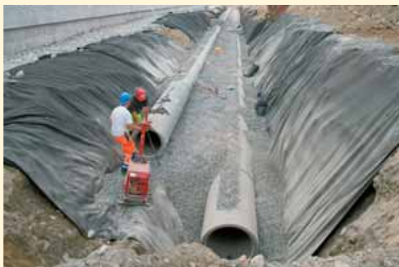
Lange strekk med store grøfter, dette ledningstrekket er 600 meter langt.
