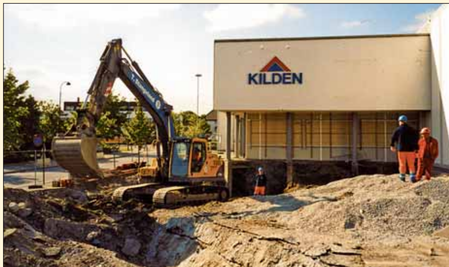
T.S. har grunnarbeidet for Block Berge Bygg på den store utvidelsen av kjøpesenteret Kilden.
