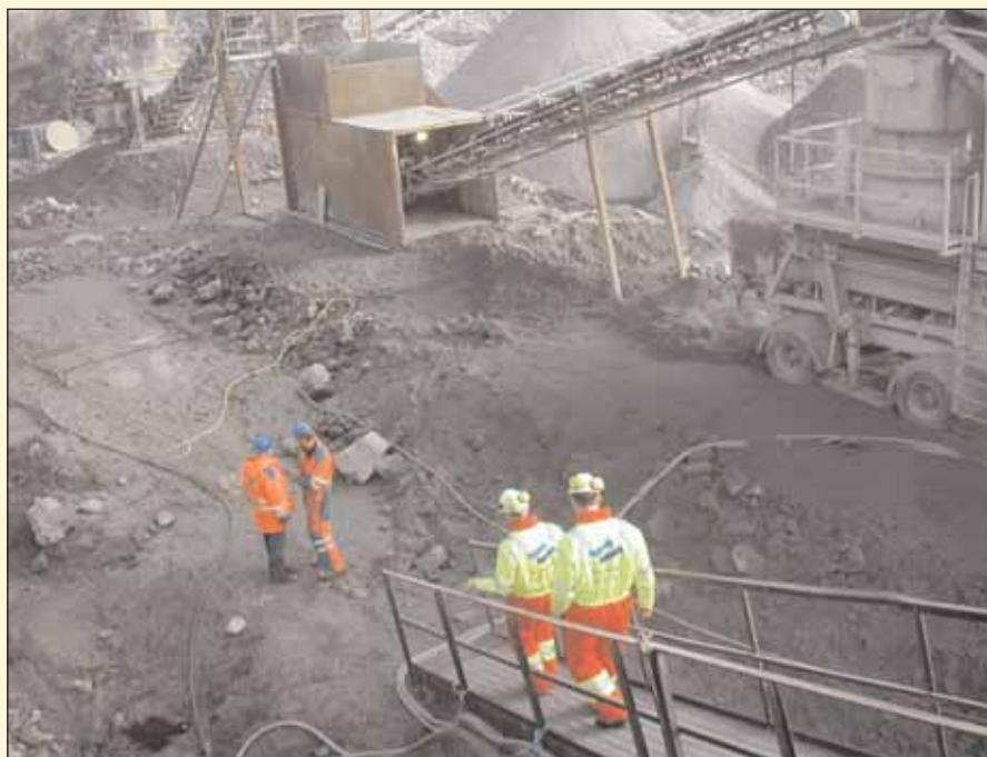
Vernerunde i pukkverket
