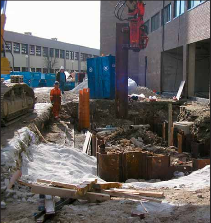
Her i oppdrag for Kruse Smith i Havnegaten på Sandnes, hvor det skal monteres nedgravde søppelcontainere.
