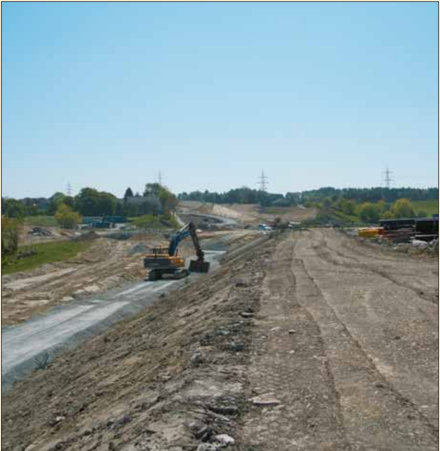
Biletet viser utlegging av bærelaget på G/S vegen (Foto Jan Olav Djuvsland)
