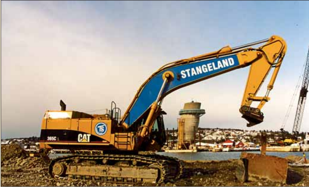
Dypkomprimering på tomten til boligprosjektet Fjordspeilet for Skanska.
