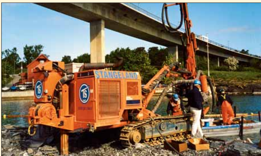
Selvsagt var det vår eminente sprengningsbas Dagfinn Frafjord som fekk ansvaret for undervannsprengning på Marinaen.
