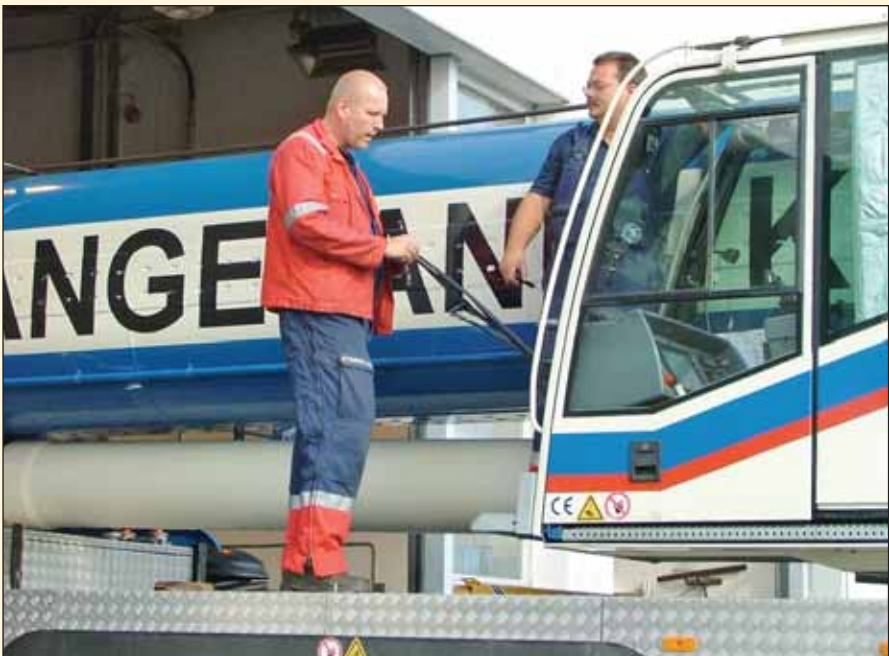
Robert Ridders og Hermod Hansen ser til at kranen er klar for prosjektet på Hydro Rafnes.
