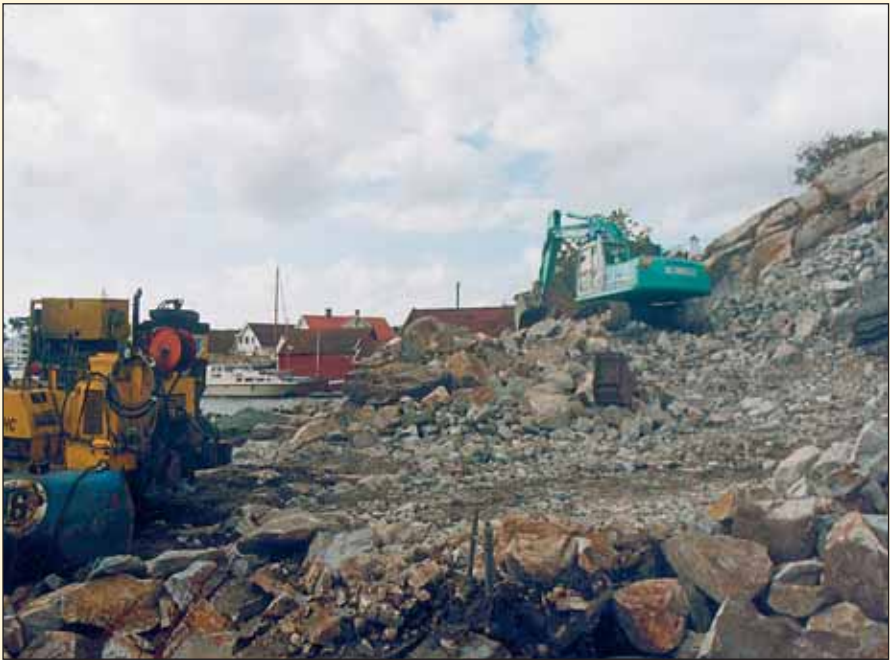
Maskiner og borrhigg i arbeid på tomta til Terje Nymann i Tananger (Havn). Foto: Leif Egeland.
