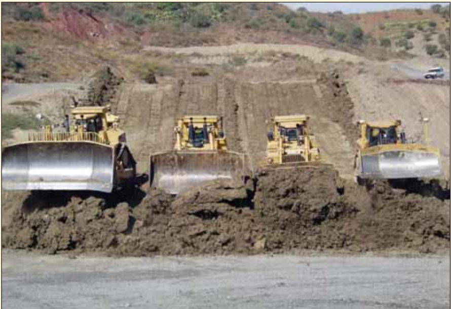
Flott skue da dozerne fra Cat D11 til Cat D6 skjøv enorme mengder masse i «samdrift»
