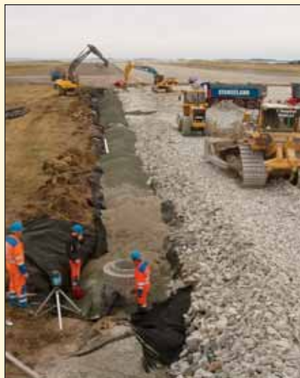
Drenering og masseutskifting side om side.
