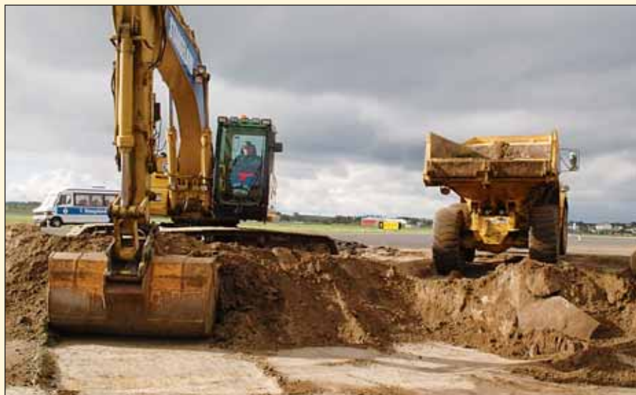
Drenering og masseutskifting side om side.
