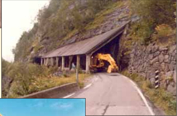
Måtte belte gjennom tunnelene.
