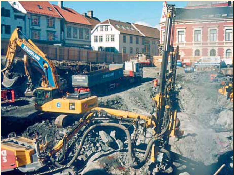
Grunnarbeidene på boligprosjektet Holmen for BO 1 har vore en tøff oppgave midt i Stavanger. Tre borrygger har vore i gang samtidig og det har vore stor aktivitet med spunting, sprengning etc.
