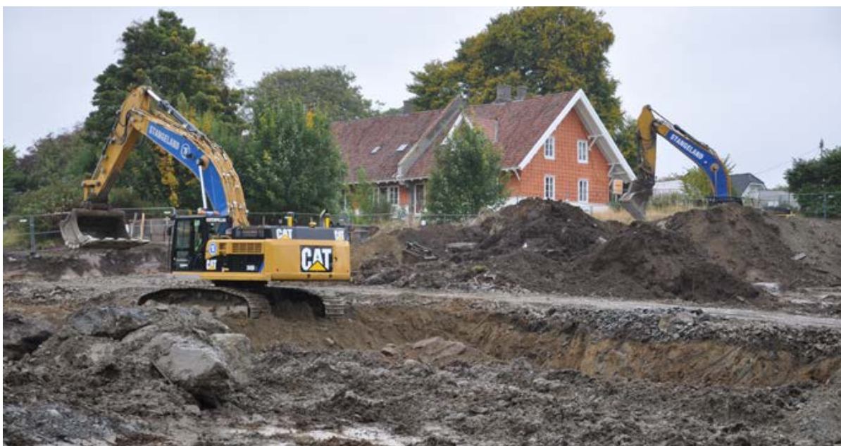
Dårlige masser og mye sikringsarbeid må til på Holmegeenes. Foto: Leif Emil Egeland.
