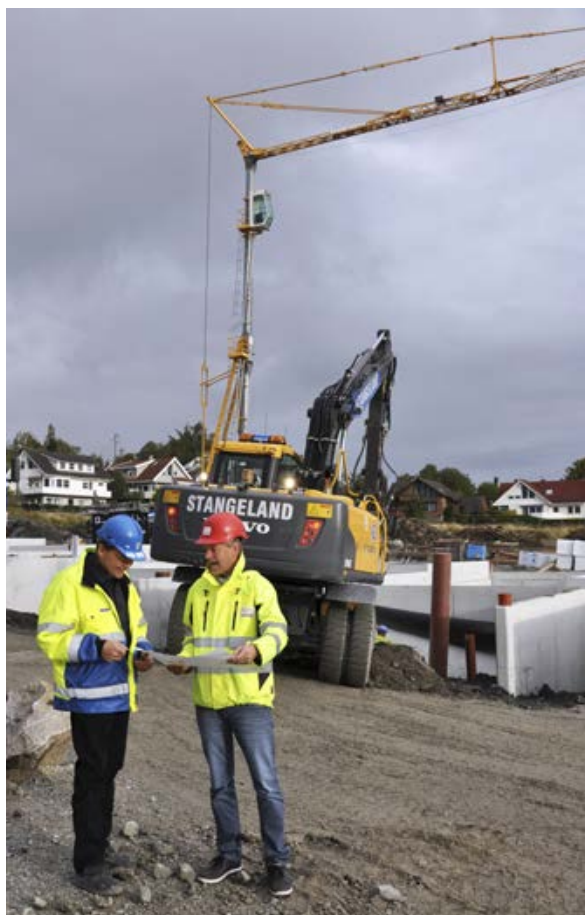
Sandved felt 2, 63 boliger i gang med grunn- og betongarbeider.
