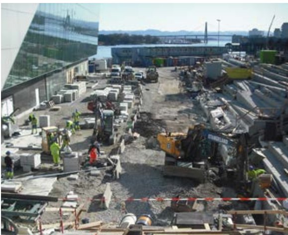
Legging av granitt og montering av slissrenne på festplassen. (Hovedinngang konserthuset).
