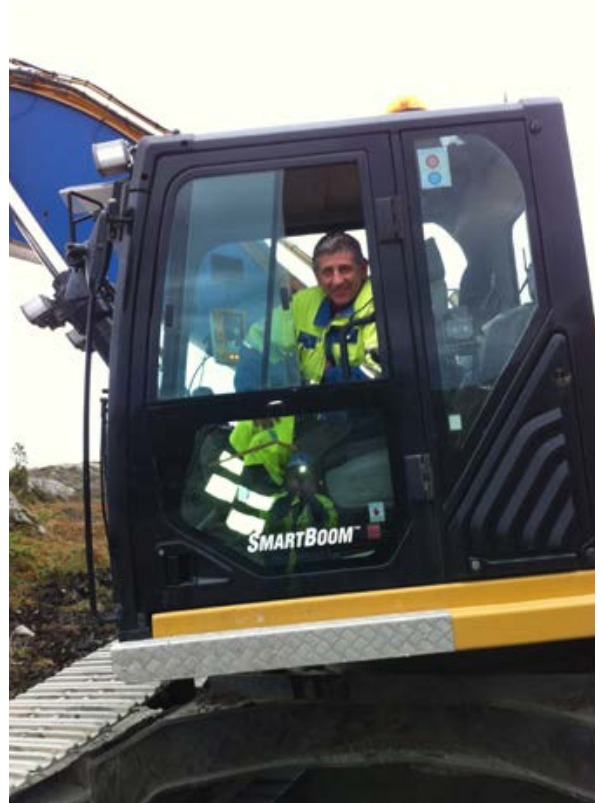
Driftsleder Kenneth Hodne har god kontroll med arbeidene.
