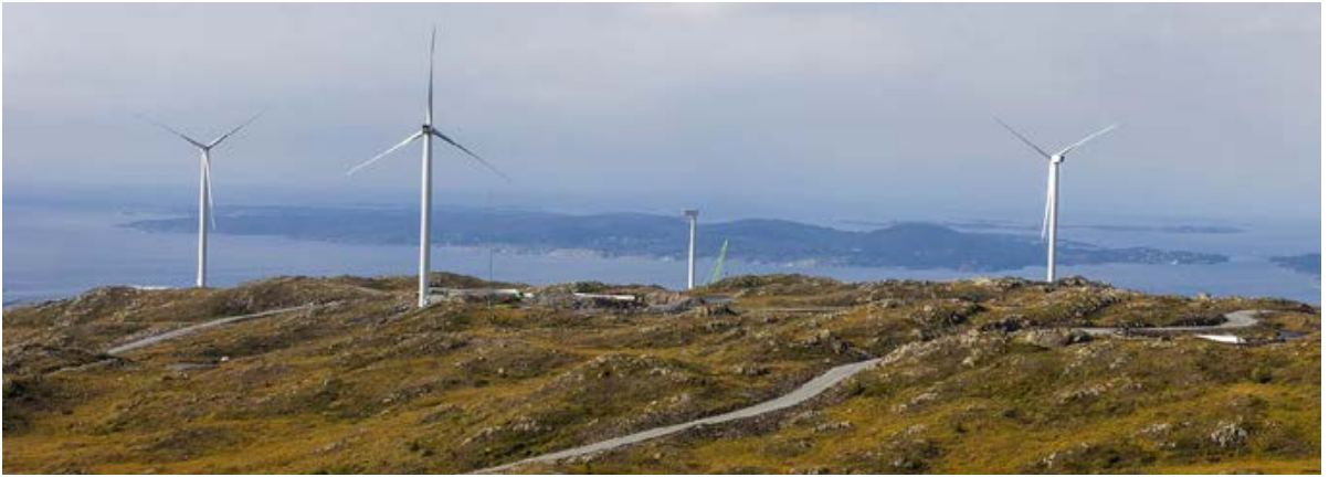
Vindmøllene reiser seg og veiene glir fint inn i terrenget.
