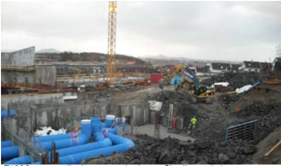
Ø1000 mm ventilasjonsrør under bygg. Skadberg skole.
