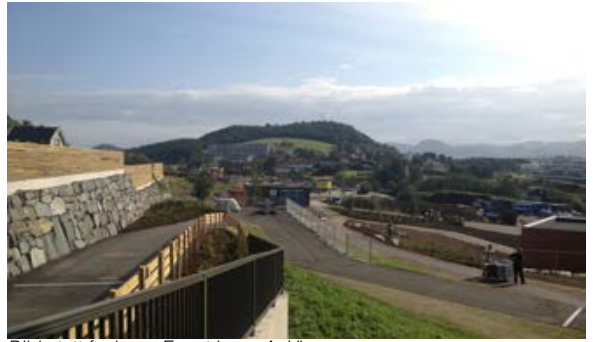
Bilde tatt fra bygg E mot bygg A. Viser gangvei trasé og grøntområde.
