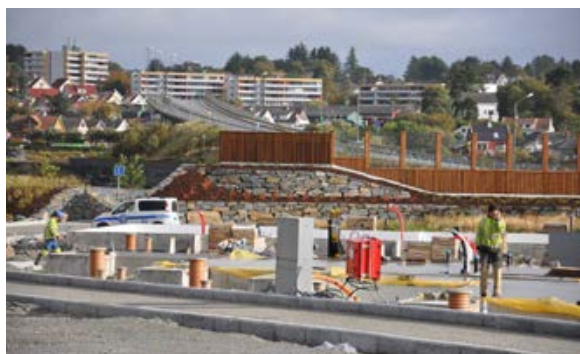
Fra anlegget på Jåsund.
