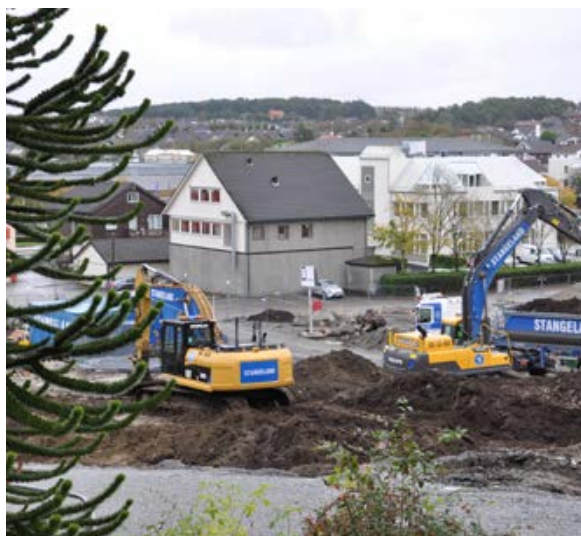
Byggstart Kyrkjebakken Klepp "Apelunden".
