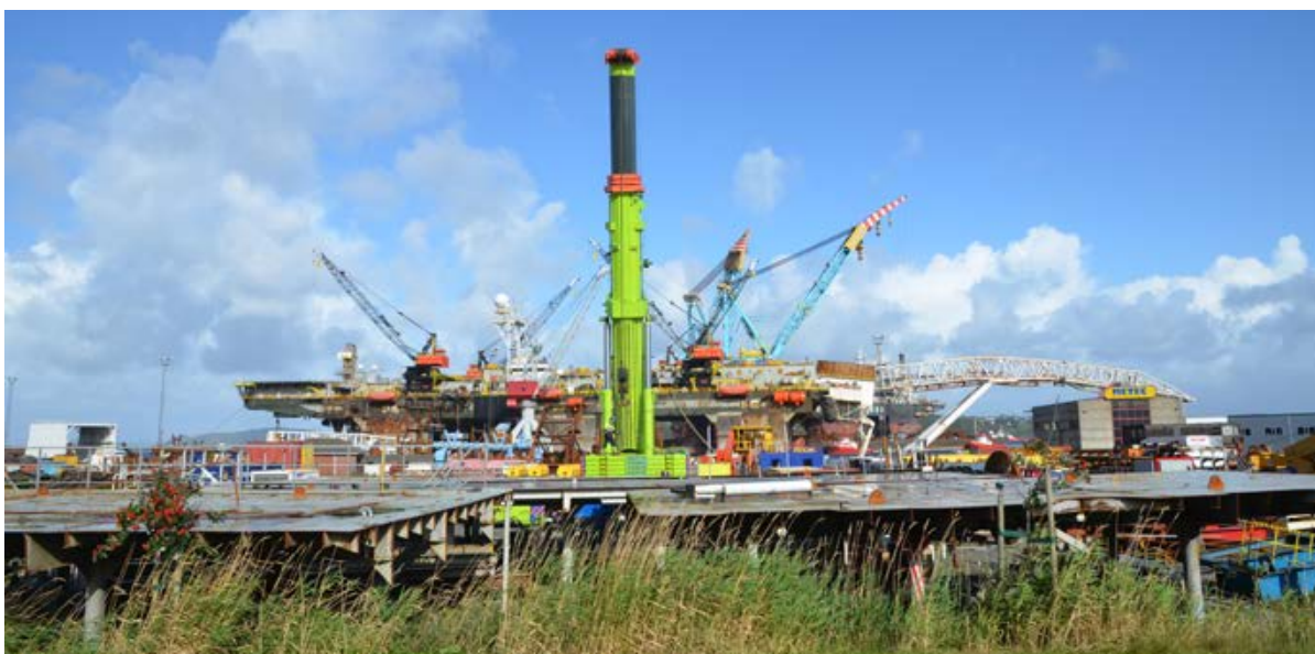
Kran i arbeid i Mekjarvik.
