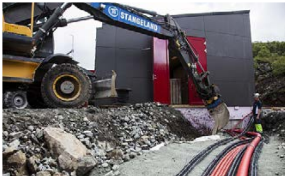
Svein Runestad sander hovedgrøfta inn til trafostasjonen.
