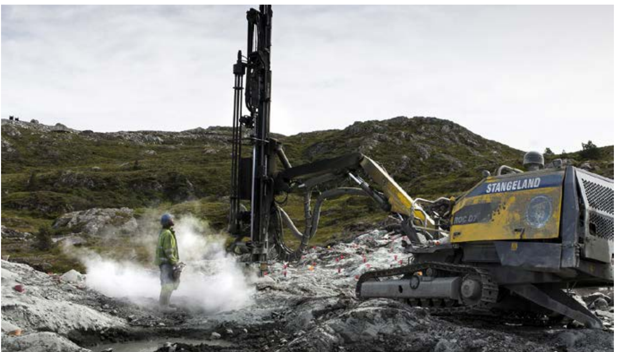
Tom Inge Auestad er gutten i røyken.
