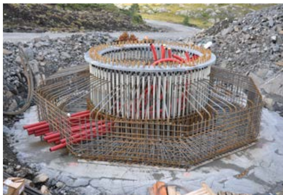
Kraftige fundamenter skal til for å holde vindmøllene på plass på Midt-fjellet. Foto: Leif Emil Egeland.
