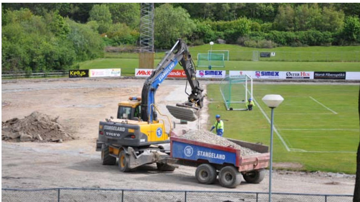
Her er vi i gang med rehabilitering av Sola Sentralidrettsanlegg, løpebaner etc. Sentralidrettsanlegget ble bygget av TS som hovedentreprenør (og undertegnede anleggsleder) for over 30 år siden.
