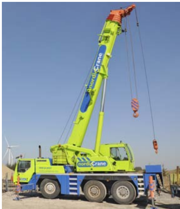
Kranarbeid for Høg-Jæren Energipark. Foto: Leif Emil Egeland.
