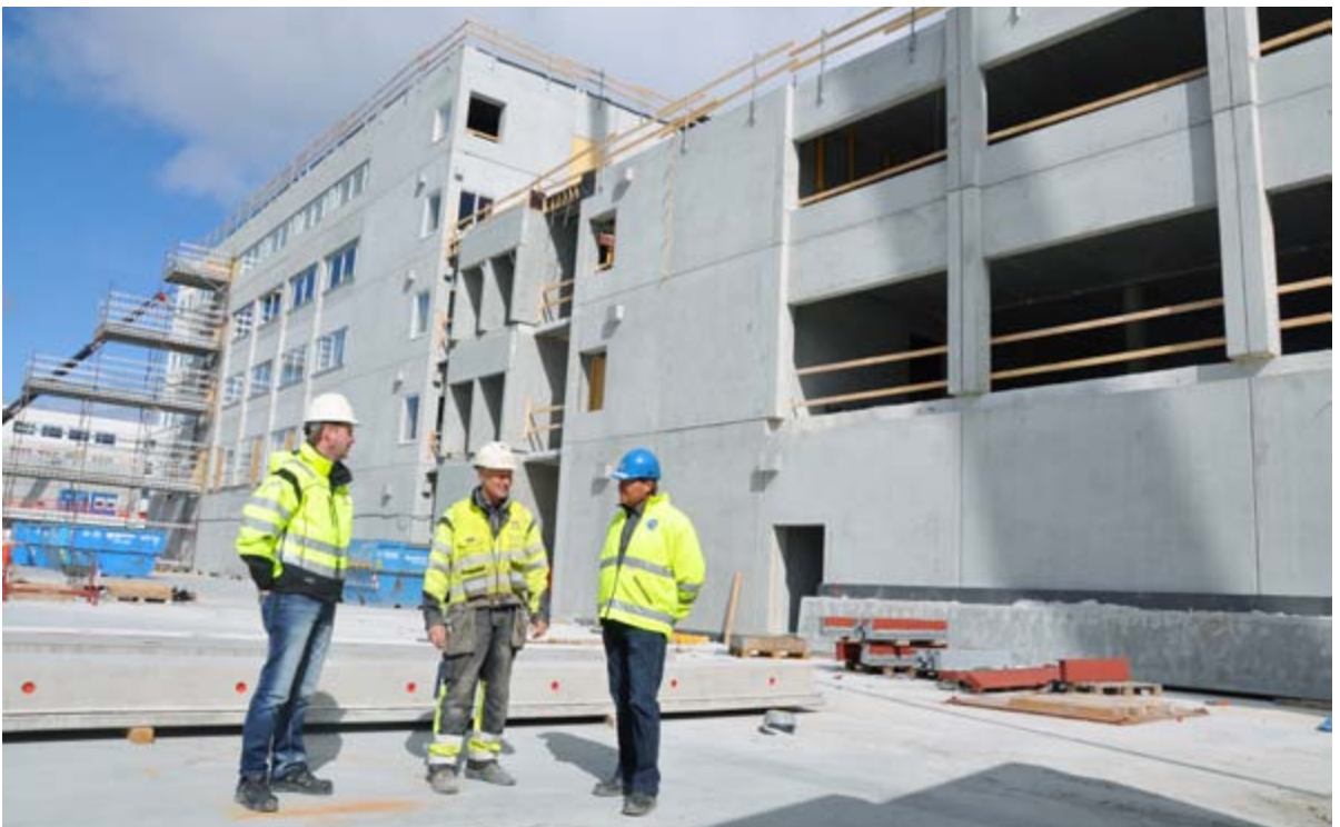
Byggherre: Kanalsletta As. Leietaker: Fabricom Kontorbygg på 17500 m 2 . Byggeperiode: Desember 11 – august 13. Entreprenøskostnad: 220 mill eks.mva
