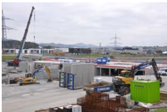
Prosjekt for Skanska ved Solasplitten på Forus. Byggherre Sørco.
