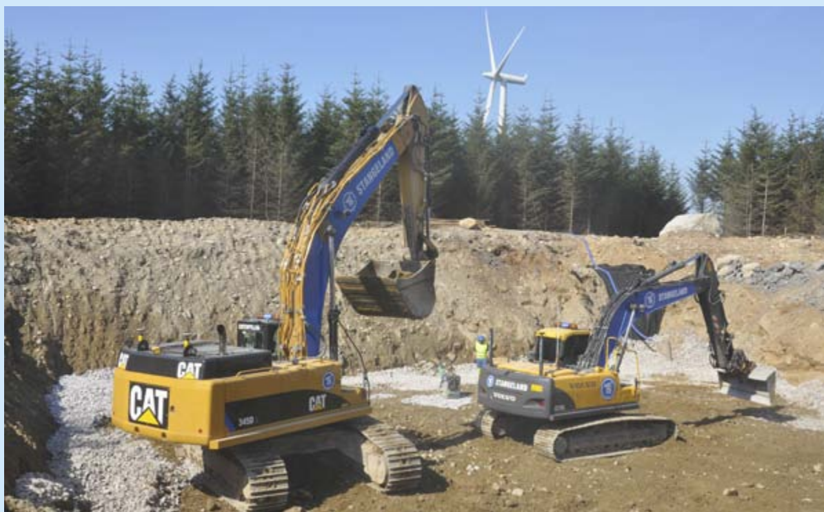
TS er for tiden engasjert på to vindmølleprosjekter nemlig Midtjullet på Stord og Høgjæren. Bildet viser utgraving og pukking av traubunn for et av de store vindmøllefundamentene.
