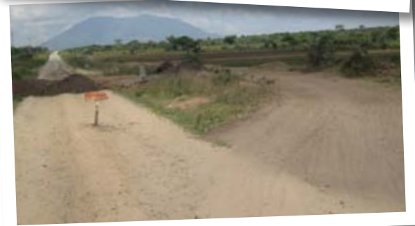
Enkle skiltplaner for graving gjennom vei. På skiltet står: Hald Høgre. I andre enden er det bare sperra med eit tre.
