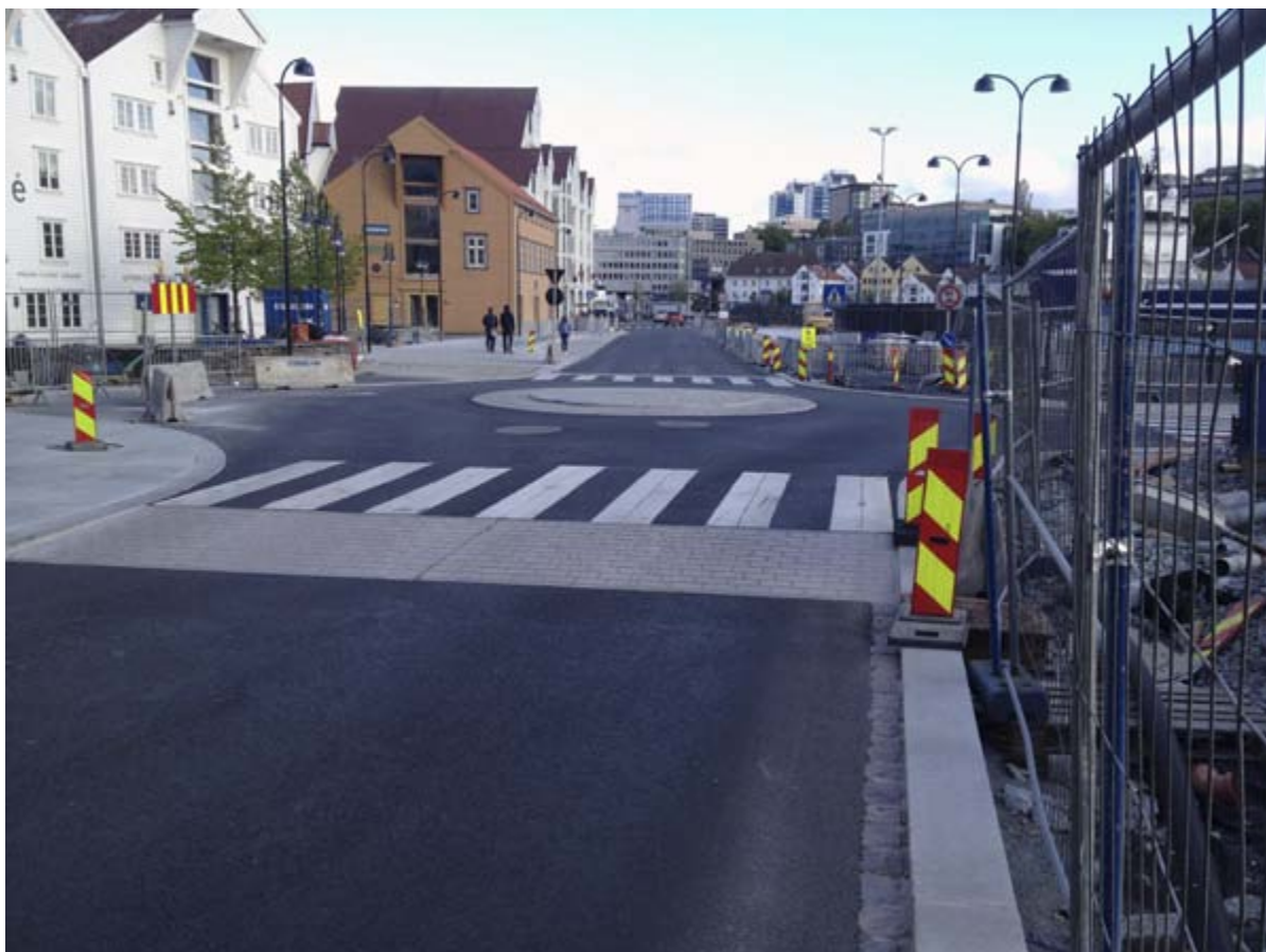
Havneringen etappe 2 - slutfasen, prefabrikkert rundkjøring
