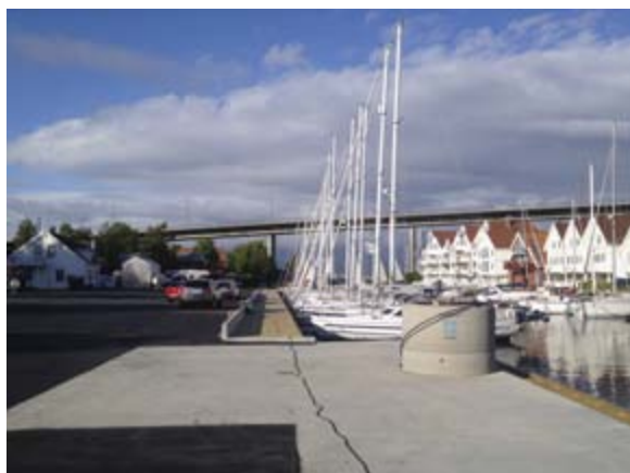
Sølyst –ny gangbrygge
