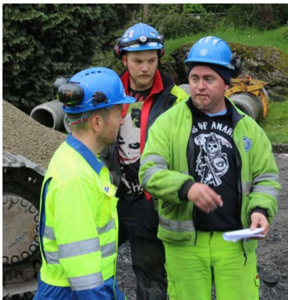
Gjengen til Jonny Ellertsen har nådd arbeidsmålet sitt, og vel så det, om hvor langt de i dag skulle grave og legge rør på prosjekt Kuppelhallen ved Bjergsted. Det skal feires i sammen med hele arbeidsgjengen med et vel fortjent pizzabord. Fra venstre Olav Silde, Andreas Østhus og Jonny Ellertsen.
