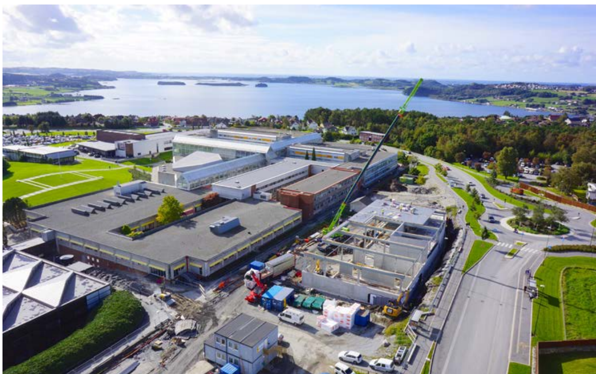
90-tonns Faun med 60 meter bom. Montering av lett tak for Lett-Tak Systemer AS på Ullandhaug.
