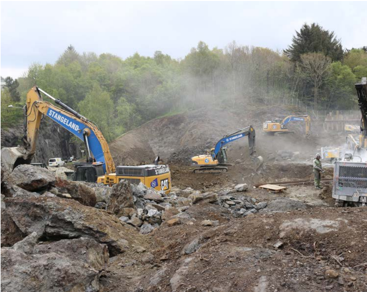
Frå arbeidet på Eiganestunnelen nord som arbeidsfellesskapet JV Bilfinger Stangeland har ansvaret for. Her er me i gang med å rydda vekk masse på nordsida av Byhaugtunnelen, den vart køyrt til Jåttåvågen eller til tippen på Årsvoll. (Foto: Kari Synnøve Vigre).
