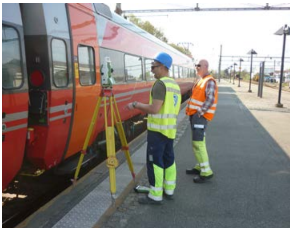
Spenning når toget kommer, er vi midt i døråpningen? Øyvind måler setninger på jembanelinjen fra perrongen. Vaktmann fra jernbaneverket, Jan Arne Haugan følger også spent med..
