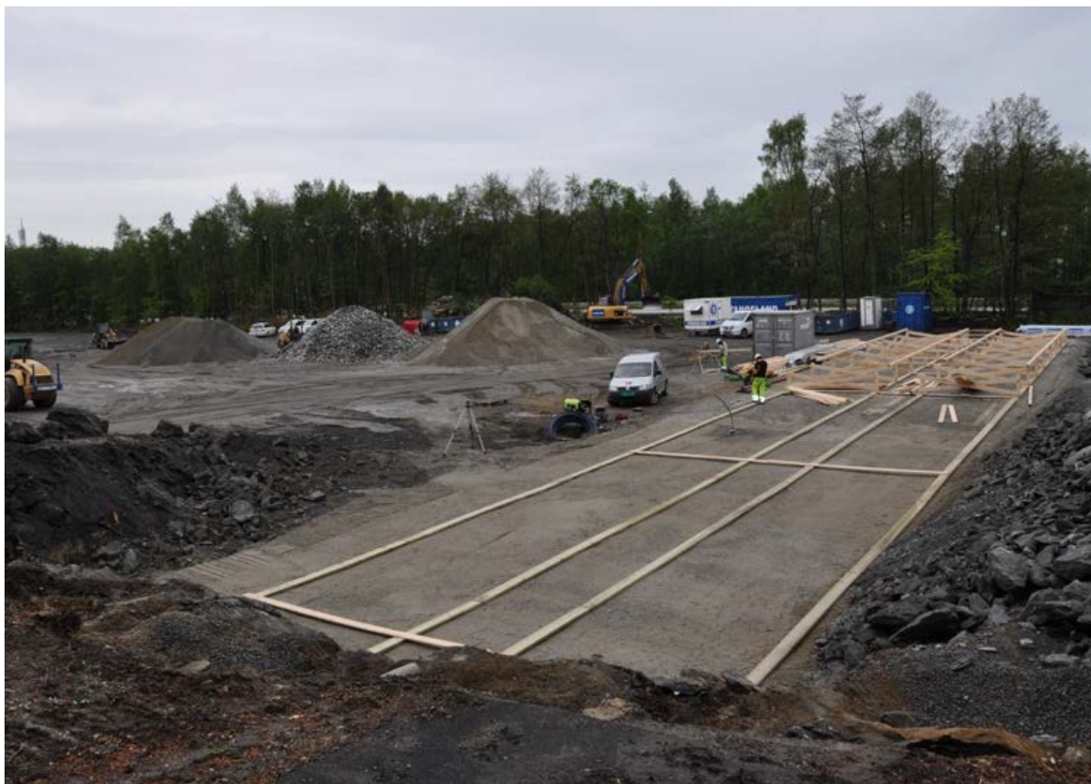
Fundamentering for kontorriggen på Våland.
