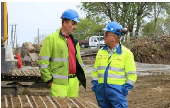
Maskinfører Bjørn Rønneberg til venstre jobber nå på Jåsund 3. Her i sikkerhetssamtale med Olav Stangeland.
