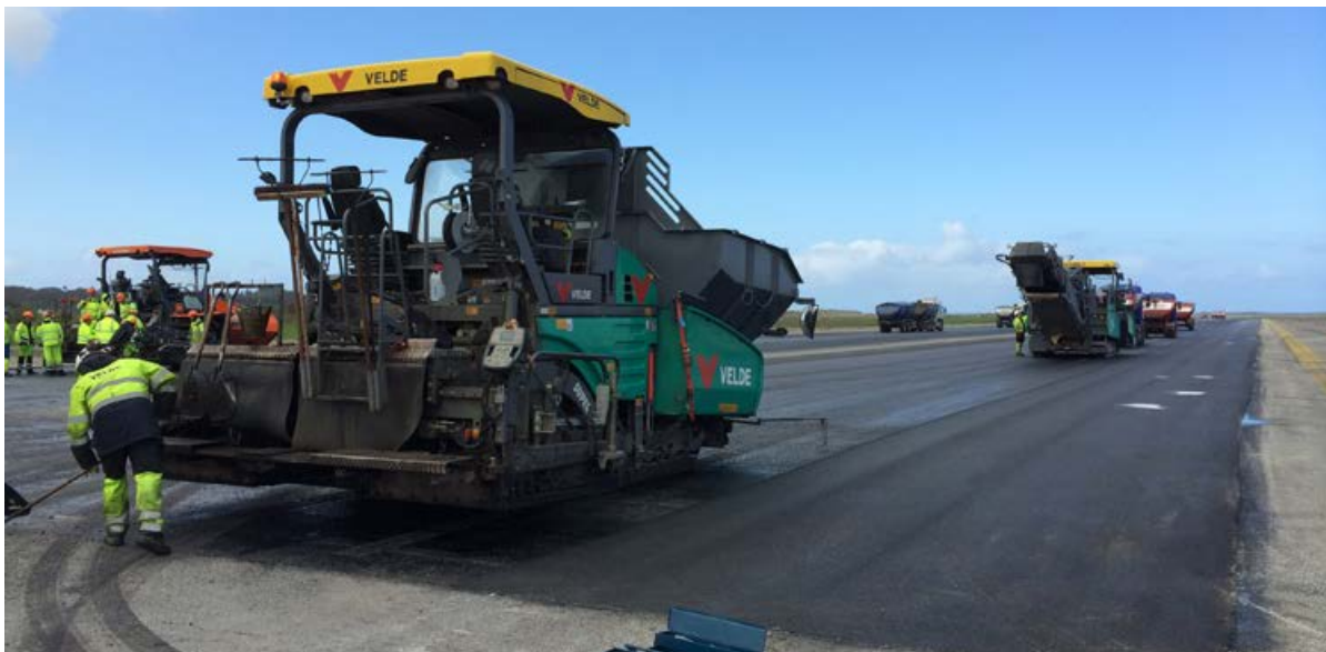
Reasfaltering av rullebanen på Stavanger lufthavn, Sola. Foto: Tony Helles.
