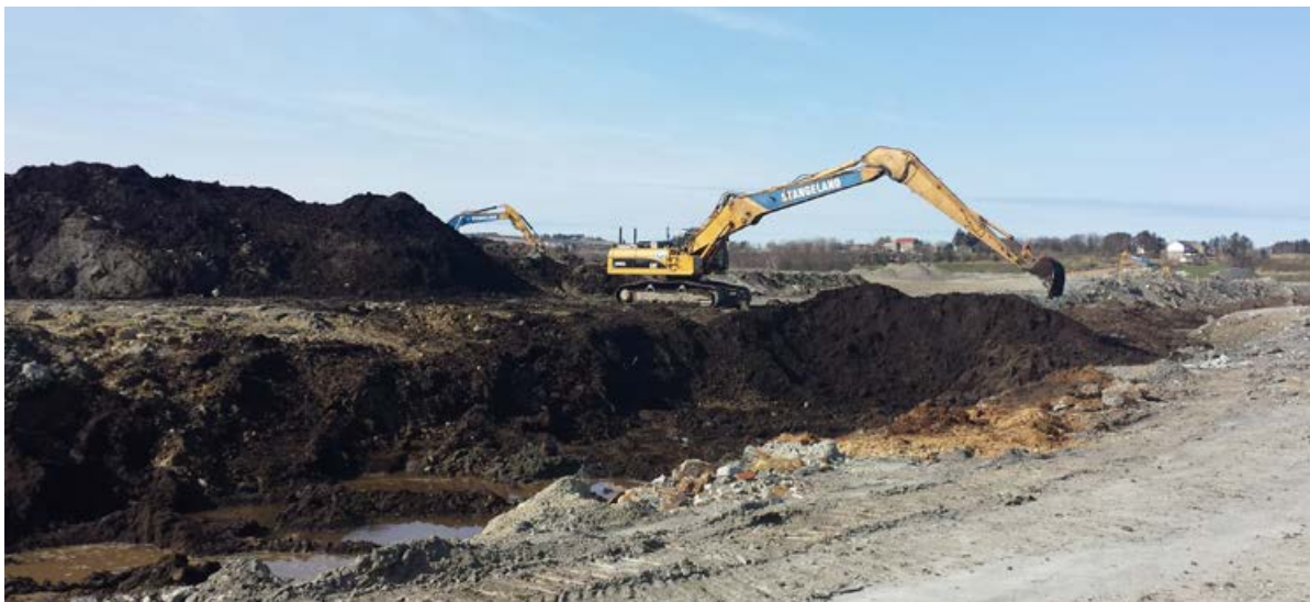
Fra tippen ved Årsvollveien.
