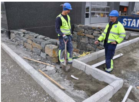
God kommunikasjon mellom Nidijus Skapas, til venstre, og Frank Møller. Her i arbeid utenfor nybygget til Nordic Crane Vest på Stangaland.
