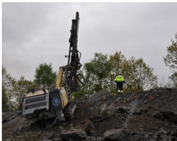
Boring og ladning av kontur på Tasta.
