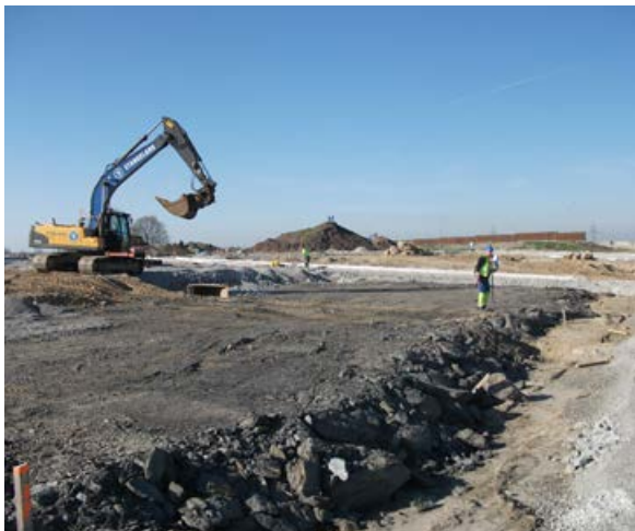
Fra arbeidet vårt på Aase Gård hvor vi opparbeider nytt boligfelt.
