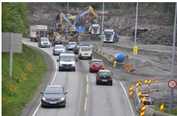
Påhuggsområdet på Tasta. Stor trafikk på E39/Byhaugtunnellen som går like ved siden.
