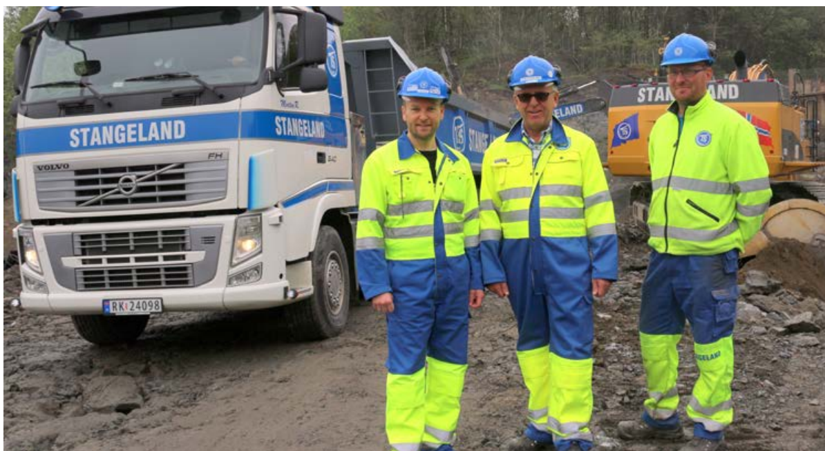
Det er stor aktivitet på prosjekt Eiganestunnelen, Tasta. Fra venstre Olav Silde, Olav Stangeland og Henrik Tunheim. (Foto: Kari Synnøve Vigre).
