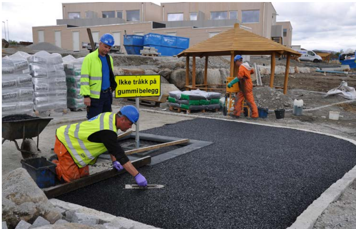
Andreas og Detlef støper gummibelegg som fallunderlag på lekeplass, Sørbø/Hove.
