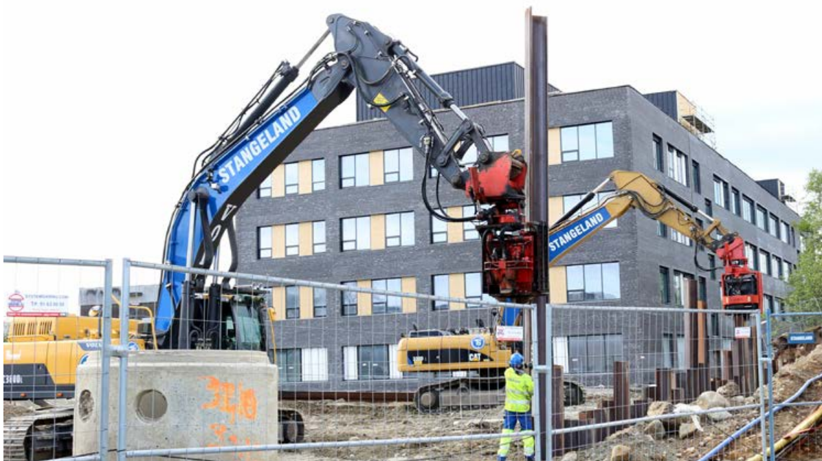
Det er effektivt når vi kan spunte med to gravemaskiner samtidig. Bildet er tatt fra jernbanestasjonen på Bryne.
