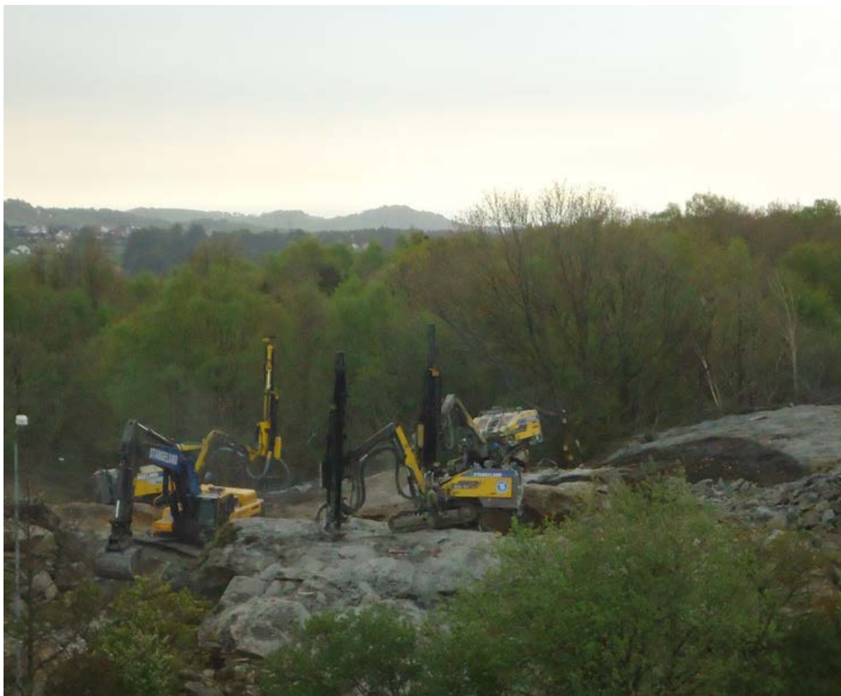
Her borer vi på prosjekt Eiganestunellen nord.
