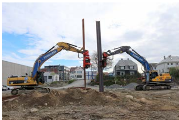
Det nye spunteutstyret på disse gravemaskinene er effektivt og fleksibelt. Her er vi i gang med spunting på Bryne. (Foto: Kari Synnøve Vigre)
