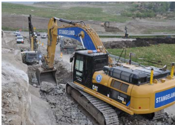
Fra arbeidet vårt på VS-Stein VVA og kulvert, Sviland.
