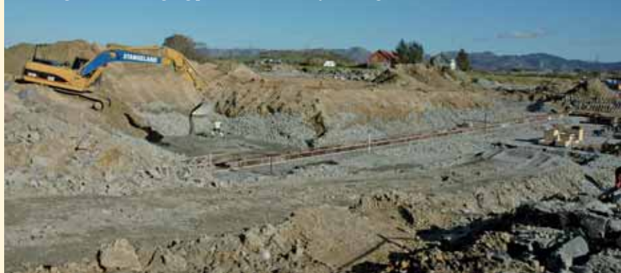
Betongarbeidene er igang på Soma. Foto: Leif Egeland.
