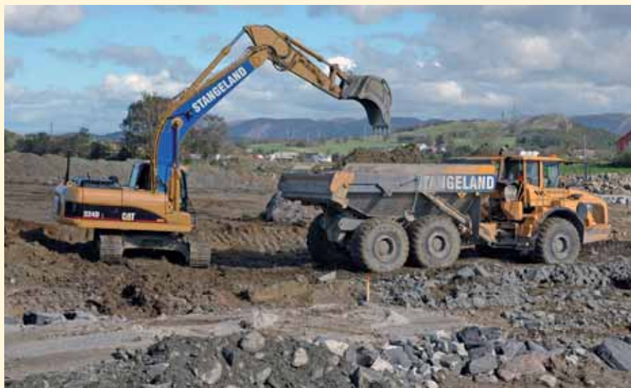
Fra starten av gravearbeidene på vårt nye kontorbygg på Soma.
