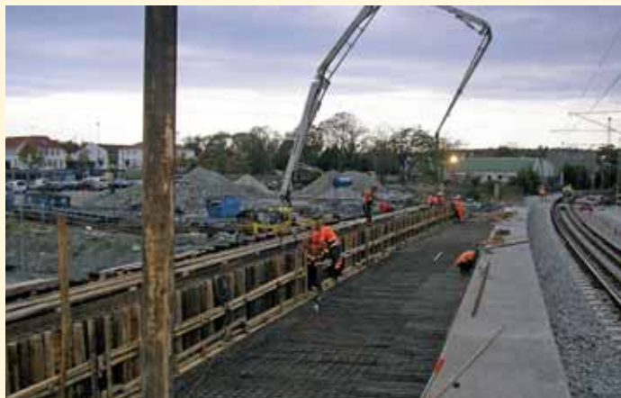
Mange folk i sving tidlig morgen den 29/9 når andre fase av Jåttåvågen bru støpes. Foto: Leif Emil Egeland.
