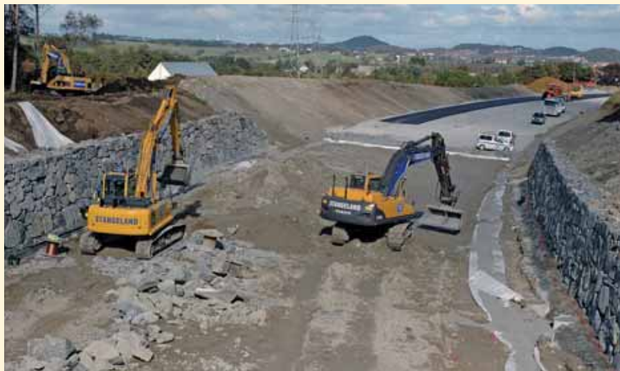
Asfaltering, muring og skråningspuss på RV44.
