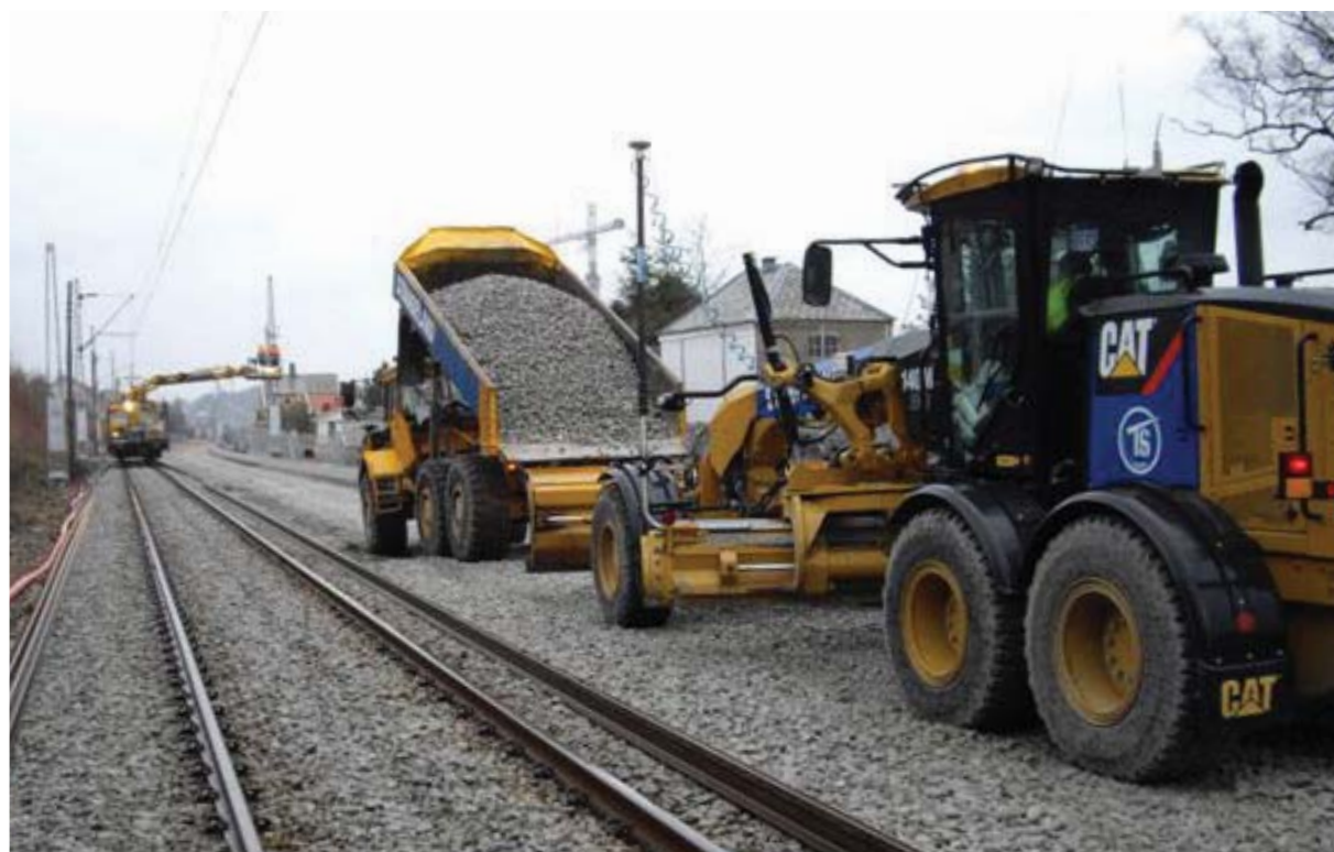
Utlegging av ballastpukk i Nordestraen, Sandnes.
