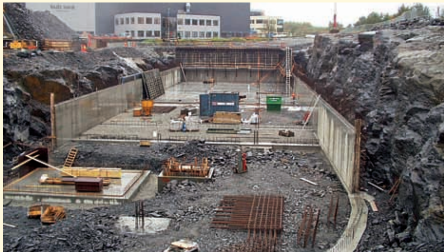
Betongarbeider godt i gang.
