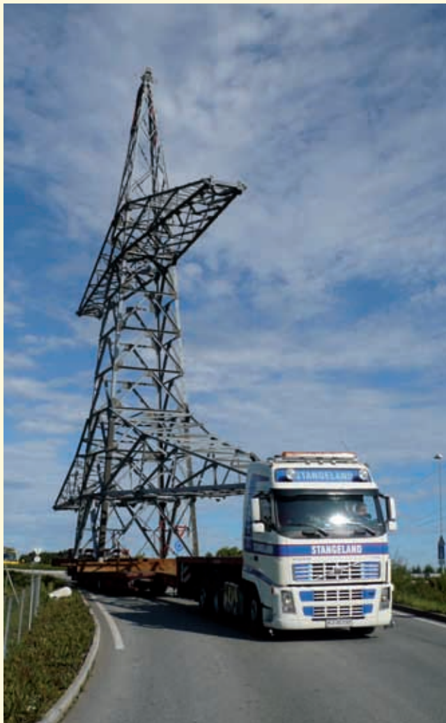
Flytting av høyspentmast på Forus.
