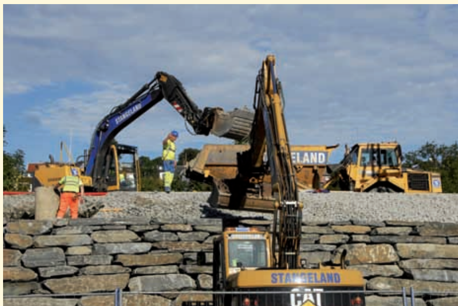
Pukking på dobbeltsporet i Sandnes USS03. Foto: Odd Inge Worsøe.
