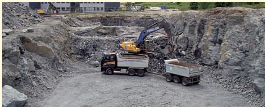
Utlasting av byggegrop nybygg Scan Tech.
