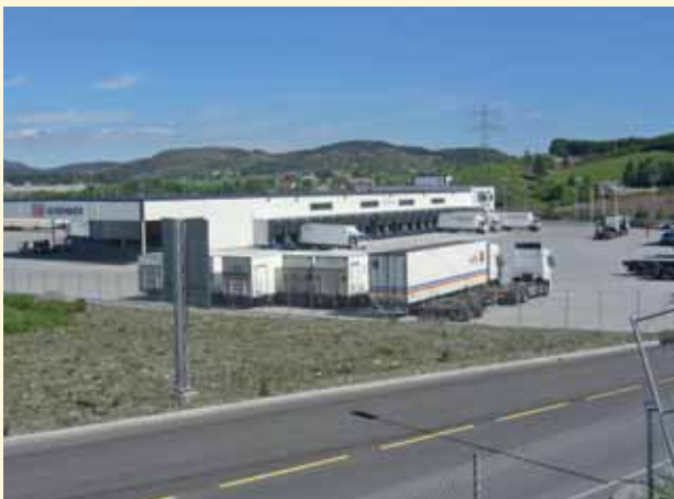
Ganddal Godsterminal hvor vi har lagt belegningsstein.
