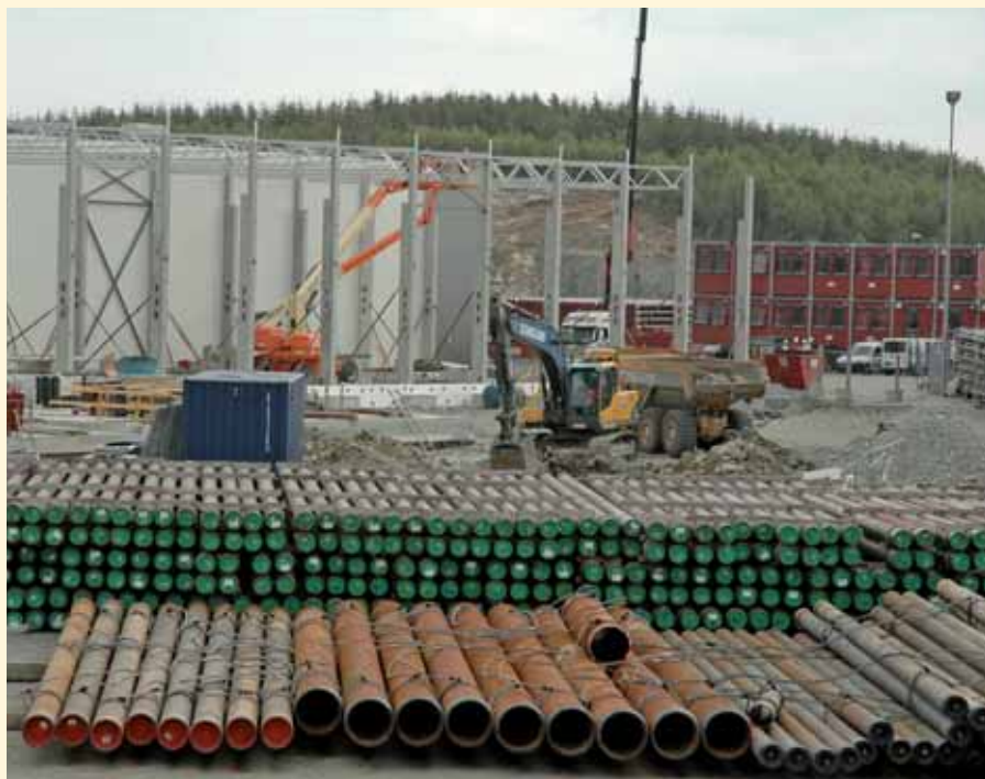
Bjørn Rønneberg planerer rundt verkstedsbygget til Proinvest. Foto: Leif Emil Egeland.
