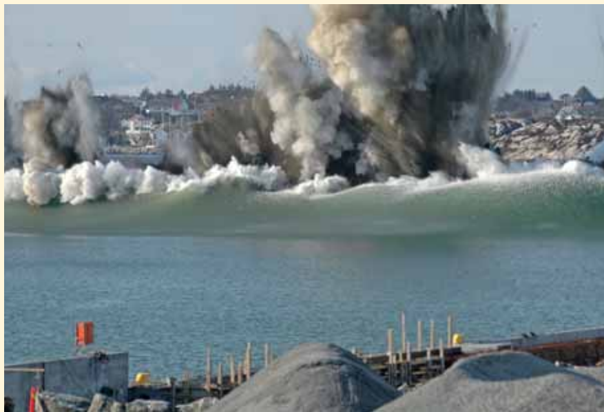
Sprengning av barriereveggen i Risavika havn 14. april. Rene “Sunamien”.
