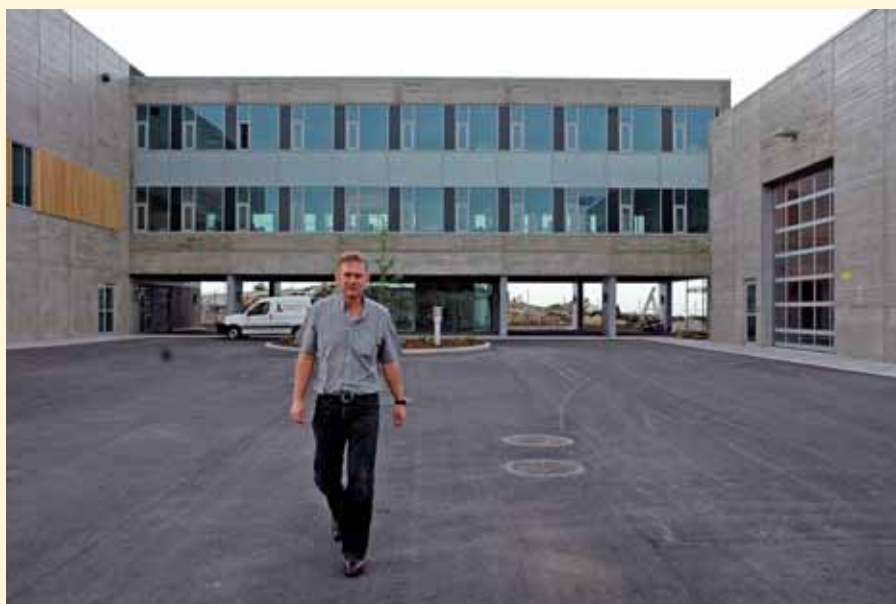
Risavika gass center RGC. Flott bygg. Alle bilder av prosjektene i reportasjen er bygg vi utfører for Lothe Bygg A/S
