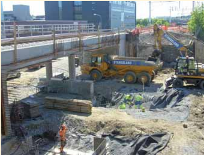
Ny bru ved tinghuset i Sandnes.
