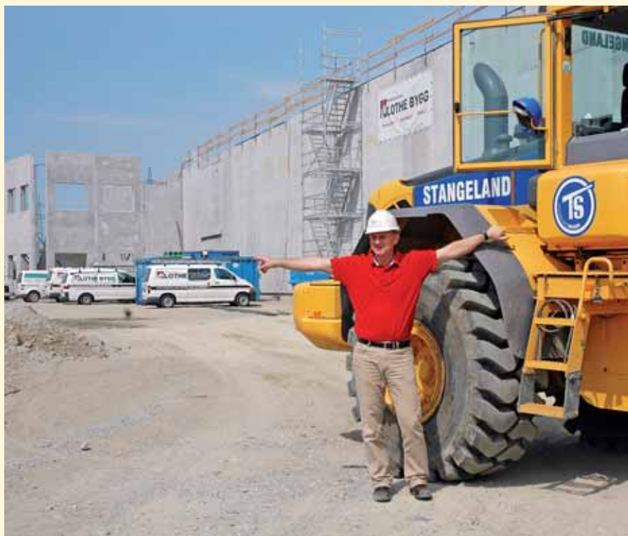
Her er råbygget reist over den store, flotte og topp moderne fabrikkhallen til Multiblokk i Ganddal
