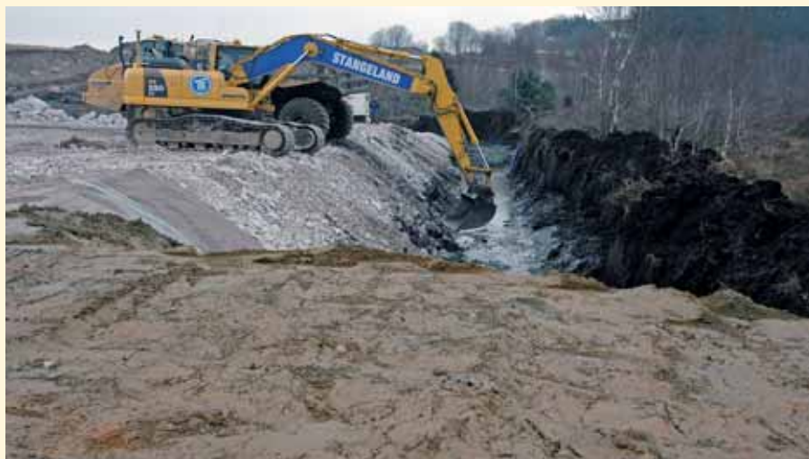
Bygging av tetningsbarriere for å hindre grunnvannssenkning på nabotomten / jernbanen.
