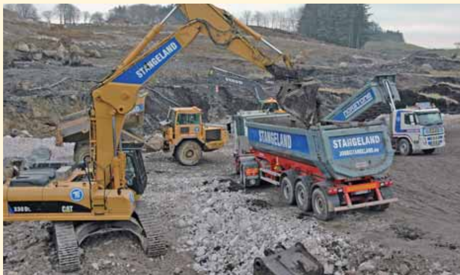
STORJOBBER PÅ BRYNE! Inntil 9 meter dyp myr masseutskiftes på anlegget til Jæren arena / Bryne stadion og industriområdet på Håland
