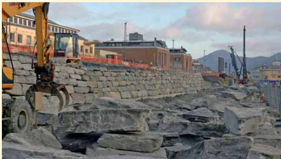
Fra arbeidene ved dobbeltsporet i Sandnes. Flott mur.
