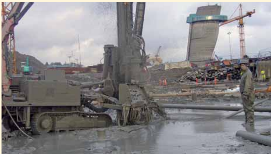
Sigurd Gramstad borer stålkjernepeler. Noen reiser på spa og betaler dyrt for gjørmebehandling!
