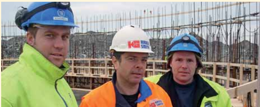
Eivind Knobel Eikeland, Jim Bjørlo og Tor Bjørn Helland under planlegging av glidestøp for LNG-tanken (Foto: Svenn Rune Systad)
