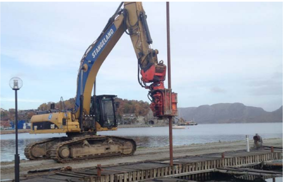
Etablering av stålkjerner i Luravika båthavn.
