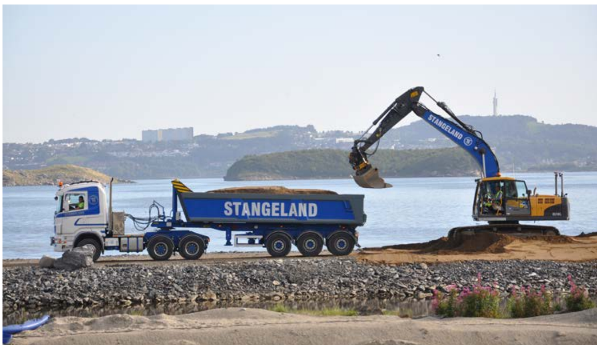
Fra arbeidet på Leirberg, 1 km nord for Sømmevågen. Foto: Leif Emil Egeland.
