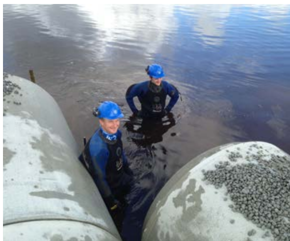
Helge Andersen og Jann Andre Jakobsen jobber med forlengning av kulvert.
