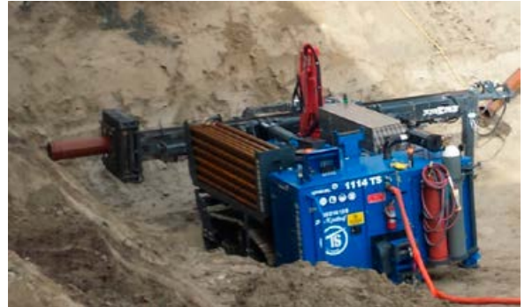
Horisontalboring med Nemek 1114 TS.
