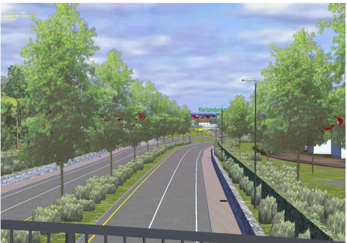
Ny E39 mellom Gamlingen og Madlaveien.
