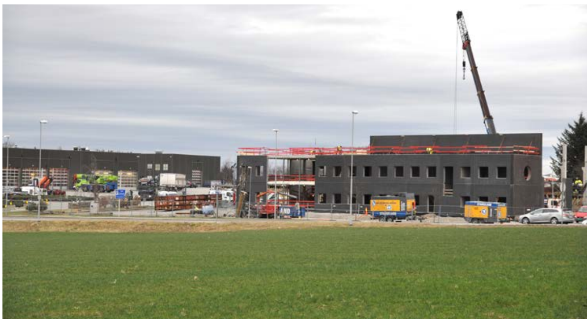
Arbeidet med Nordic Crane Stangeland sitt nybygg er godt i gang. Foto: Leif Emil Egeland.
