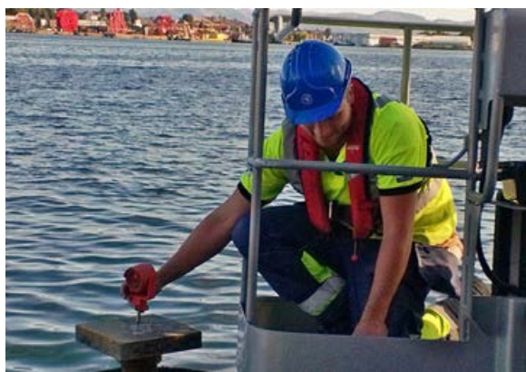
Eirik Hauge Eide i lift over sjøen for innmåling av peler på Veritas.
