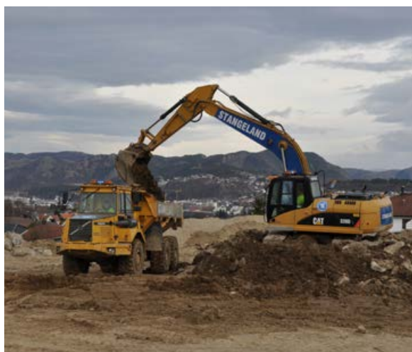
Vi er godt i gang med arbeidet på Aase Gård.
