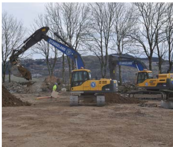
Her skal det bygges eneboliger, rekkehus og boligblokker når vi er ferdige med alt grunnarbeidet.
