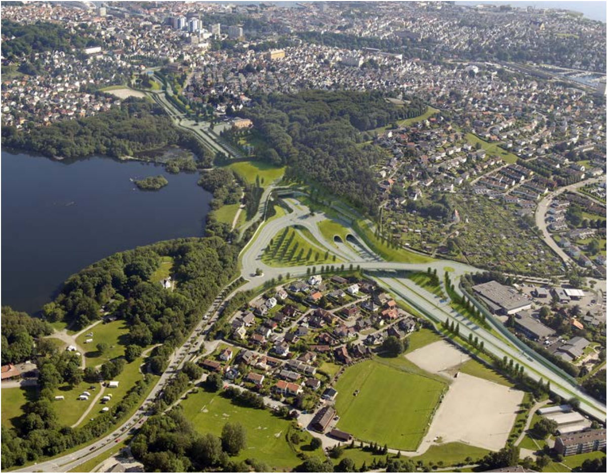
Schancheholen. Foto: Statens vegvesen.
