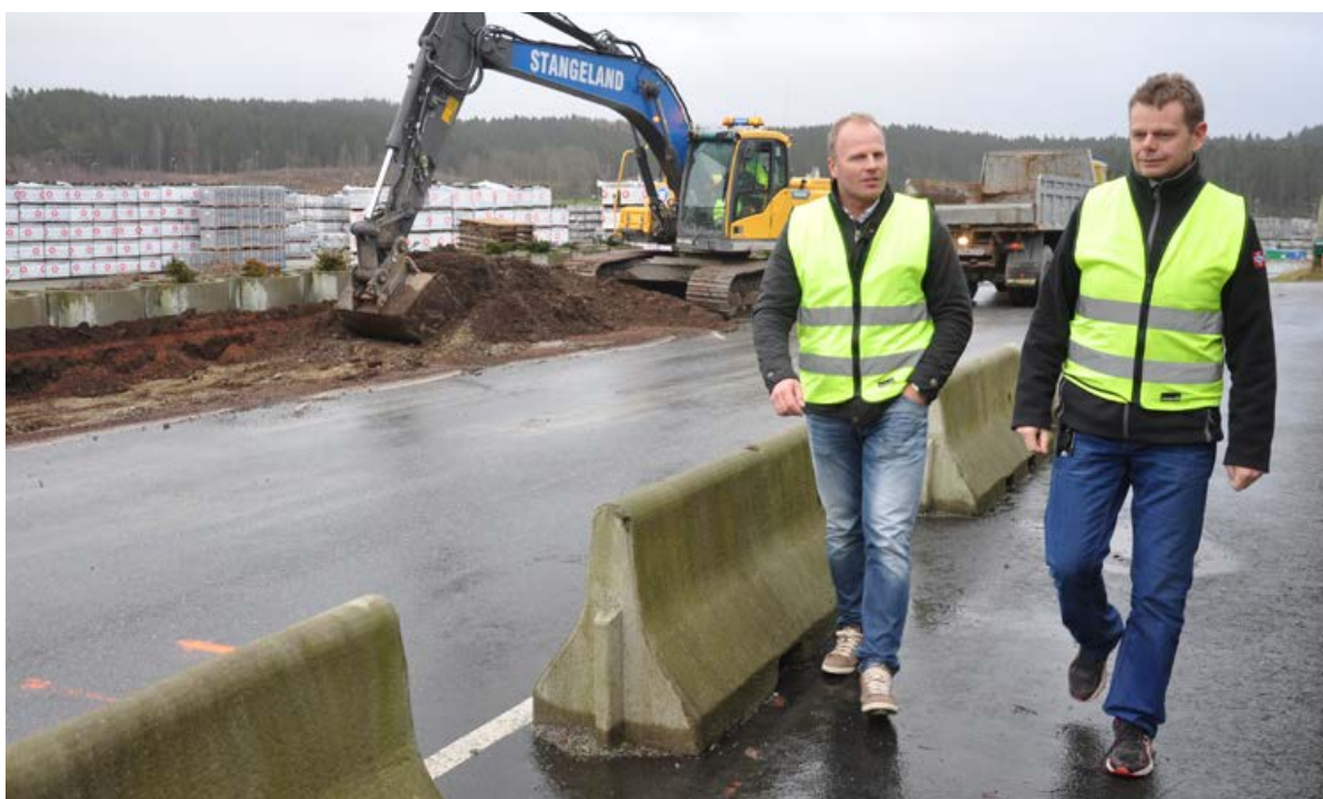
Egil og Sigbjørn inspiserer Stangeland sitt arbeid ved Multiblokk. Det legges gassledning for Lyse Neon og anlegges fortau i Vagleskogveien. Det skal også lages ny adkomst til Multiblokk.
