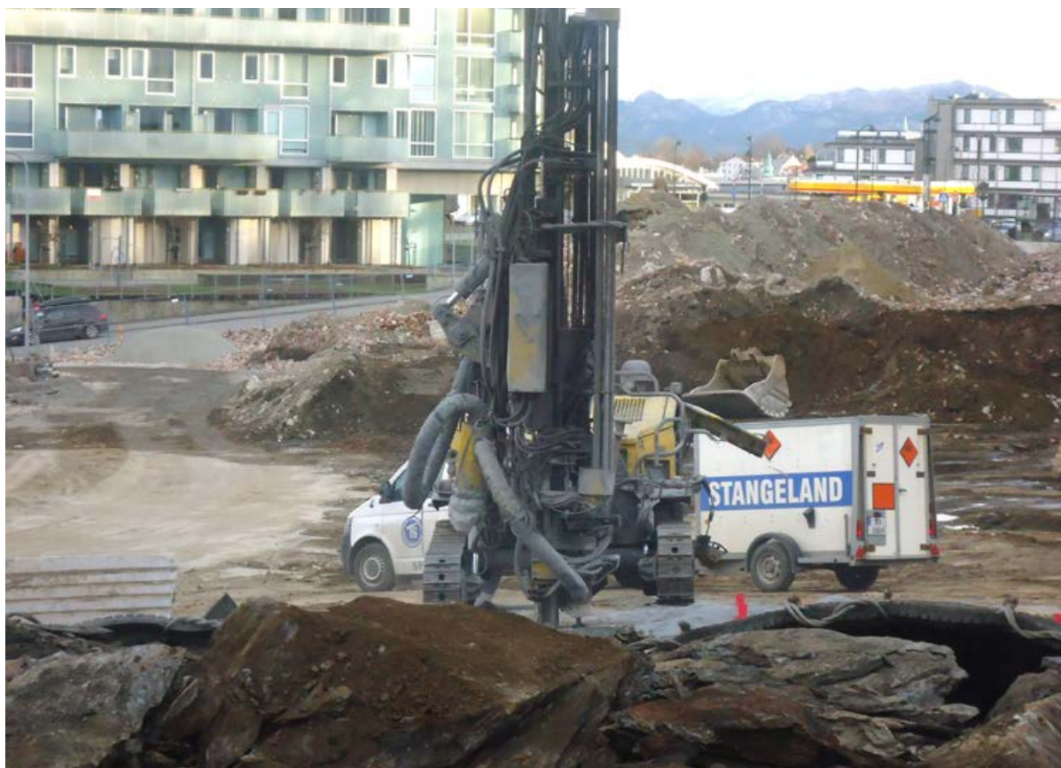
Bergavdelingen i arbeid ved det nye Scandic Stavanger Congress.
