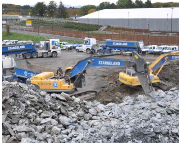
Vi utfører grunn- og utendørsarbeid med både rivning og sprengning på tomta til den nye Vikingshallen. Her er det full aktivitet.
