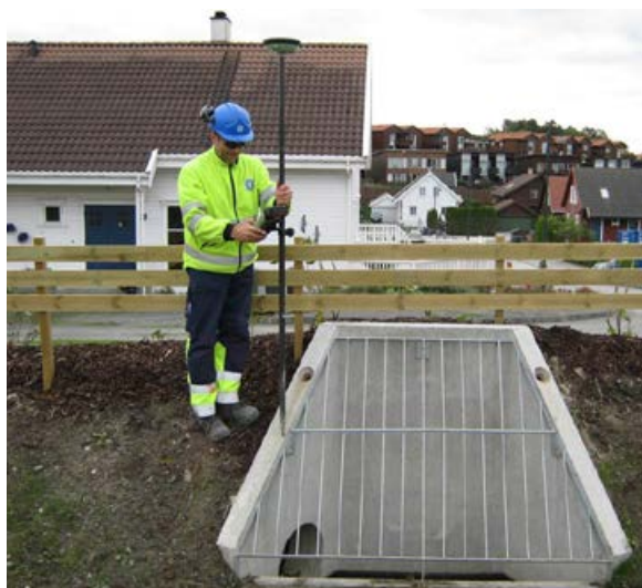
Øyvind Knutsen måler inn avløp på Skadberg.
