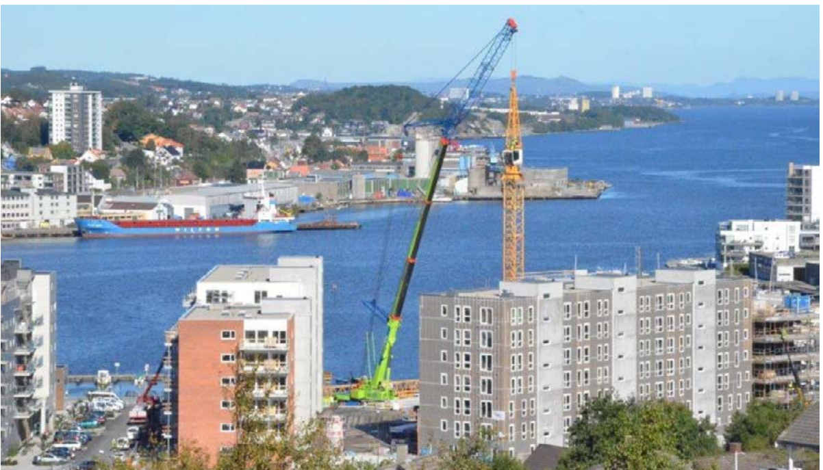
Indre vågen i Sandnes der vi demonterer en tårnkran for E.D. Knutsen Maskin. Kranen som brukes er en Demag AC 665, en 250 tonns kran.
