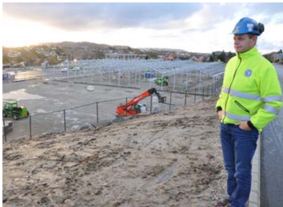
Anleggsleder Sigbjørn Tveiten under arbeidet på Sandved. Foto: Leif Emil Egeland.
