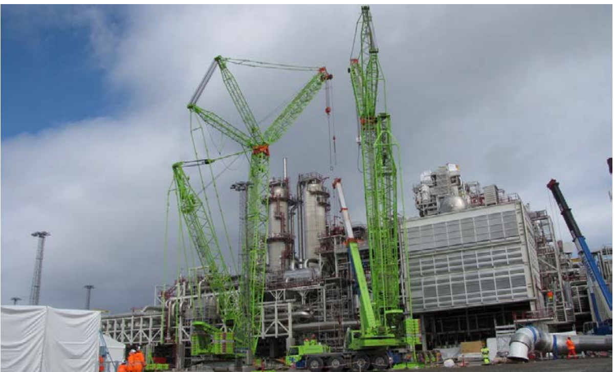
Her er vi på oppdrag for Aker i Eigersund med to gitterkraner på 600 og 300 tonn samt to teleskopkraner på 80 og 160 tonn.
