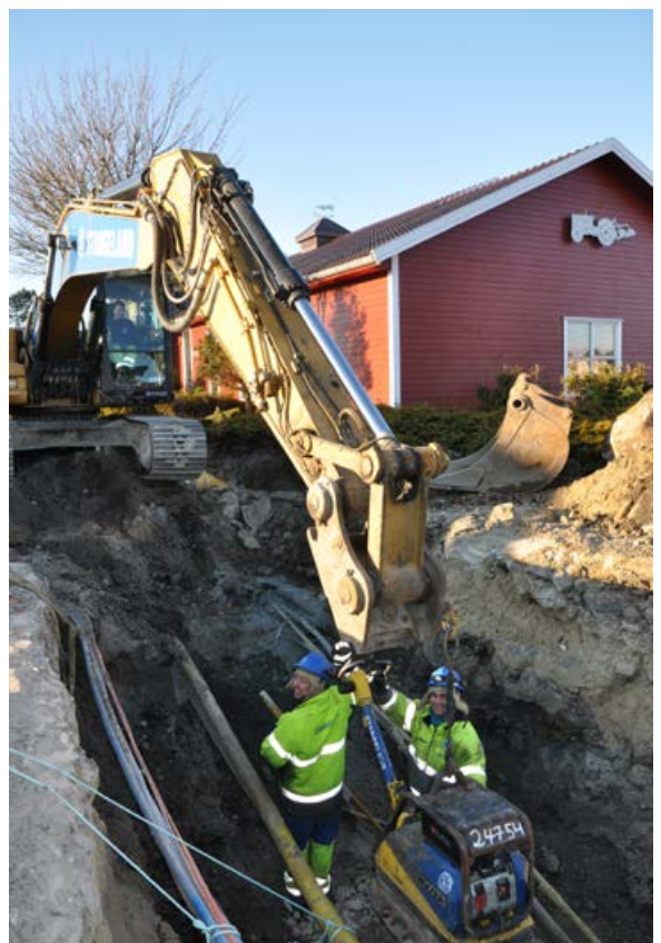
Mye eksisterende kabler i traseen. TS Museet i bakgrunnen.
