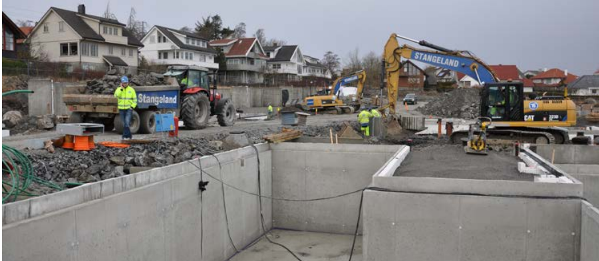
Inntilfylling grunnmurer Sandved Nord. Foto Leif Emil Egeland.
