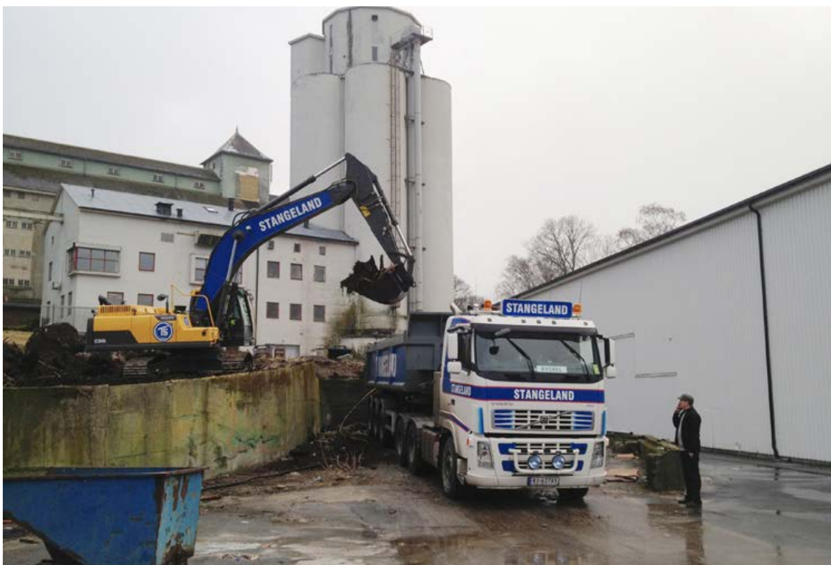
Fiskå Mølle – Jonny Ellertsen laster ut løsmasse med ny Volvo EC 300
