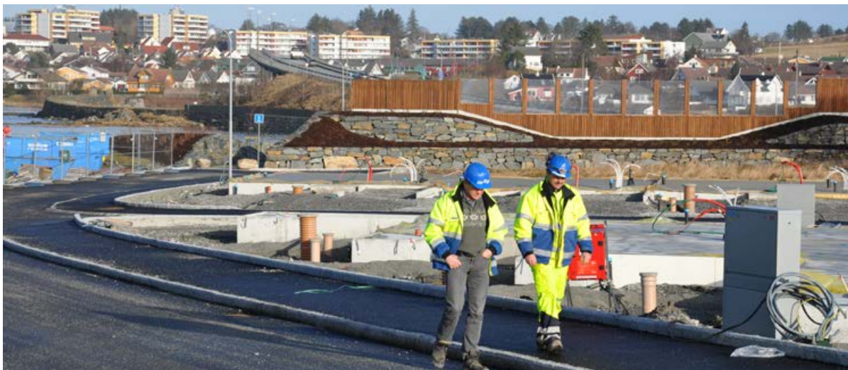
Jåsundfeltet ligger flott til ved Håfrsfjord og med Tananagerbruk i bakgrunnen. Anleggsleder Ingvald Årsvoll og driftsleder Kjell Ove Helleland inspisierer arbeidene som er utført. Foto: Leif Emil Egeland.
