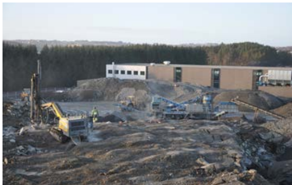
Profftre er allerede på plass på Kverneland Næringspark hvor vi har tatt ut over 200.000 m 3 . Foto: Leif Emil Egeland.
