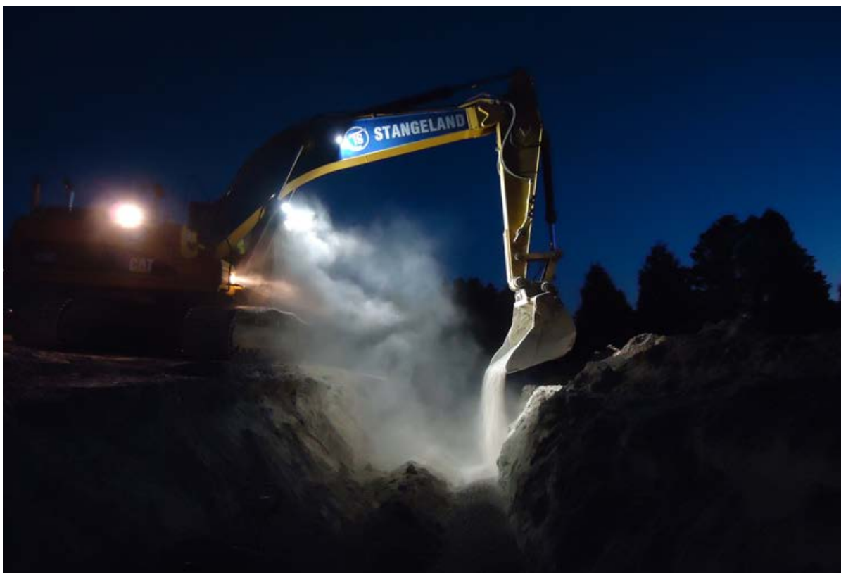
Fra grøfta på Byggefelt Sandsgård. Thomas Melby
