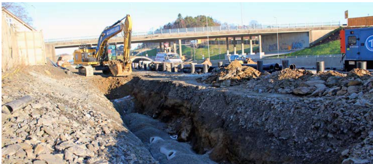
VA-grøft på Schancheholen.
