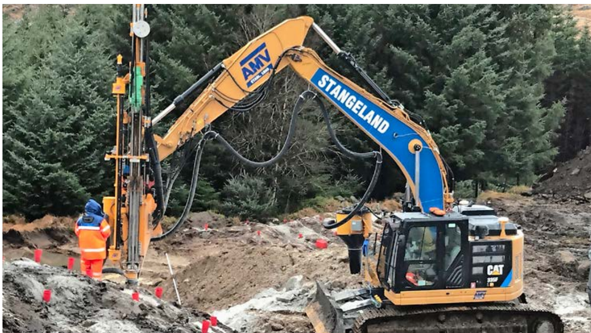
Ny Cat 335F med AMV boreaggregat i gang med oppstarten på Bjerkreim Vindpark.
