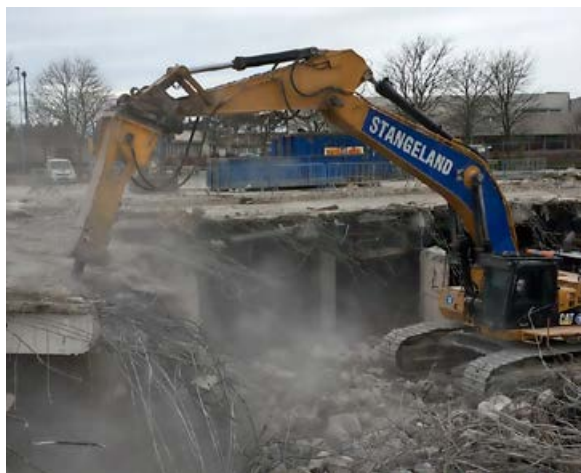
Gravemaskin 75 tonn med meisel. Dette er noe som virker!
