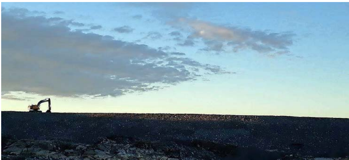
Det regner ikke alltid. Dette bildet er tatt en fin dag i Svåheia, Leon Aarre kjører gravemaskinen. (Foto: Torstein Gjerdevik).
