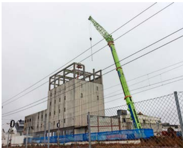
Riving av tørketårnet på Nærbø Meieri. Mobilkran 500T i aksjon med å heise ned elementer.
