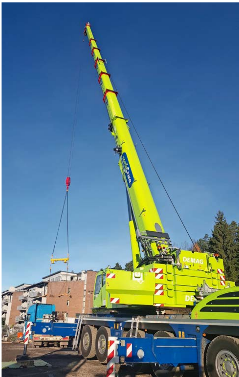
Ny Demag i arbeid i Oslo. Foto: Trond Strøm.
