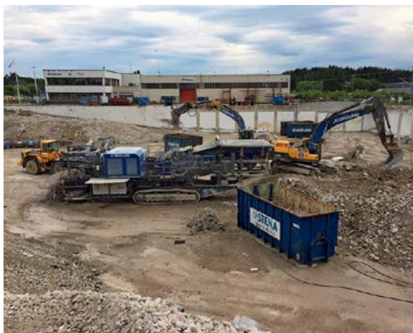
Betongknuseren i aksjon.
