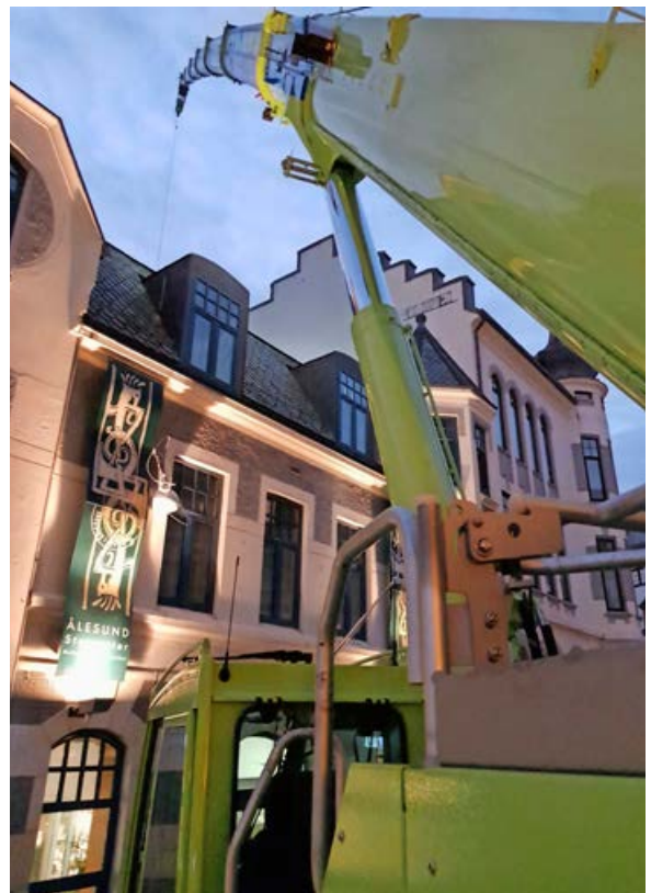
Kran i arbeid i Ålesund sentrum.
