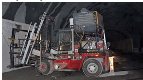
Montasje av veggelementer.
