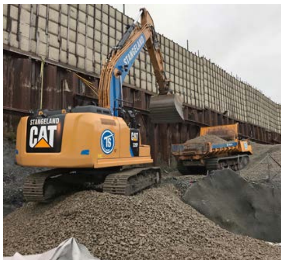
Svithunparken. Utlegging av drengsmasser.
