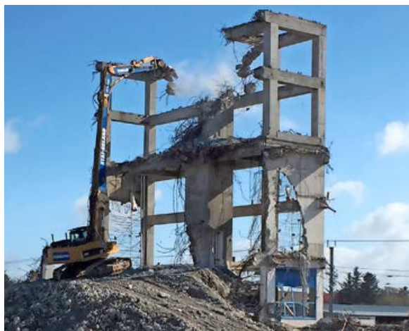
Tørketårnet må gi tapt for CAT 330 rivebom med saks.
