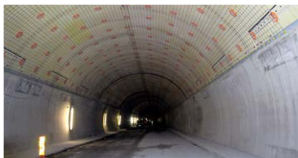
Vann og frostsikring i tunnel.
