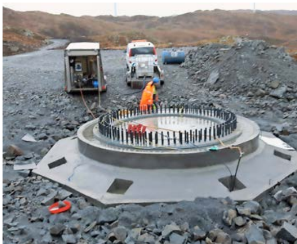
Ole Morten Helleland og Andre Tesch driver med trykking av borehull. Her i forbindelse med fundamentering av vindmøller på Midtfjellet.
