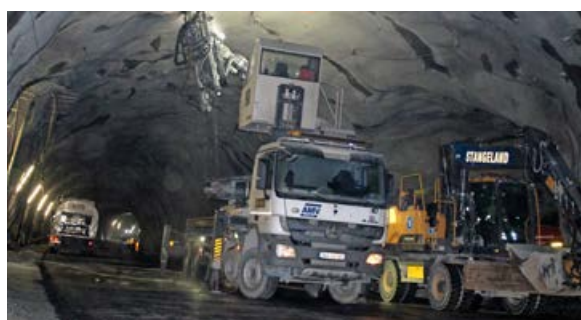
Boring av opphengsbolter.
