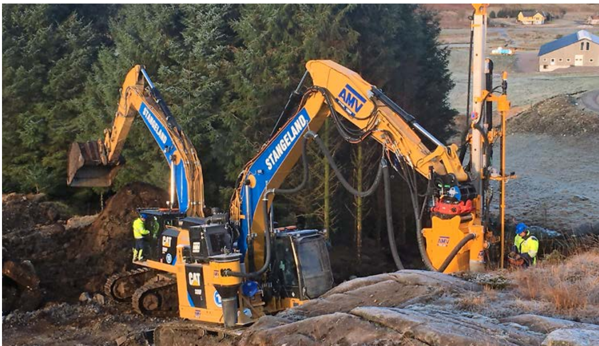
BJERKREIM: Den nye gravemaskinen med boretårn på starten av veiprosjektet.
