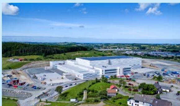
Stein A Hansen har sendt oss dette bildet fra Vagle med snart ferdig bygg til Rema 1000 og stor aktivitet.
