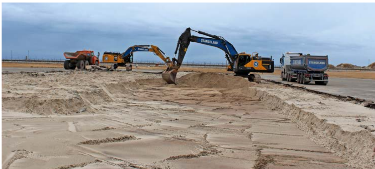
Stavanger lufthavn, Sola. Oppgradering av dekke på rullebanen.
