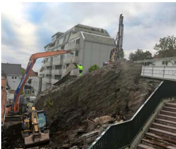
Sprengning i Kongsgata, Stavanger.
