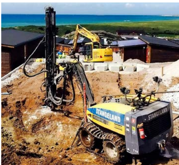
Boring og sprenging på Oгна Camping. Foto: Frode Nevland.
