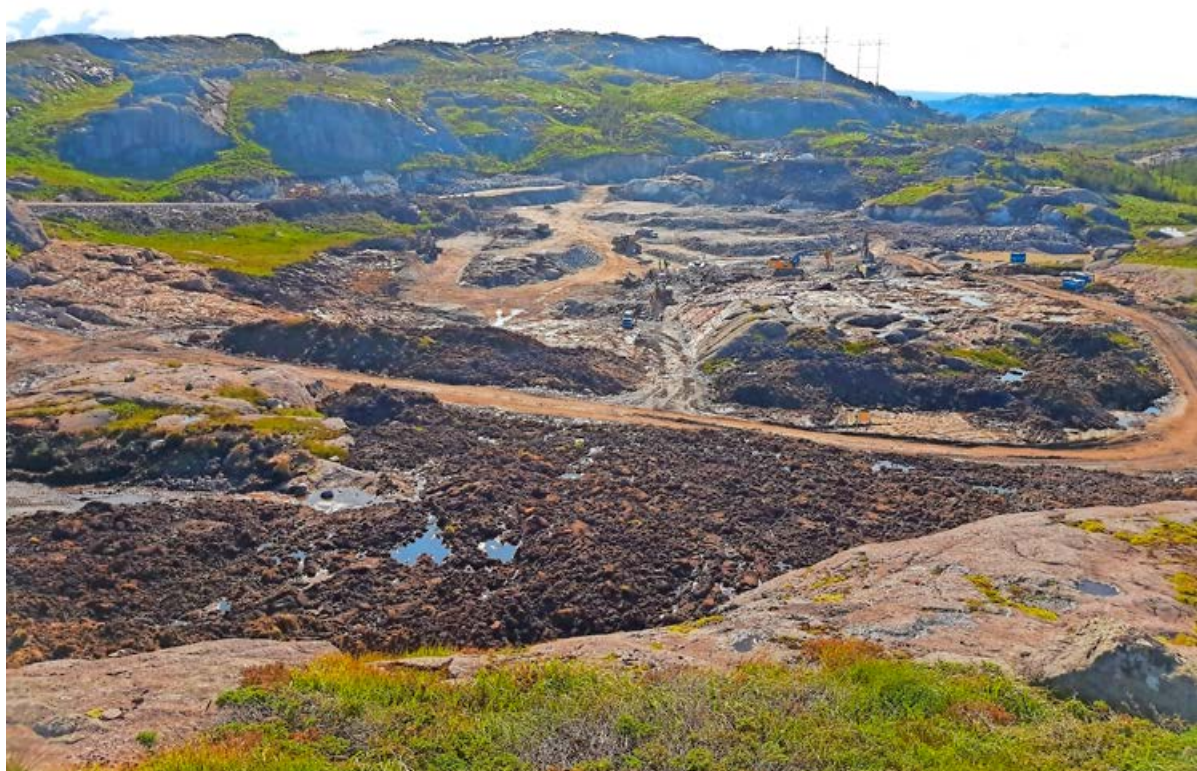
Lunsj på toppen av anlegget i Bjerkeim. Foto: Morten Bruland Eidså.
