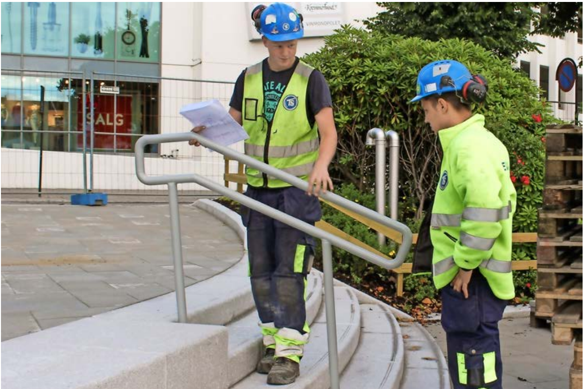
Fredrik André Joa Pedersen og Ronny Andtbacka blir enige om monteringen av rekkverk i trappen på Hillevåg torg.
