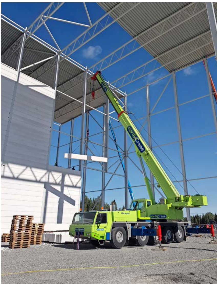
Nordic Crane Oslo i monteringsjobb på Rema 1000 sitt nye sentrallager på Vinterbro.
