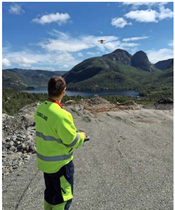
Jon Erling Aasen styrer dronen fint ned igjen under måling av pukkverk på Tau.
