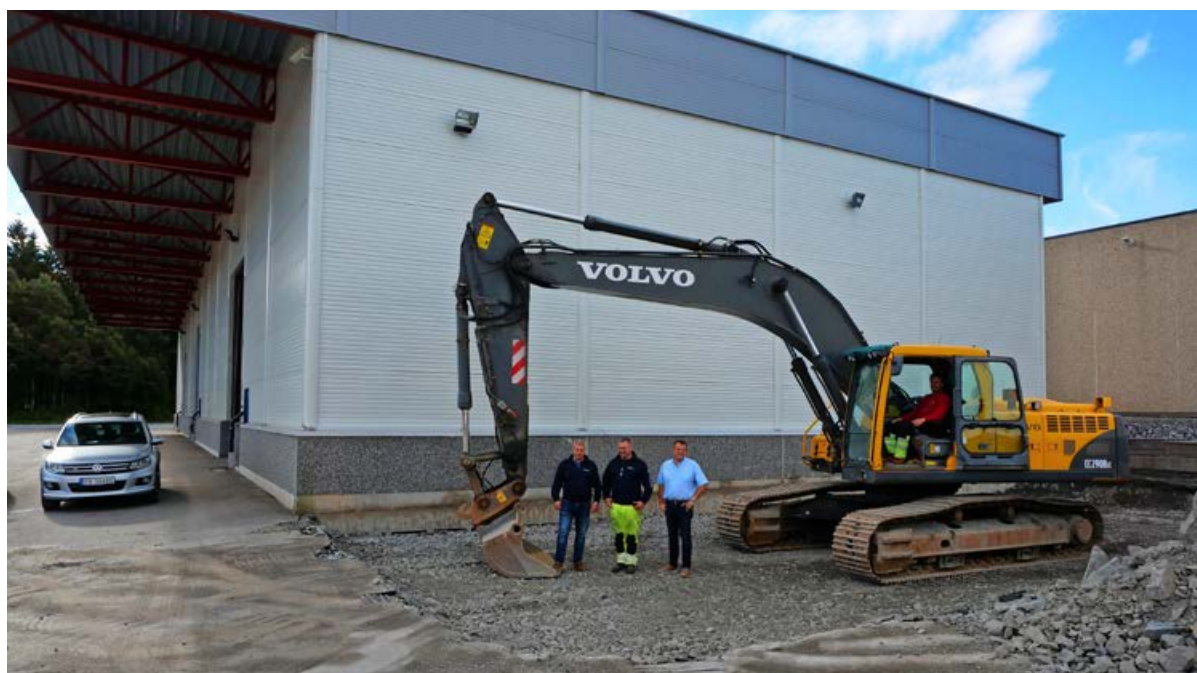
Sommerstans i byggefasen. Kenneth Lande, Tor Øyvind Larsen, Rolf Inge Valde og Thomas A. Stette tok oppstilling foran nybygget.
