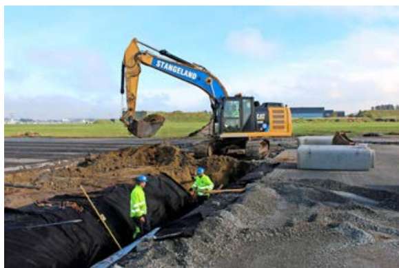
Legging av Qmax rør. Harald Kartevoll og Per Morten Sikveland i grøfta. Thomas Jåsund i maskinen.
