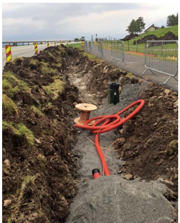
Kabelgrøft på Rennesøy.
