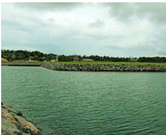
Jåttåvågen: Småbåthavn i sørdokk.
