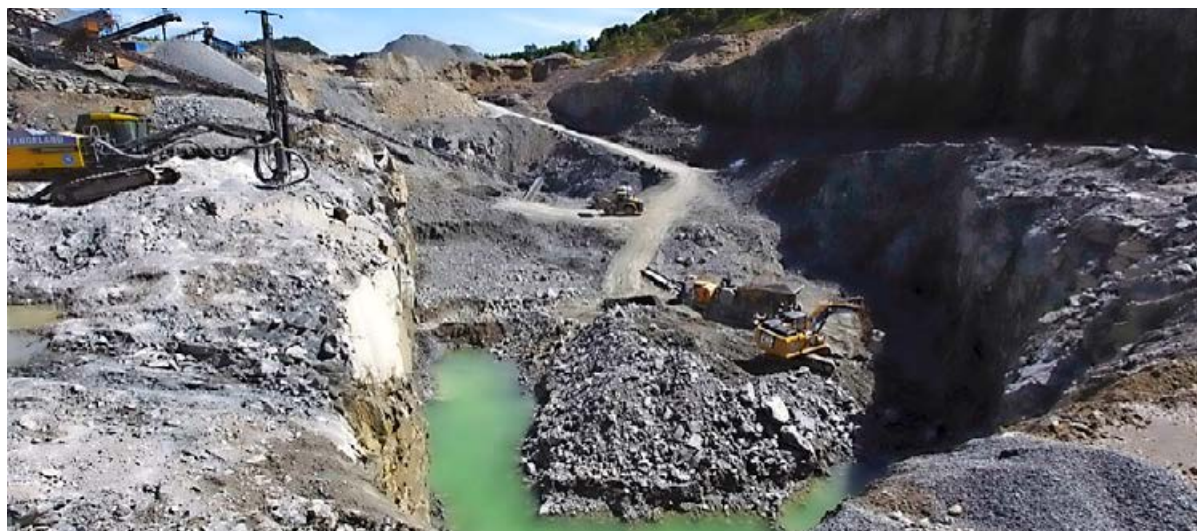
Pukkverk Nordre Kalberg, Fredrik Sele i gravemaskin, Thomas Tangedal i hjullaster og Nils Kjetil Salte i Borerigg (foto: Einar Sira)
