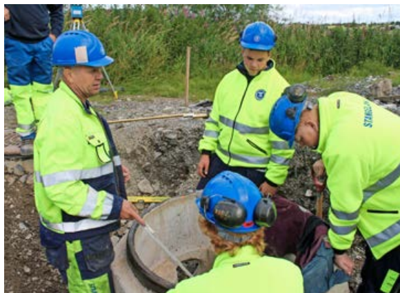
Vår egen lærer, Jan Oaland, underviser i legging av rør på øvingsfeltet vårt. Anders Lund Gundegjerde, Tor Eivind Gilje og Geir Atle Apeland følger nøye med.
