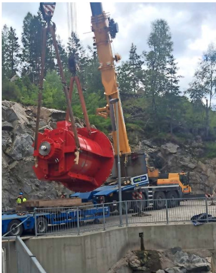
Spesialtransport og innløft av generator. Samløft med Liebherr 200 T og Liebherr 90 T. Alt gikk etter planen, og kunden er strålende fornøyd.
