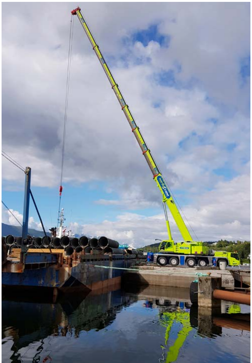
Kraning av rør på Håhjem. Foto: Stefan Gjendem
