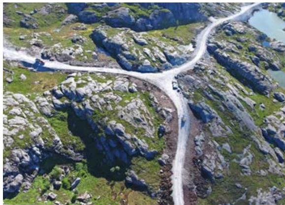
Dronebilde av litt av den 37 km lange veien vi har bygget.
