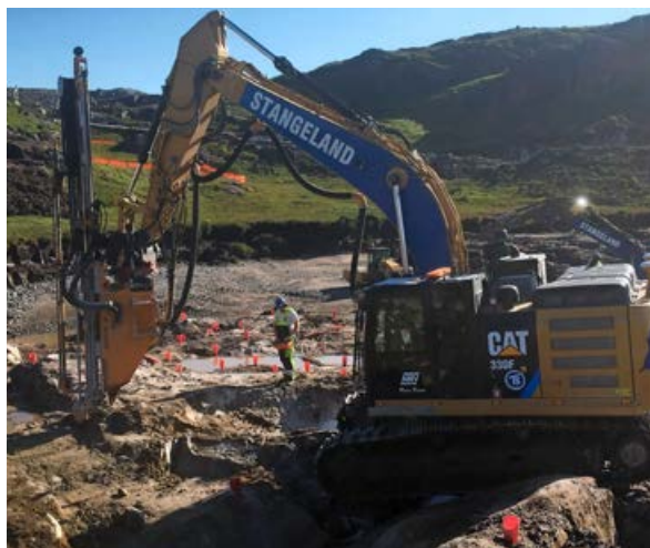
Reier Bryne i gravemaskinen med boretårn.
