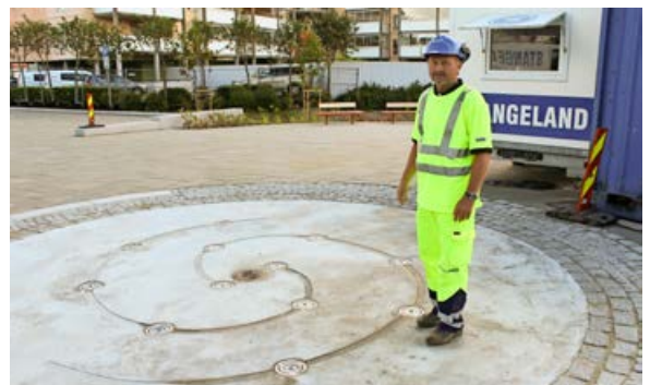
Hillevåg torg: Driftsleder Kjell Ove Helleland viser fram den avanserte vannfontenen, som har et eget teknisk rom under bakken. Vannstrålene skal kunne følge musikken som spilles på torget.
