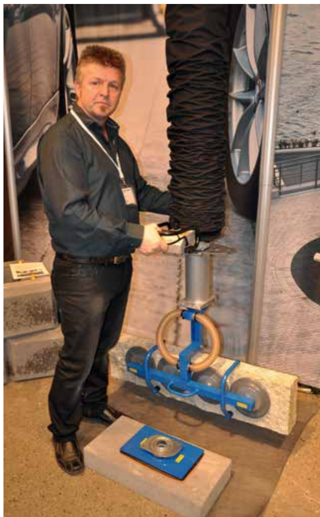
Spesialmaskin for legging av store betongheller og stor kantstein (Lintho Steinmiljø). →
