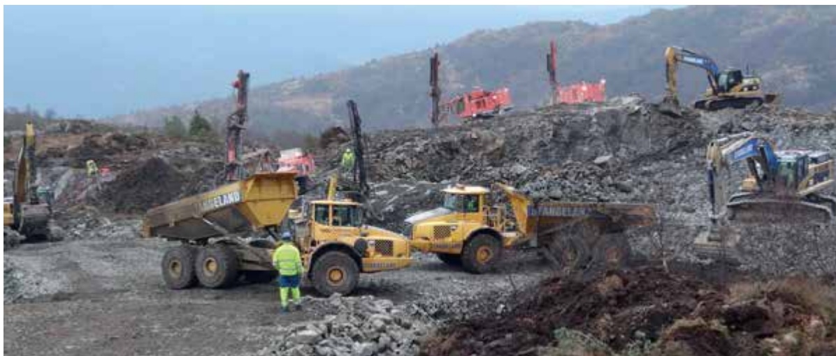
Mange maskiner på en plass, her under forseringen av trafoområdet.
