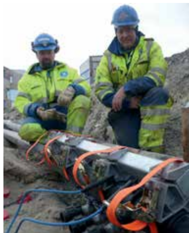
Norodd Storlid og Ove Nerland sveiser PE-rør med elektromuffer på Skadberg.
