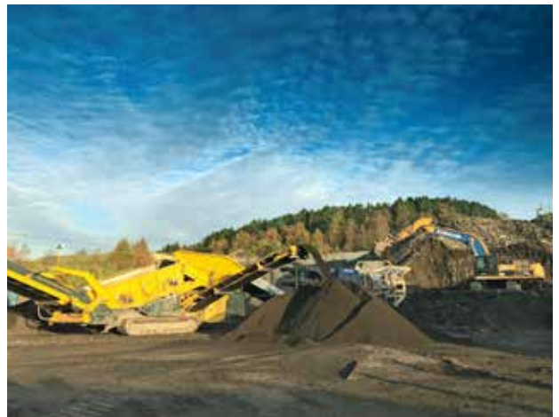
Knusing av returasfalt ned til granulat for Norstone Røyneberg. Torvald Bjørsvik i maskinen.
