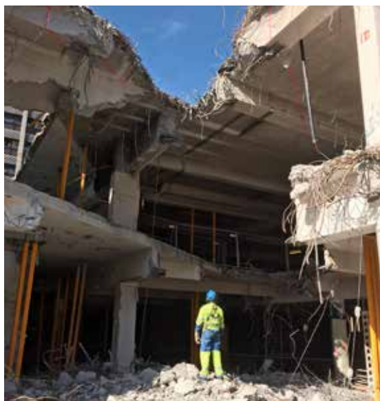
Straen Senteret: Riving av sliss med betongsaks.
