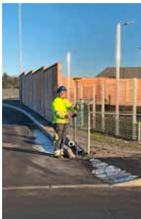
Steffen Holm måler inn utført arbeid på Rv 509 Sømmebakken.
