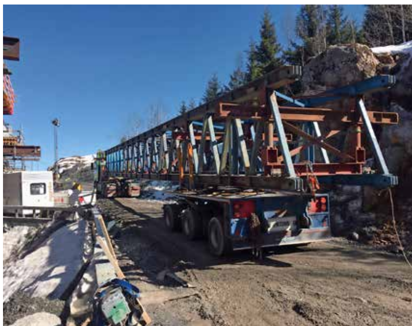
Transport av broforskaliningsbjelker i Bamble. Transport som virkelig krever sin fagmann.
