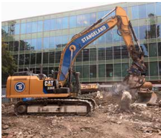
Straen Senteret. Ingvar Risa tygger opp betong før transport.
