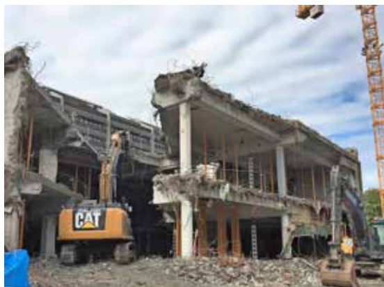
Straen Senteret i Stavanger. Riving av sliss inn i bygget. Ingvar Risa med kyndig hånd i gravemaskinen med betongsaks.
