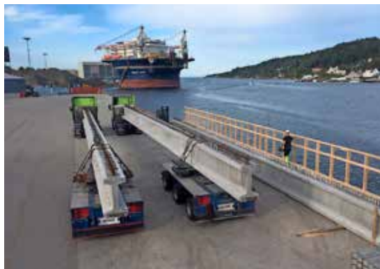
To tungtrekkere klar for transport av broelementer fra havna i Tvedestrand opp til E-18.
