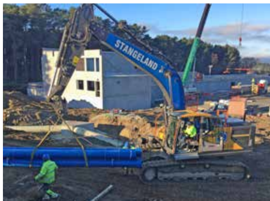
ØSTERHUS ARENA: Terje Gimre i sin Volvo gravemaskin flytter på rør tilhørende Sandnes kommune sin vannledning. Chowaniec Wojciech og Torleif Sele bistår for og ikke risikere skade på rørene.
