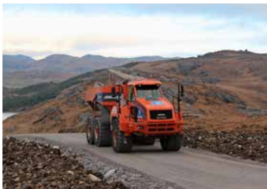
John Martin på vei for å tømme stein i Bjerkreim vindpark.
