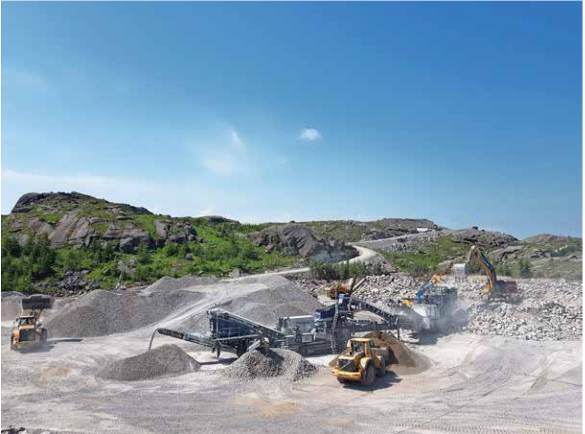
Jonsson-settet i gang på Bjerkreim vindpark. Tom Erik Rege kjører hjullasteren til venstre, Ole Aleksander Risa den til høyre. I gravemaskinen til høyre er det Kenneth Espedal som kjører og hiver i knuseren, i maskinen bak knuseren er det Hans Christian Dybing. Foto: Hans Christian Dybing
