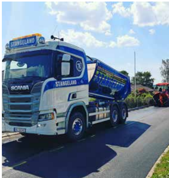
Asfaltlegging på Mariero. Foto: Reidar Håland.
