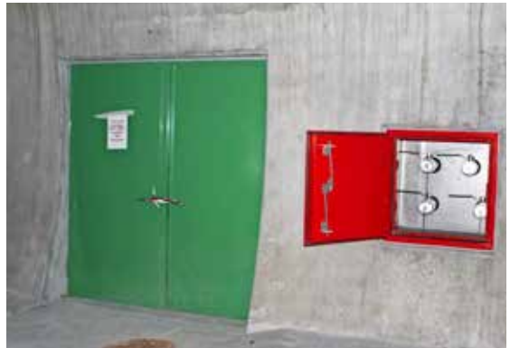
Grønn dør inn til teknisk rom og rødt brannskap.
