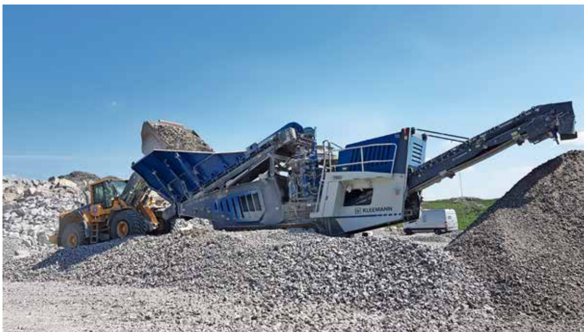
Ole Aleksander Risa i hjullasteren opererer Kleemann Mobicon på Bjerkreim vindpark, og lager grus. Foto: Hans Christian Dybing.
