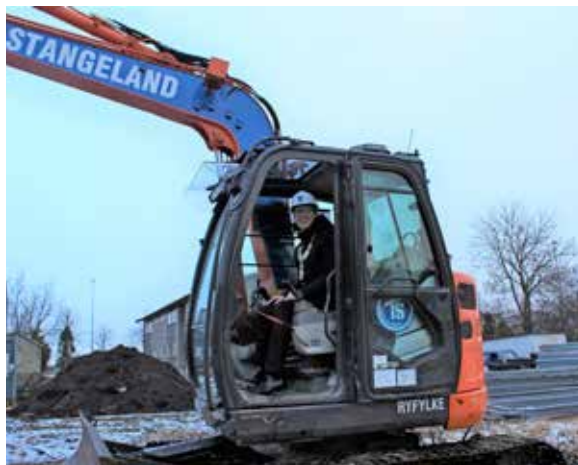
Sola sjukeheim. Ordfører i Sola kommune, Ole Ueland, tok første spadestikk med gravemaskinen.
