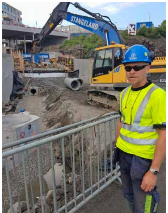
Rune Åsnes sjekker framdriften i OV- grøft i Byjordparken.
