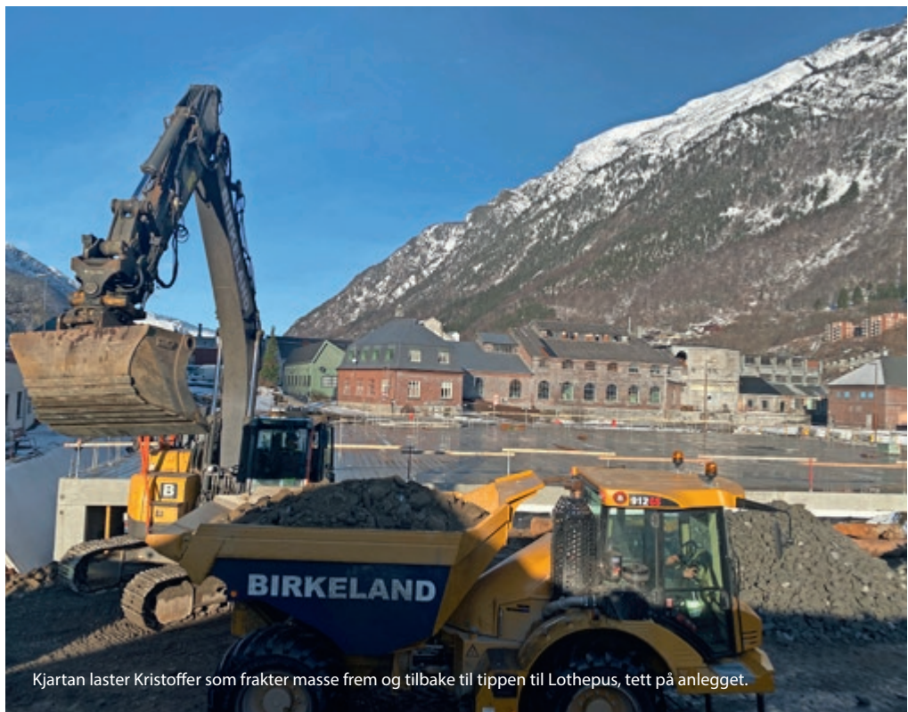
Å sikre det verneverdige Lindehuset og unngå utgliding av masse var en kritisk oppgave.
