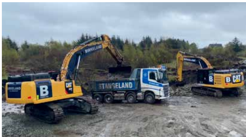
På nye Stangeland skole på Avaldsnes i Karmøy kommune skal 140.000 m 3 med myr og stein masseskiftes. Arbeidet startet i starten på mai, og skal være støypeklart innen 16. august. Det inkluderer også 1000 meter med VA anlegg.
