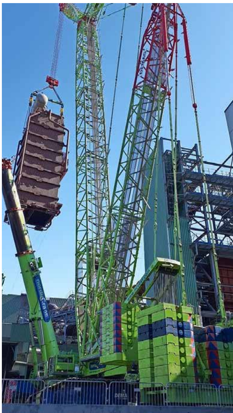
Dampkjelen på 200 tonn er vendt opp av begge kranene og løftes inn i anlegget av vår største beltekran, Demag CC3800. Hjelpekranen er en Liebherr LTM 1500 – 8.1.
