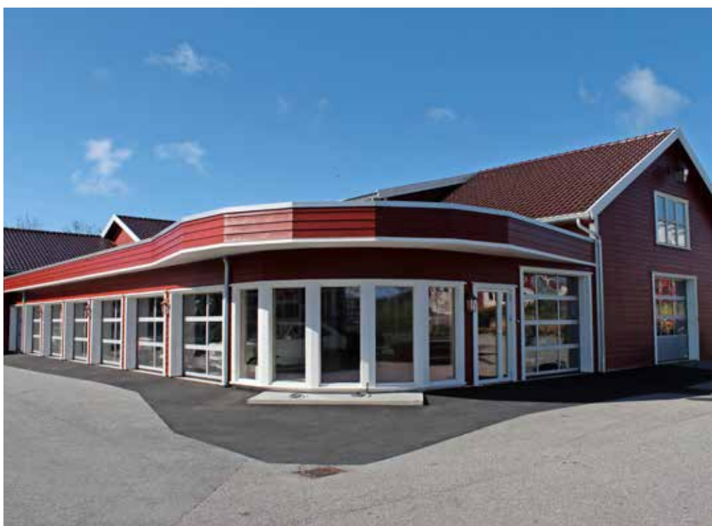
250 m 2 stort påbygg innredet som bilbutikk. Utenfor skal det monteres to Shell bensinpumper, originale fra Amerika.
