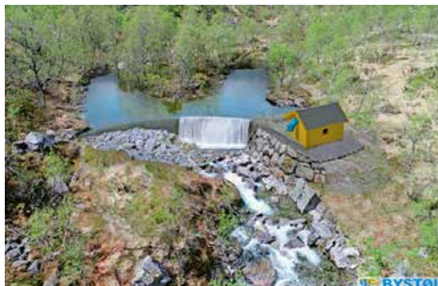
Bildet viser ferdig støpt fangdam og inntakshus. Det er Strand Forskaling som står for arbeidet og Bystøl AS som er prosjekterende.
