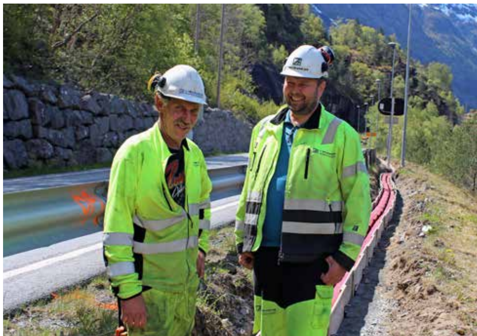
Leif-Harry Espevoll er snart ferdig med sin del av oppdraget langs E134. Bak Espevoll og Leif Brendeland er det klargjort for å støpe OPI kanaler.
