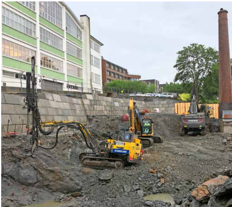
I stedet for å rørsunkte, ble det meislet og stablet 200 m 2 med løblokker.
