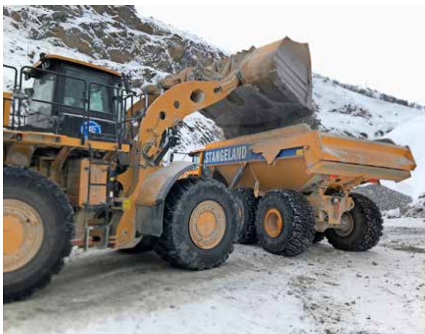
Hjullasteren Cat982 med ei 9m 3 stor skuffe laster A45 dumperen.
