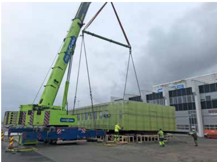
Her heiser kranfører Steffen Herland utleieriggen på plass på en treramme. Han kjører en Grove GMK 300 som er en 300 tonnns mobilkran. Bilutleie riggen er 10x25m og veier 50 tonn.
