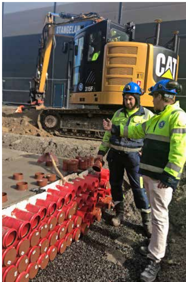
OPI er ei rørgate støpt i betong, med rørene støpt fast i et rammeverk. Her er det støpt 16 stk 4" rør. Anleggsleder Sigurd Slåtto og grunnarbeider Modestas Sukutis drøfter om dette kan være OPI-rekord i Stangeland Maskin. Bak er Simon Veland i graveren.
