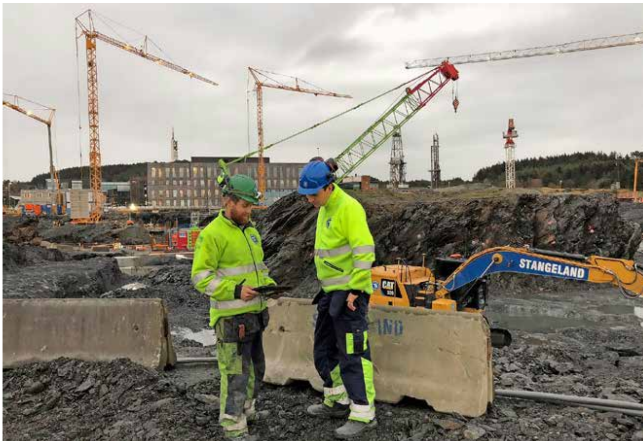
Kulverten monteres under bussvegen som går mellom bygningsmassene på tomta. Nå skal krysset monteres og Ole Andreas Sørensen og Rune Osen forbereder seg til påkobling.
