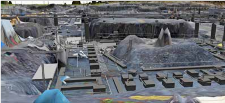
Her ser du byggegropa med betongfundament og bunnledninger. Her får man visualisert plasseringene av betongkonstruksjonen.
