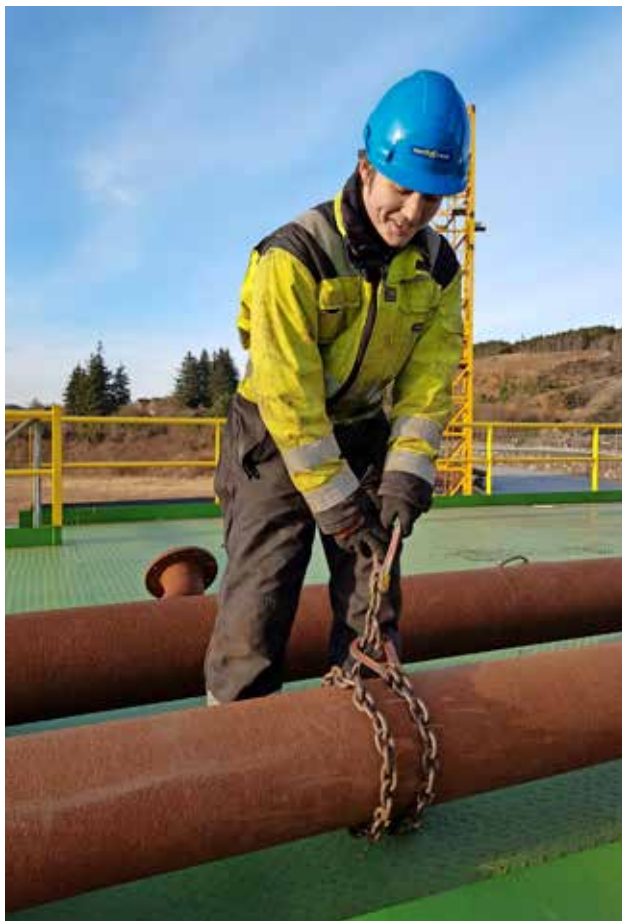
Jostein Tvedt Ingebrigtsen sjekker at kjettingen er skikkelig festet før kjettingskrevet kan hukes på.
