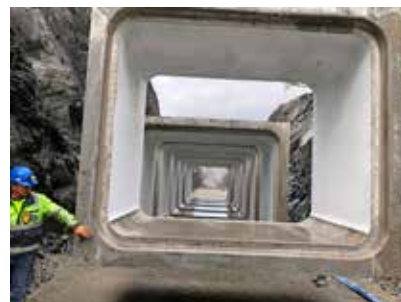
Her heises bokskulverten forsiktig på plass av Nordic Crane Vest og grunnarbeider Jan Henning Brynestad
