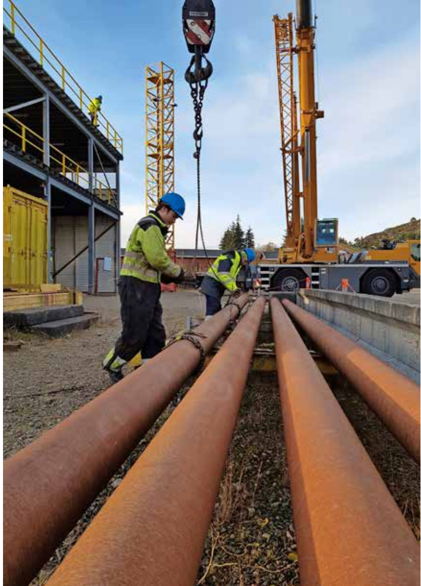
Praktisk oppkjøring på mobilkran der elevene blir testet i ulike realistiske funksjoner. Espen Vangstad kjører kran. Jostein Tvedt Ingebrigtsen og Markus Moi Håland er anhukere og signalgivere. Edvin Fenny styrer hele operasjonen via radiokommunikasjon fra toppen av riggen.
