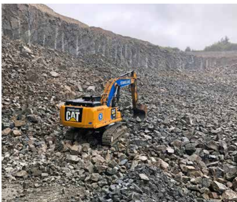
Slik ser bruddet ut etterpå. Det vil ta flere måneder før det er behov for ny sprengning
