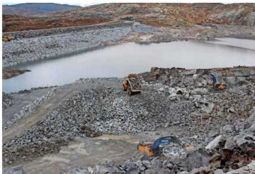
Utsikten fra toppen av steinbruddet. Dumpere og 6x6-biler mater på mellombruddet og ut til plastrere.
