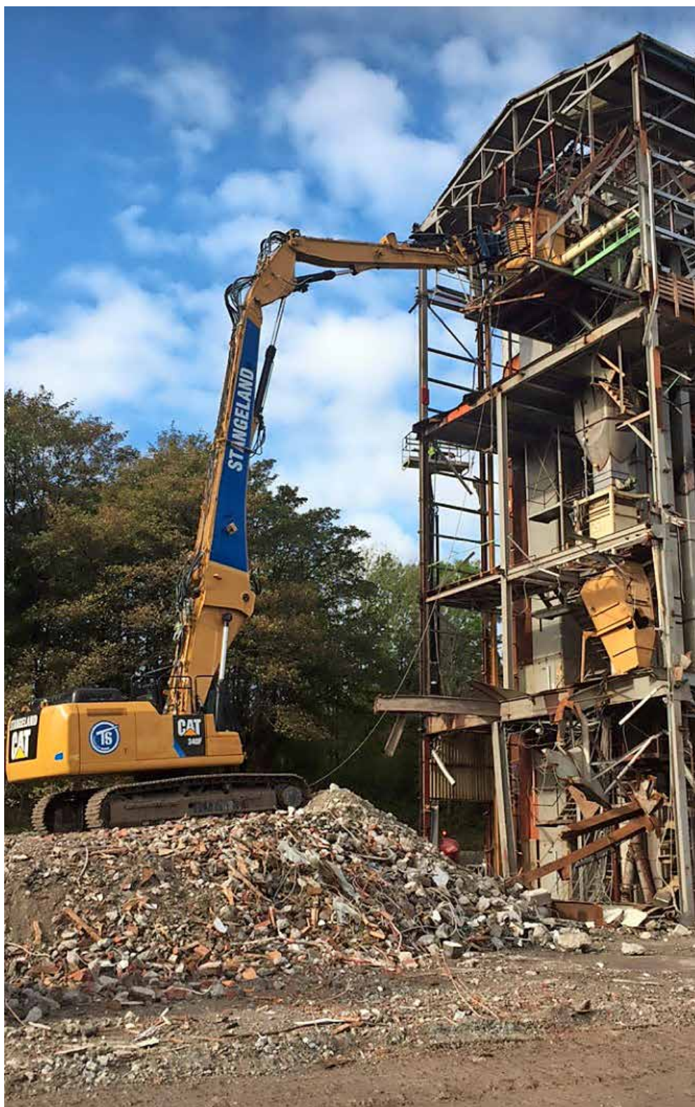
Long-Reachen med en rekkevidde på 22 meter, jafser i seg stålsiloen. Etter at elementene er løsnet med stålsaks, brukes wire til å dra ned siloene.
