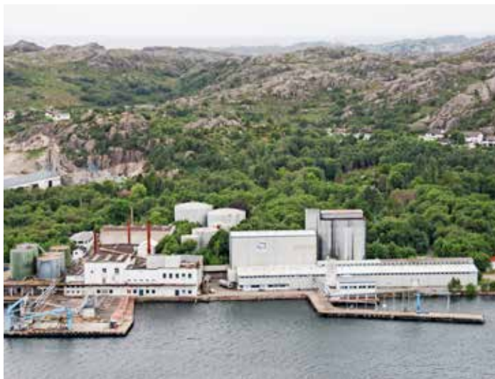
Slik så området ut før rivning. Foto: Erling Svensen, Dalane Tidende.
