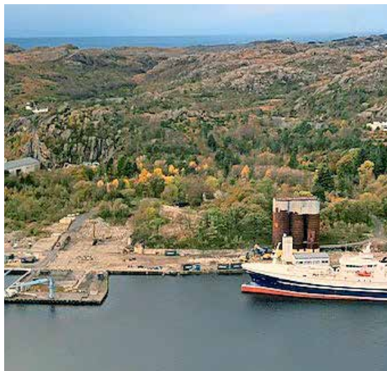
Her er det fjernet 26.000 tonn med betong og 3.600 tonn med stål.
