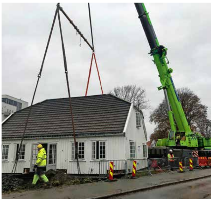
Kranfører Jan Inge Jakobsen styrer med stødig hånd løftet av det 26 tonn tunge huset fra 1803 over til midlertidig grunnmur.
