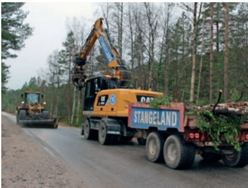
Det er viktig at vegen til enhver tid er fri for stein og mold mens arbeidet pågår. Her feier grunnarbeider Thomas Ueland etter Sander.
