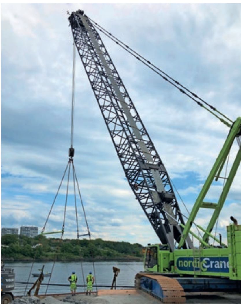
Før kranen kunne rigges, måtte det laget et fundament som tålte vekta av den 300 tonn tunge kranen. Båten som skal heves viser seg å være 70 tonn.
