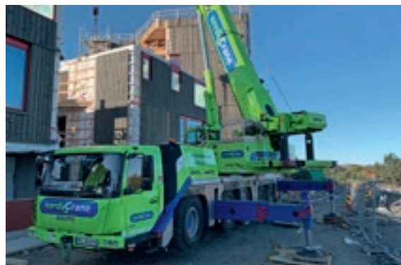
Vår nye Grove GMK 5150L, 150 tonner, står rigget klar for fjernstyring ved Husene i skogen for kunde Faber Bygg. De er som andre kunder meget godt fornøyd med å ha fleksibiliteten som kraner av denne typen gir på anleggsplassen.
