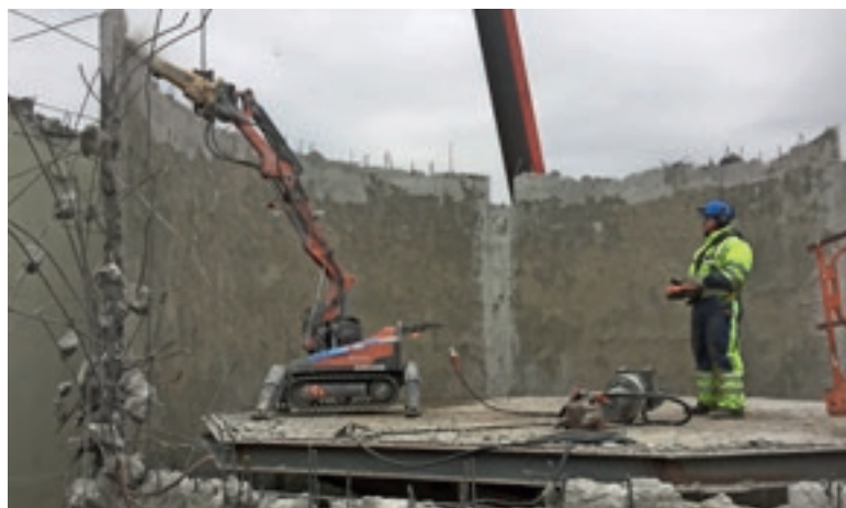
Marek Kit fjernstyrer den elektriske rivemaskinen Husqvarna DXR140.
