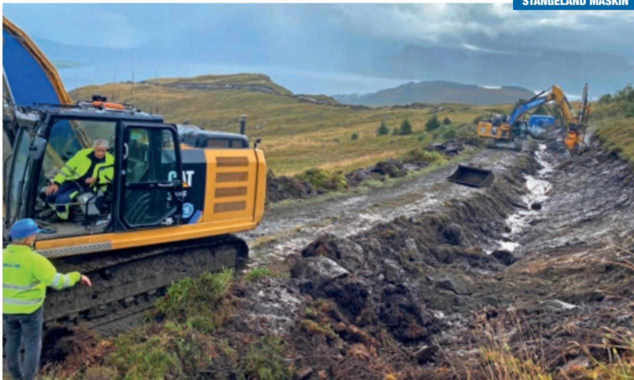
Terje M. Salte i dialog med Terje Reime. Ben Tvedt er i gravemaskin med boretårn. Den smale traktorvegen utvides for å fungere som internveg mellom turbinene.
