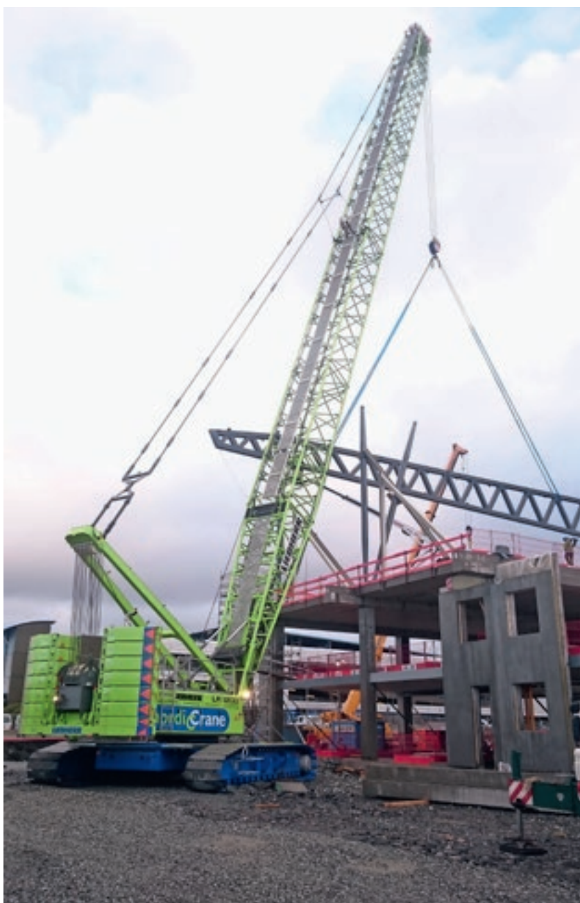
Nordic Crane Vest sin Liebherr LR1200 i monteringsarbeid. Beltekraner av denne typen kan raskt og effektivt kjøre mellom oppstillingsplassene uten assistanse fra lastebiler eller andre maskiner, og har meget stor løftekapasitet.
