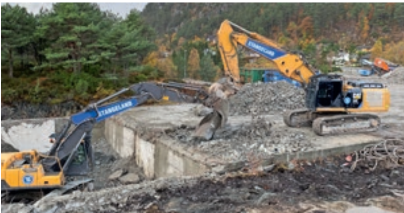
I EC250'en jobber Ola Seldal med å rive bomberommet. Her legger han biter av betong og armering opp til Eivind Berge Bryne som knuser og sorterer. Den oransje knuseren helt bak til høyre i bildet er «den lille luringen»
