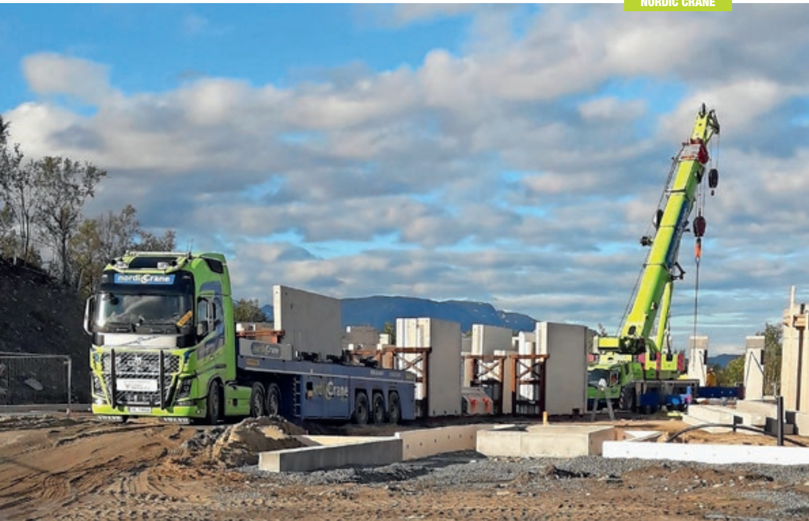
Elementene må leveres i rett rekkefølge slik at framdriften i monteringen blir rett. Foto: Arild Nilsen
