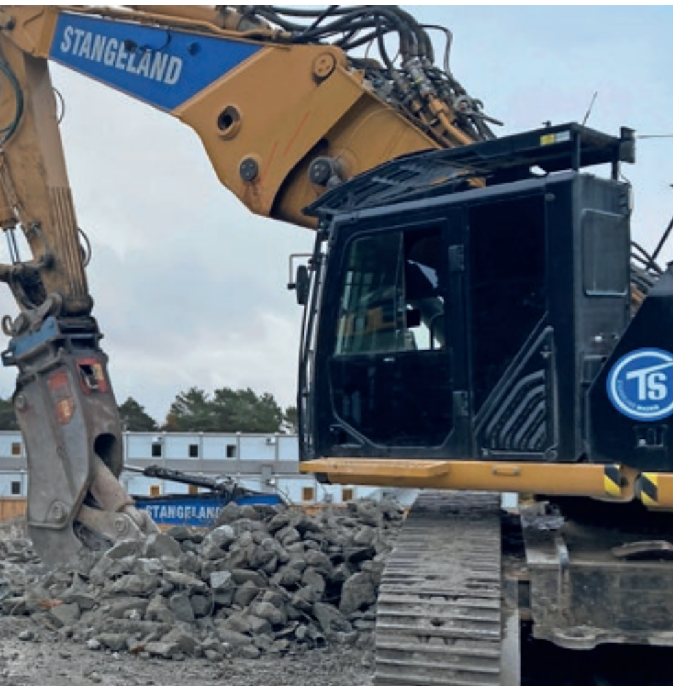
brukes som midlertidig skole mens byggingen pågår.
