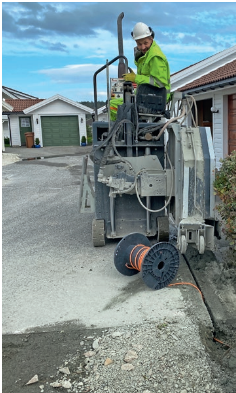
Mens maskinen sager seg gjennom asfalten og kjøres kyndig fremover, må rørene legges hurtig ned i sporet. Dette er for å unngå at veggene faller sammen.
