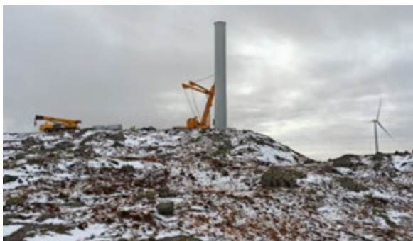
Montasje bunnseksjon med 500T kran.
