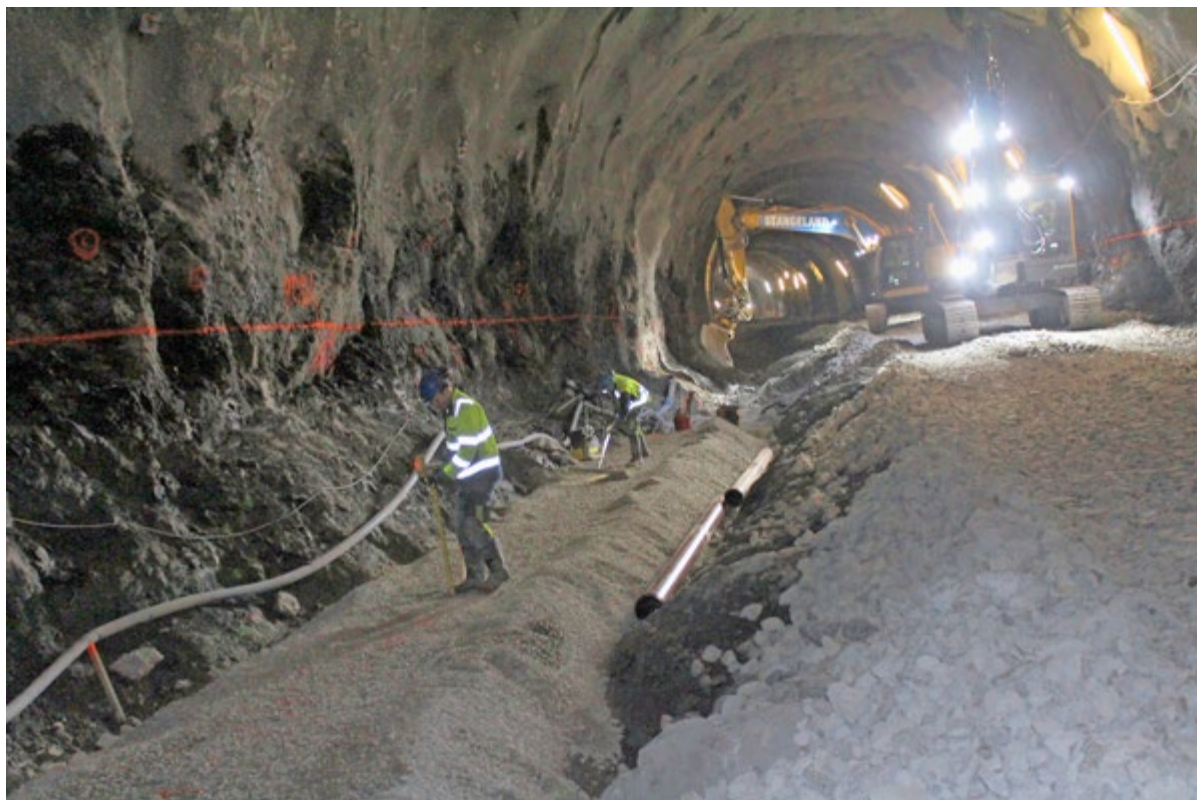
Grøftearbeid i tunnel.
