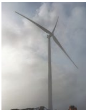
Første komplette vindmølle ferdigstilt på fundament T1-05 natt til torsdag 16. mars.
