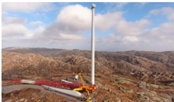
«Perfekte» forhold, men dessverre for mye vind. Hovedkranen er begrenset til arbeider under 6 s/m vind.
