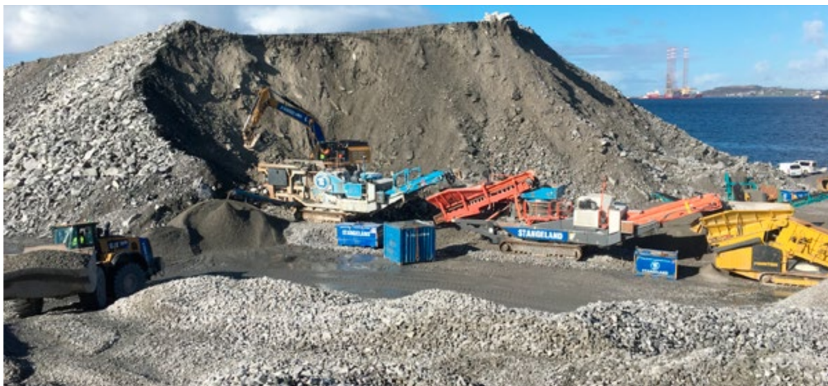
Hundvåg: Ole Aleksander Risa i hjullaster og Kenneth Tjora i gravemaskin, knuser tunellmasser for m3-anlegg.
