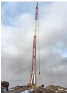
Montasje av vindmølle på fundament T1-04. Hovedkranen er 750T, i forkant kan en se hjelpekranen som er på 200T.
