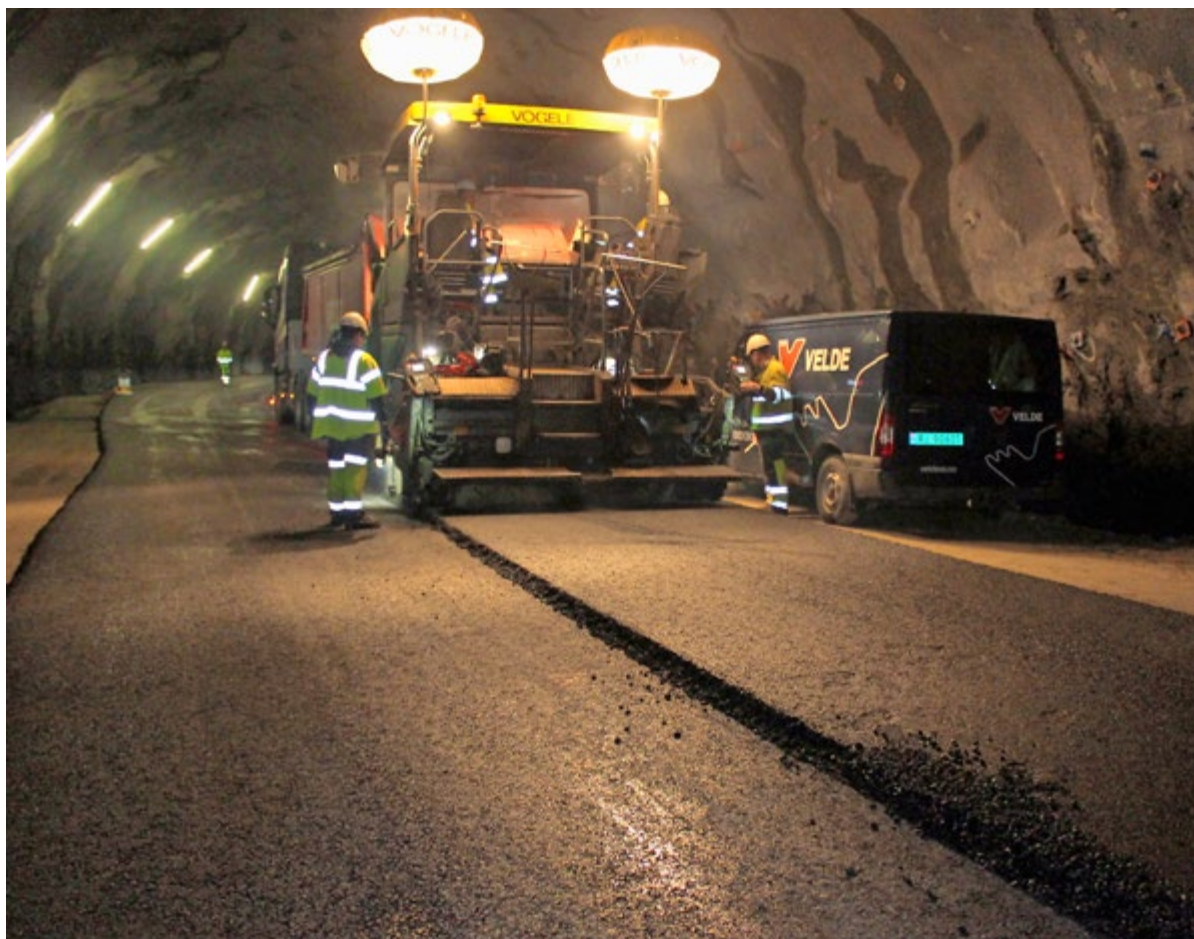
Vi har Velde med oss på asfaltering.
