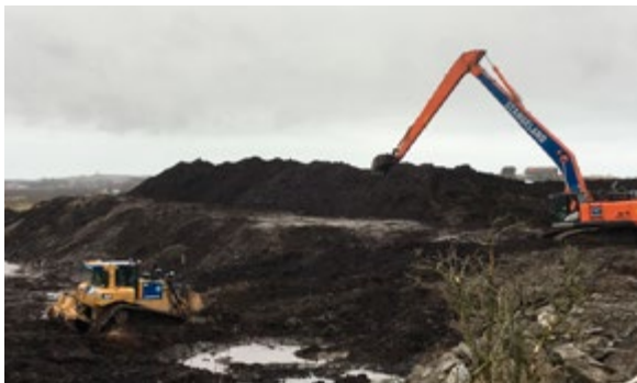
Tipp Grasrota: Johnny Rene Helleland doser jord til Gaute Håland som lempet den opp på trauret til ferdig utlagt tipp.
