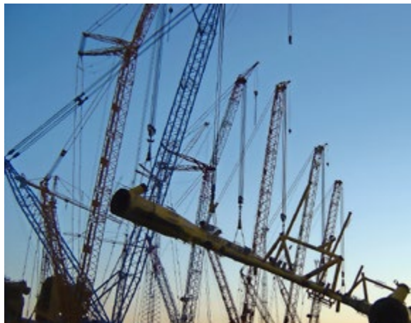
Kværner Verdal i arbeid for Johan Sverdrup prosjektet. (Foto: Kværner Verdal)
